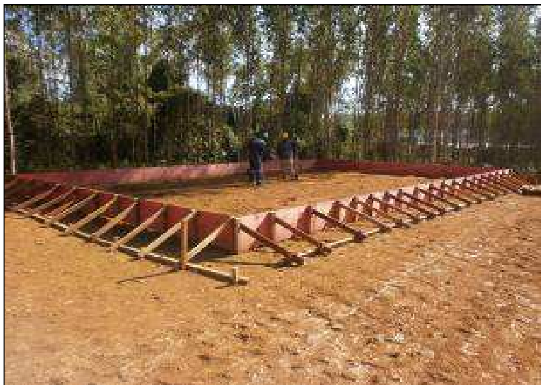
Foto 22 – Construção das bases da Estação de Tratamento de Água (ETA).
