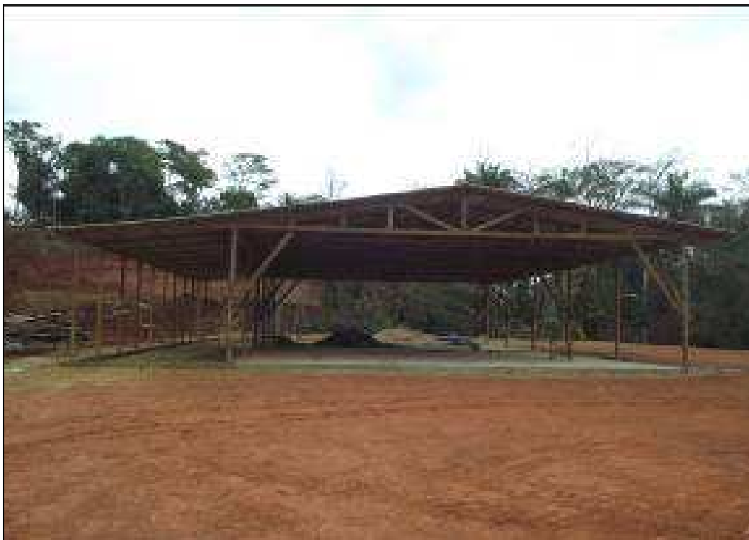
Foto 30 – Central de Carpintaria em execução.
