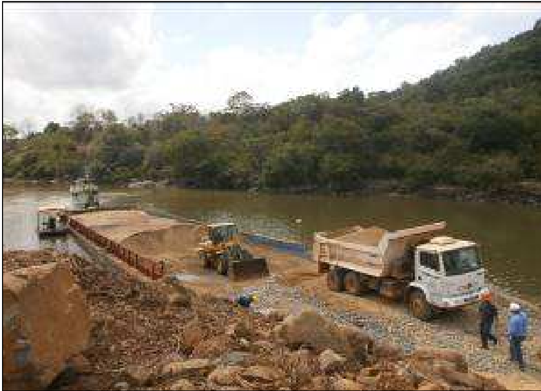
Foto 43 – Dragagem de areia na fundação da ensecadeira F.
