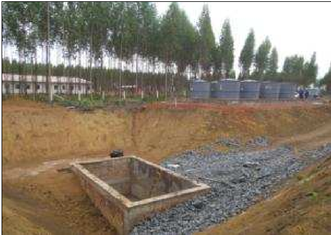
Foto 21 – Instalação do sistema Estação de Tratamento de Efluentes.
