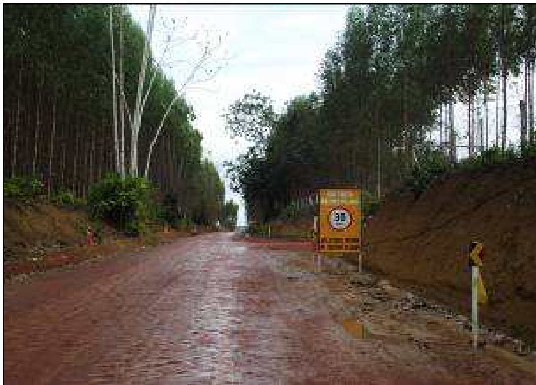
Foto 08 – Acesso interno à obra.
