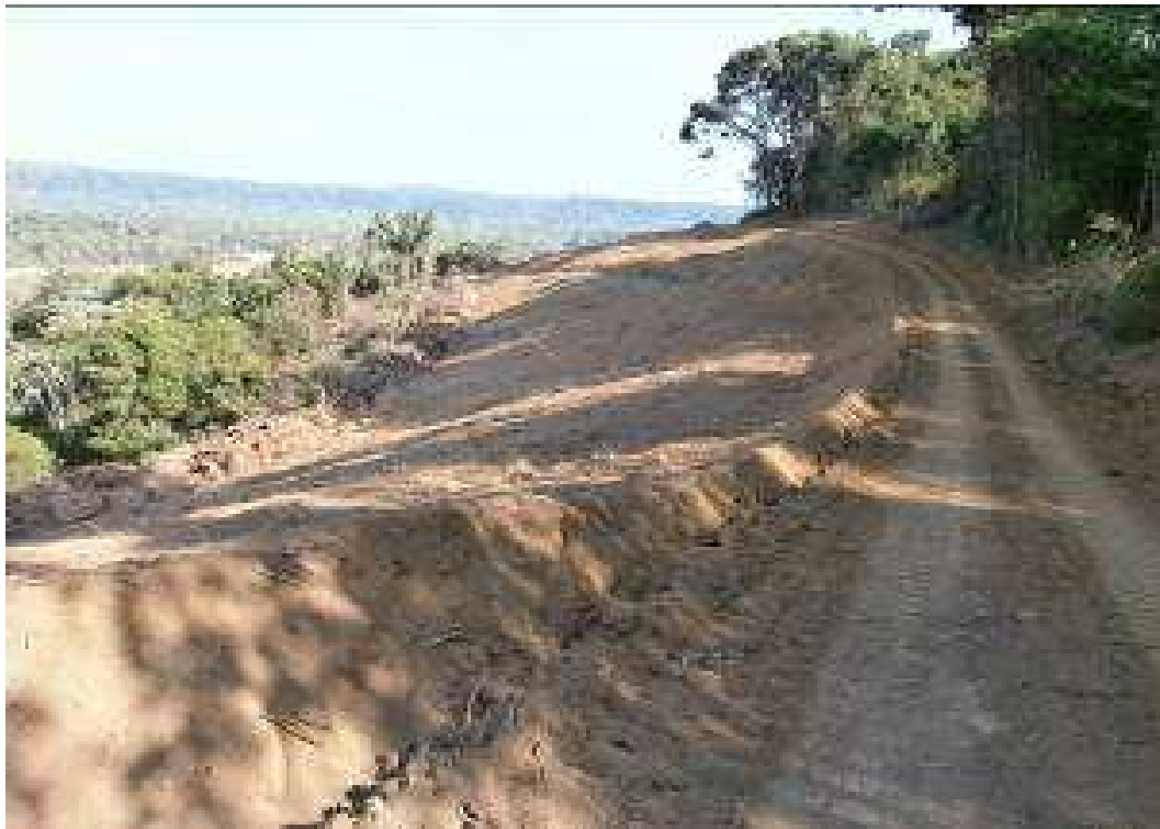
Foto 07 – Vista da abertura do acesso definitivo da obra.
