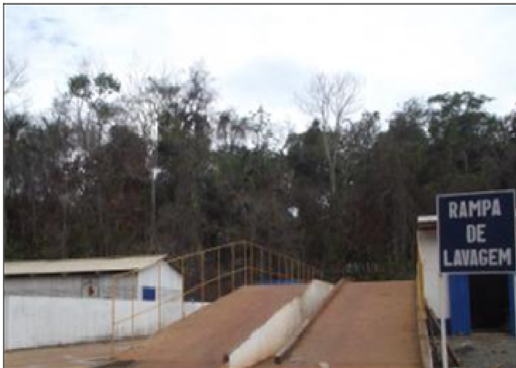
Foto 32 – Visão das instalações da Rampa de Lavagem.
