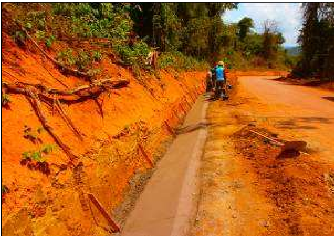
Foto 14 – Construção do sistema de drenagem no acesso provisório.
