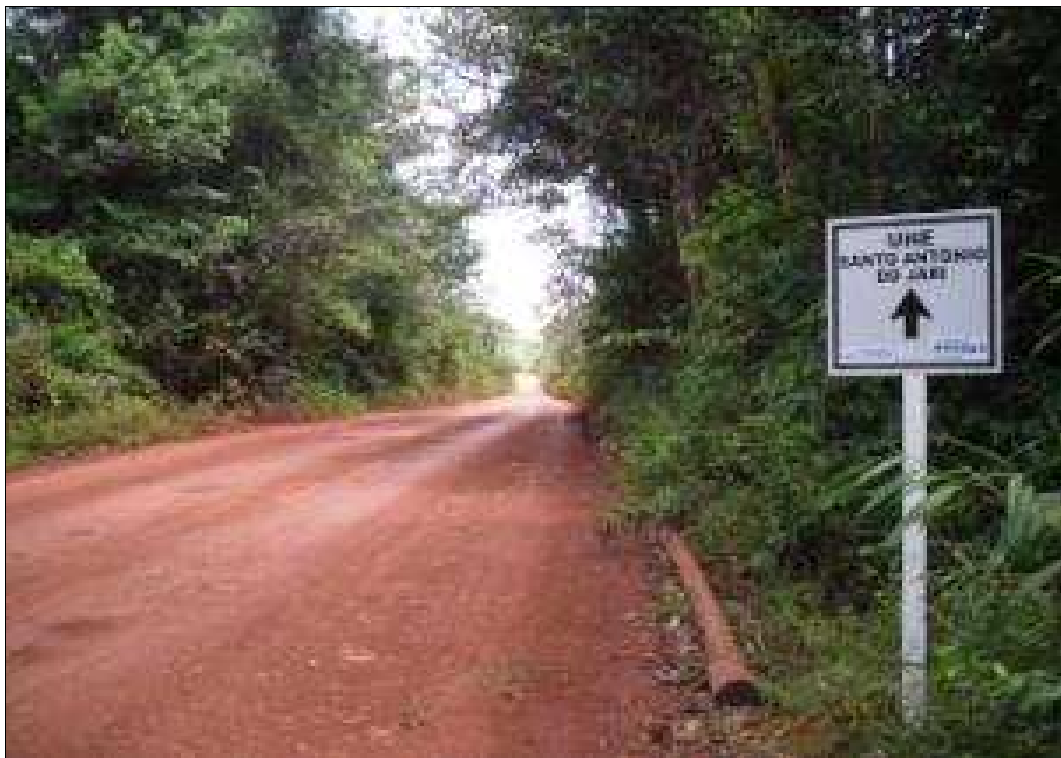
Foto 02 – Acesso externo à obra.
