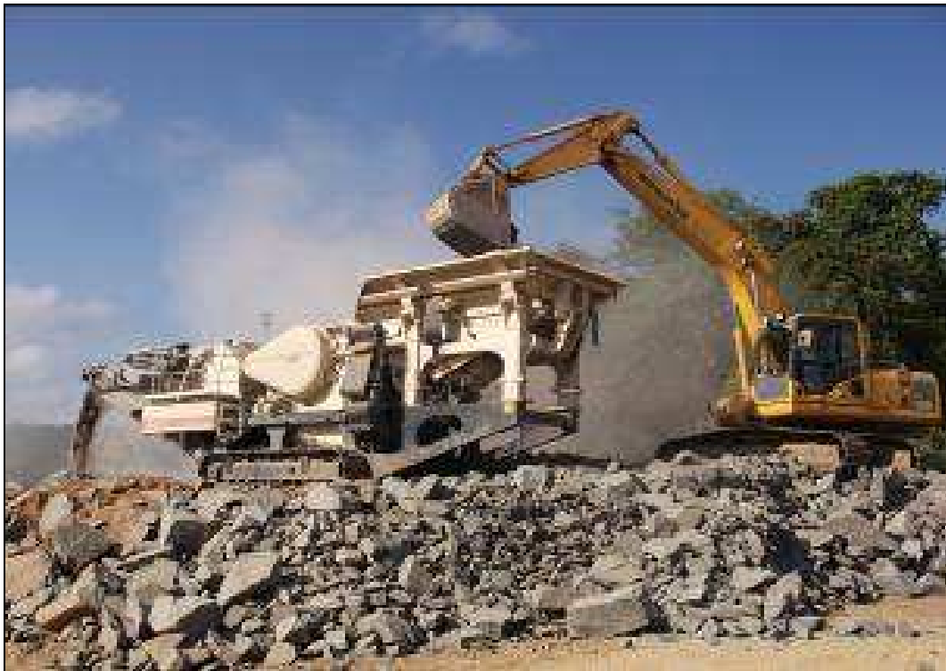
Foto 37 – Mobilização de britador móvel.
