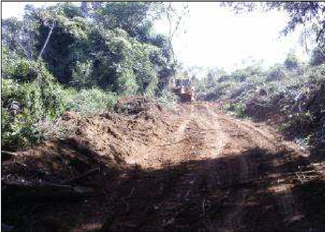
Foto 03 – Abertura do acesso provisório da obra.
