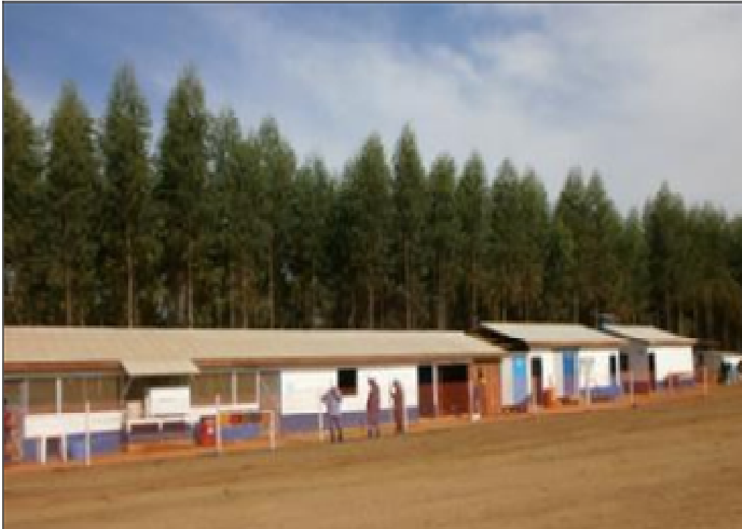
Foto 29 – Visão das instalações do canteiro provisório.
