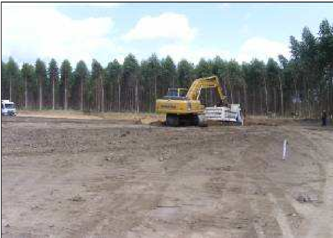
Foto 04 – Início das escavações na área do canteiro administrativo.
