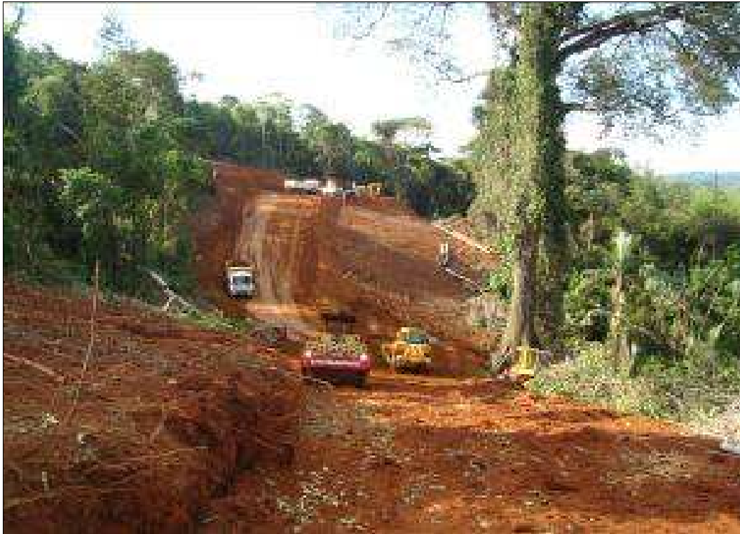
Foto 05 – Implantação do acesso provisório.
