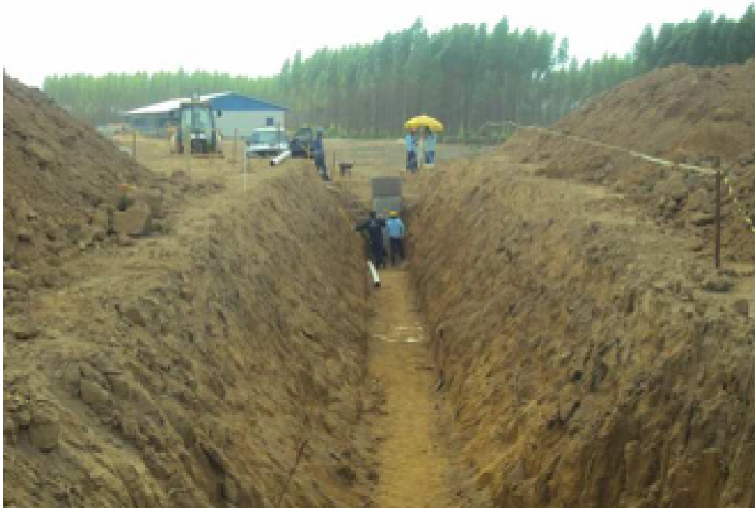
Foto 13 – Execução do sistema de drenagem no canteiro administrativo.
