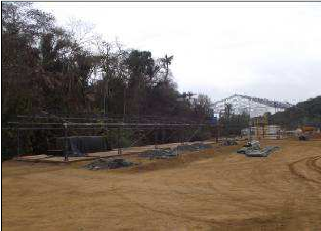
Foto 31 – Visão das instalações do almoxarifado e oficina mecânica.
