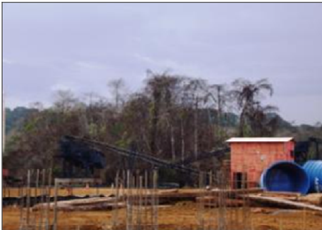
Foto 38 – Em andamento as instalações da Central de Britagem.
