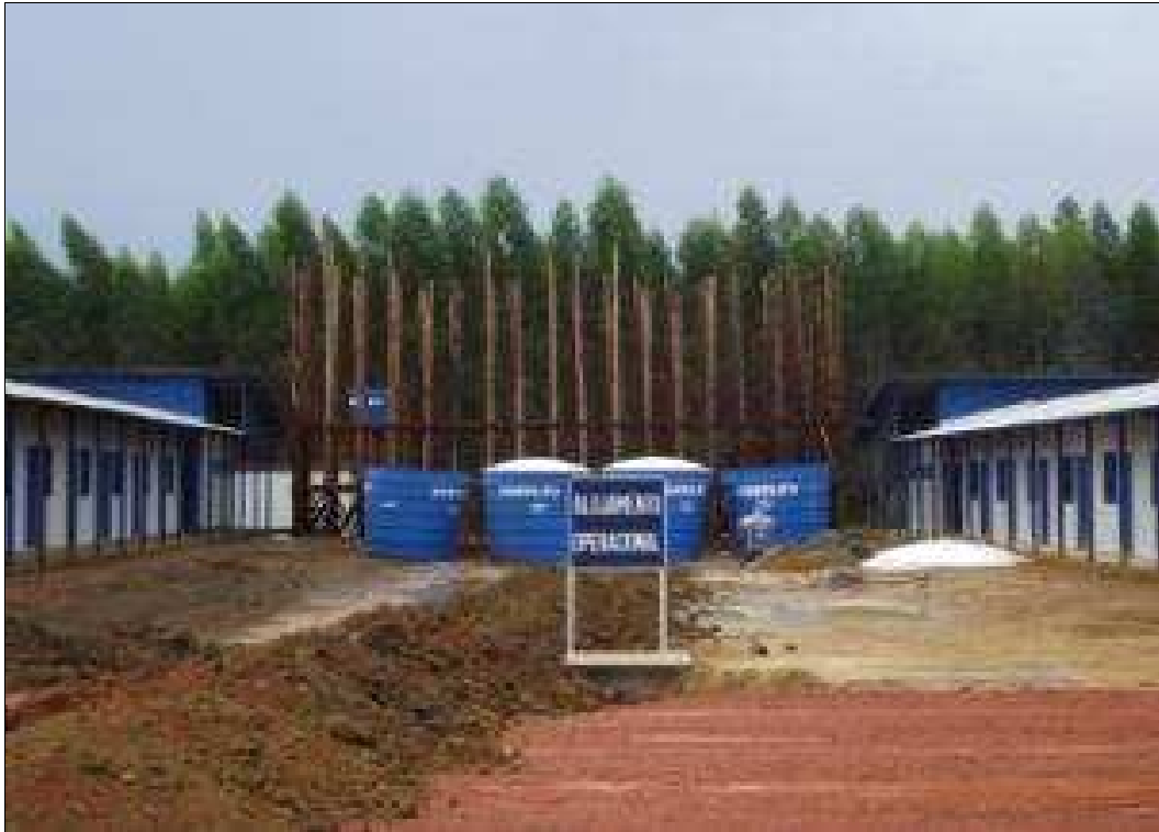
Foto 27 – Instalações das caixas d'água na área dos alojamentos.
