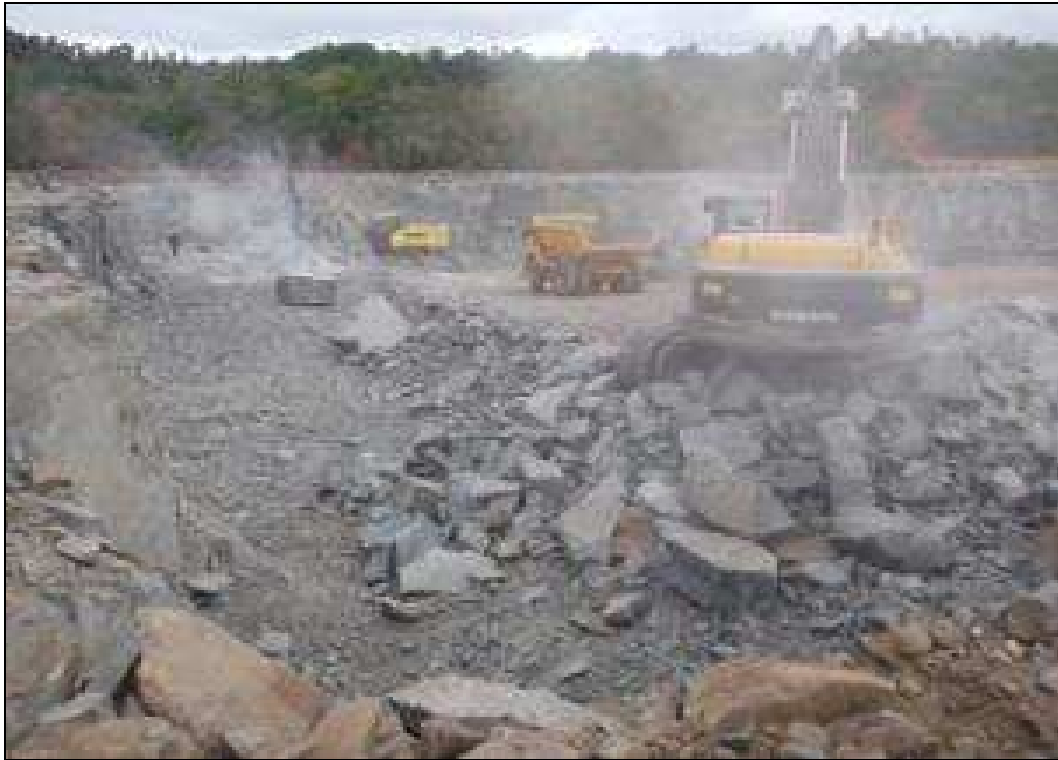
Foto 49 – Desmonte de rocha na área da pedreira.
