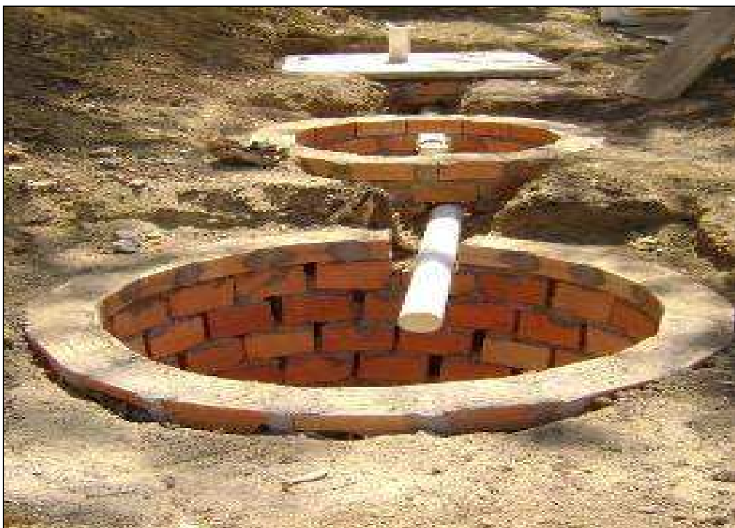
Foto 36 – Sistema fossa, filtro e sumidouro – Portaria.
