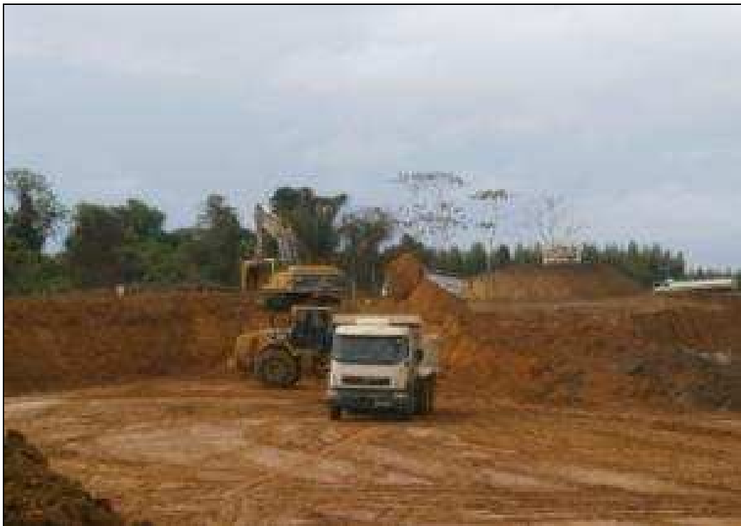
Foto 40 – Área de empréstimo de argila.
