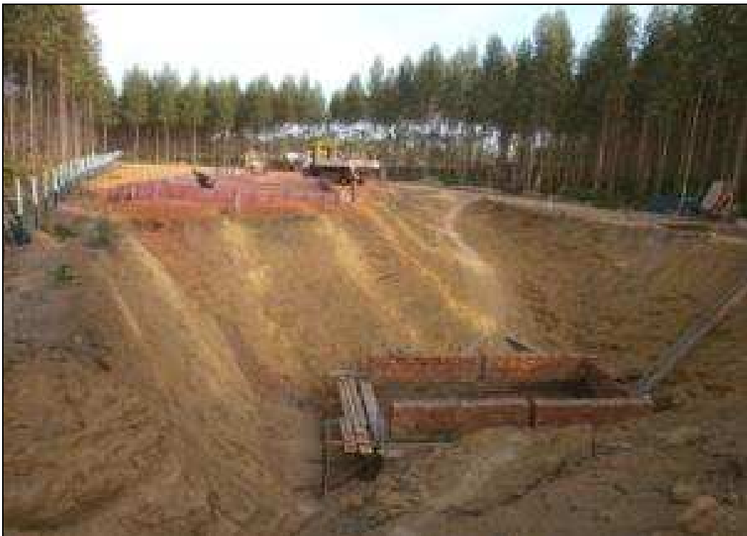
Foto 20 – Construção do sistema da ETE.
