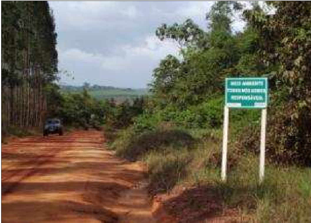
Foto 01 – Sinalização do acesso externo à obra.
