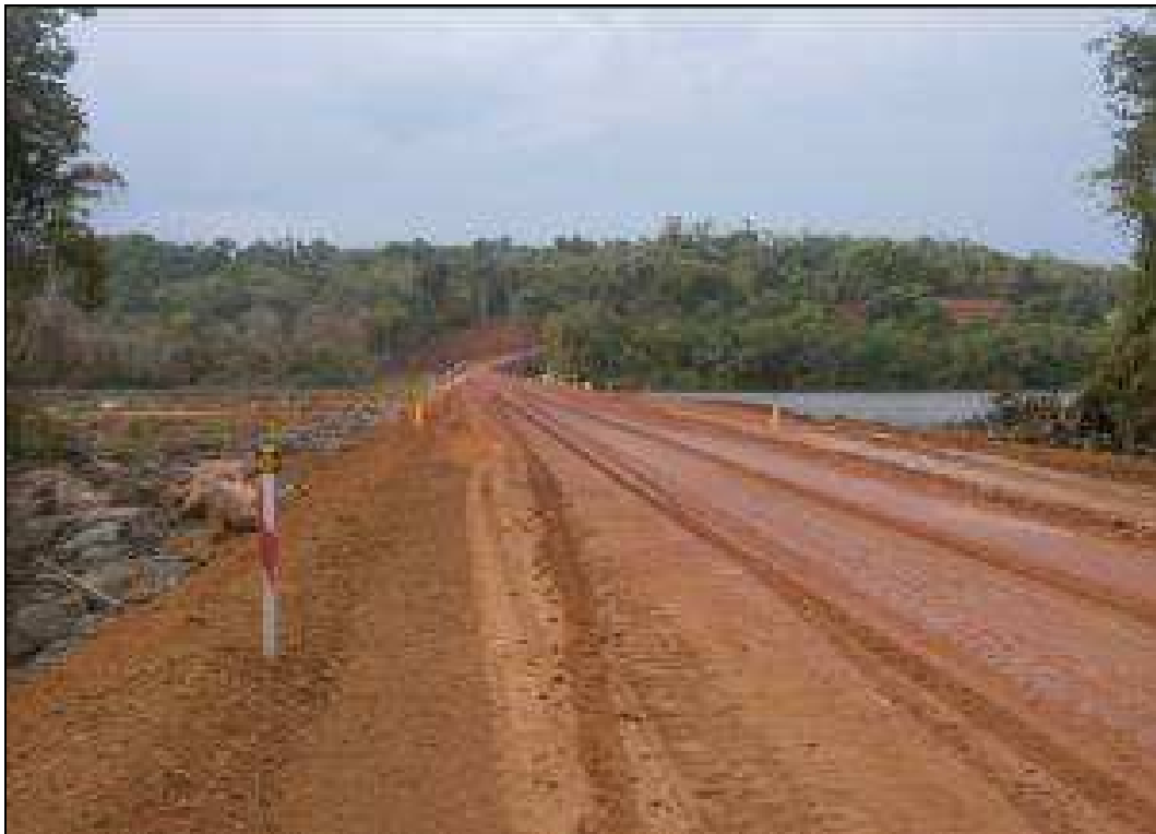
Foto 06 – Acesso provisório, ensecadeira D.
