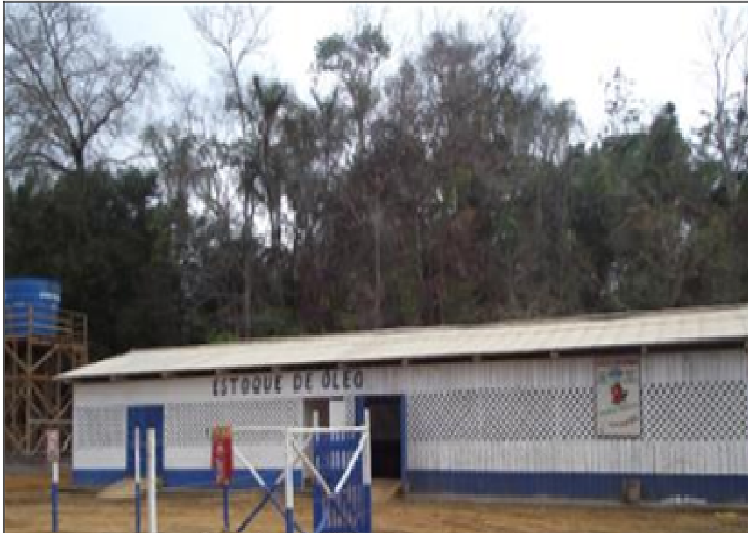
Foto 33 – Depósito de óleo em pleno funcionamento.
