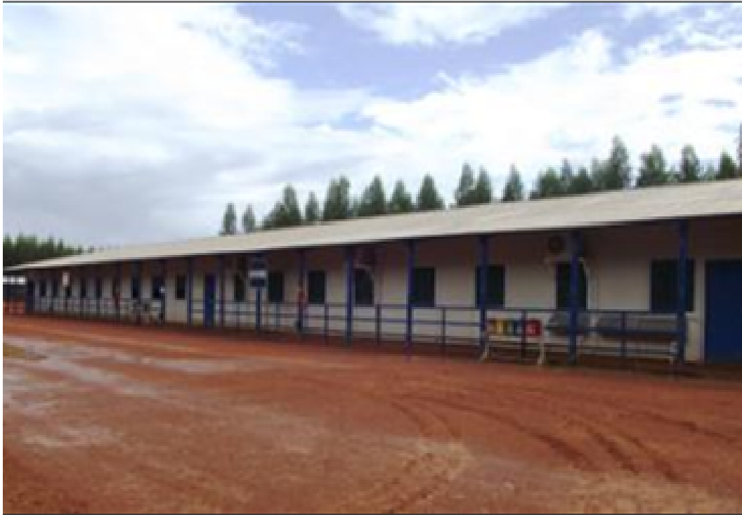
Foto 19 – Instalações concluídas do Refeitório.
