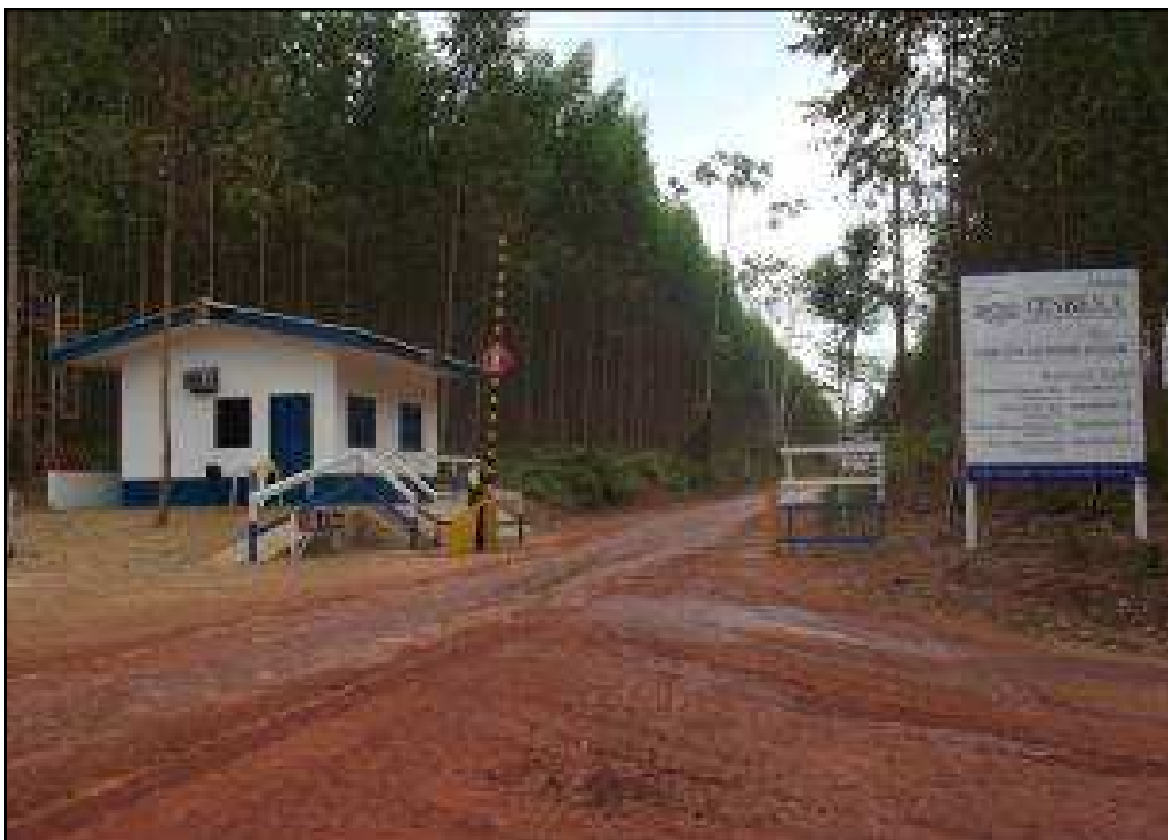
Foto 28 – Portaria principal do canteiro de obras.
