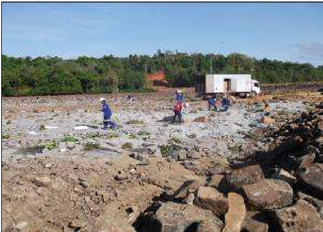
Foto 48 – Colocação de explosivos na área da Pedreira.
