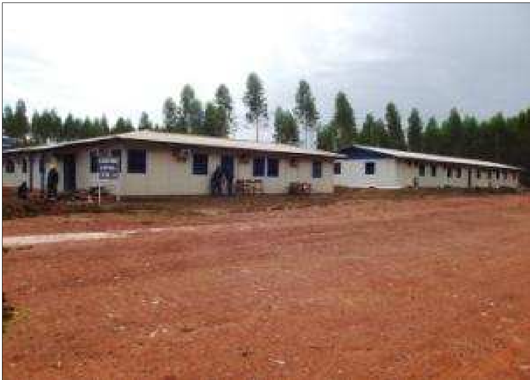
Foto 18 – Etapa de conclusão das estruturas dos escritórios administrativos.
