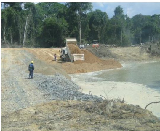
Processo de selamento da ensecadeira F.
