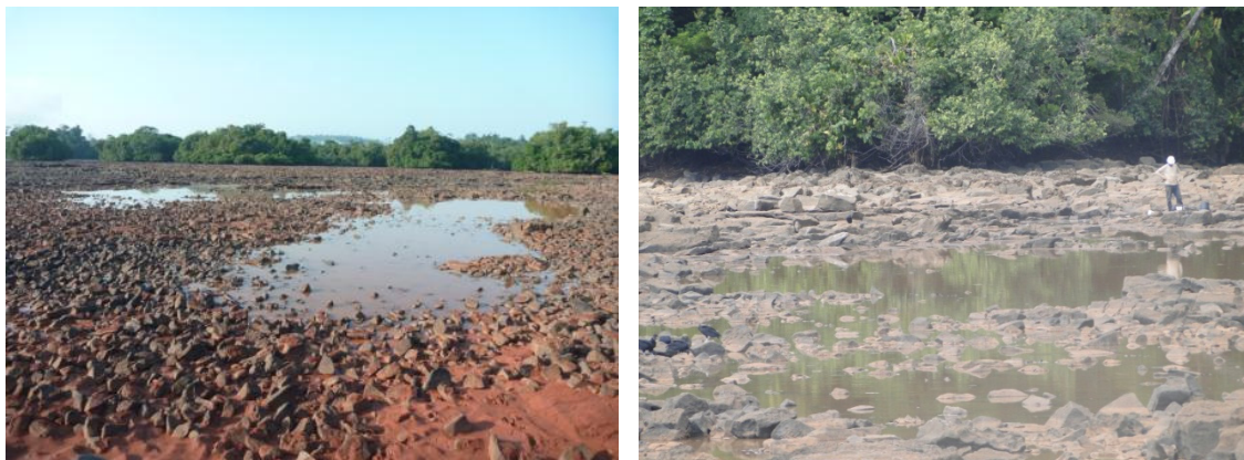
Detalhe das poças formadas ao longo do trecho ensecado pela ensecadeira C1.
