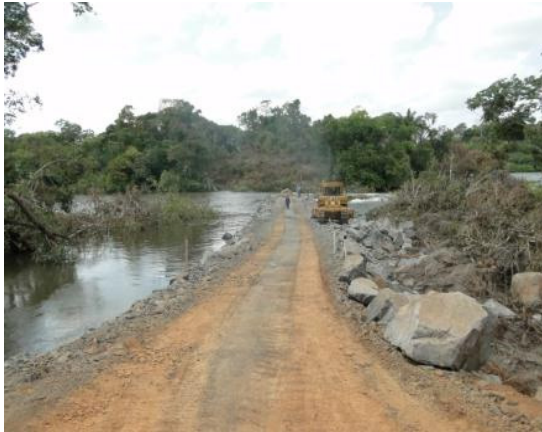
Processo de lançamento da ensecadeira D.
