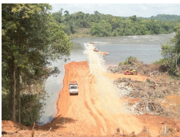
Processo de selamento da ensecadeira C1.
