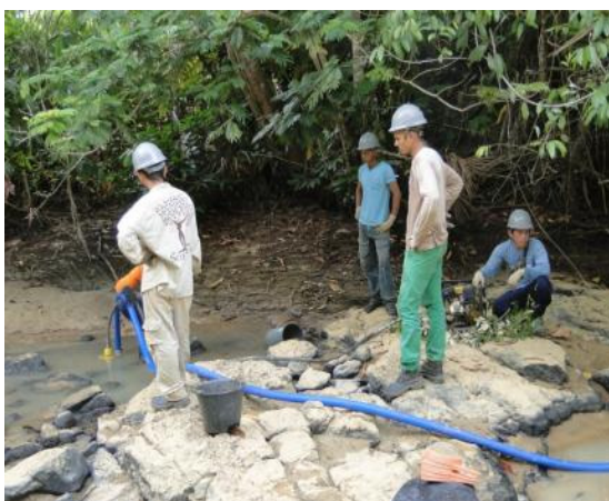
Detalhe do bombeamento dos poços formados ao longo do trecho ensecado pela ensecadeira D
