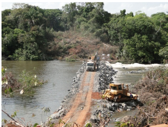
Processo de lançamento da ensecadeira C2
