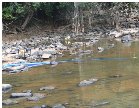
Detalhe do bombeamento dos poços formados ao longo do trecho ensecado pela ensecadeira D
