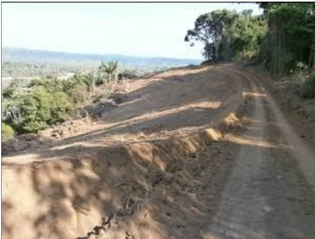
Foto 34 – Abertura do acesso definitivo – ASV nº 574/2011.
