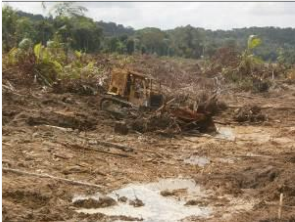
Foto 31 – Procedimento de destoca nas áreas com limpeza concluída - ASV nº 566/2011.
