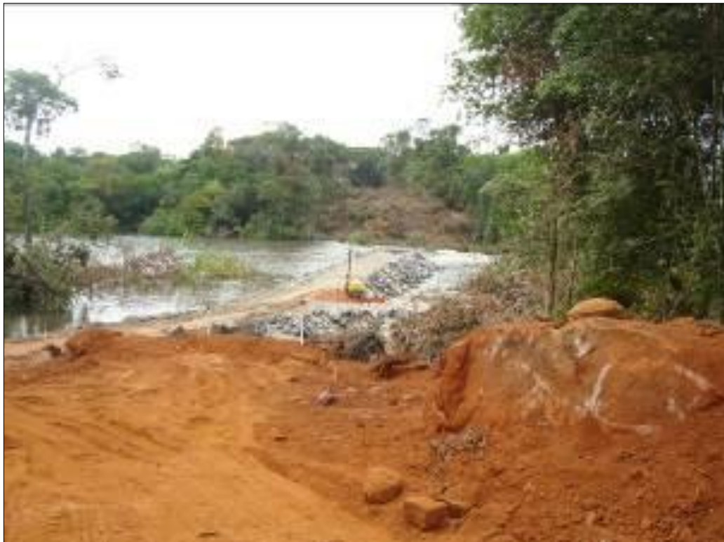
Foto 19 – Início da implantação da enseadeira C2.
