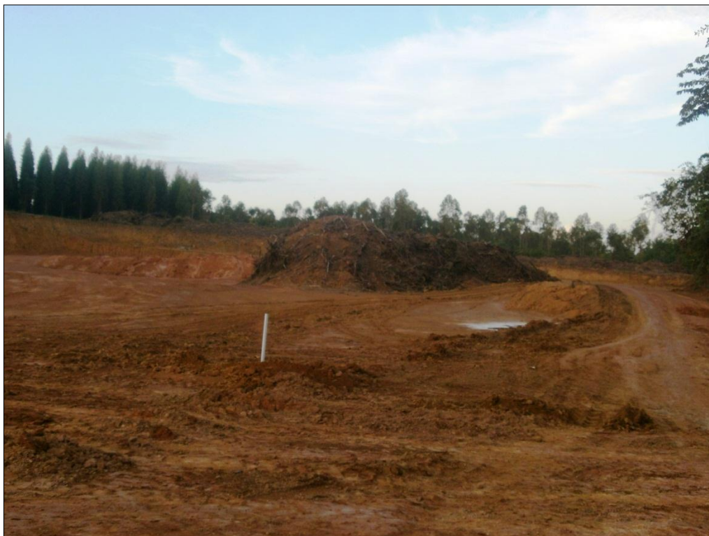
Foto 23 – Material vegetal estocado na área de empréstimo de argila.
