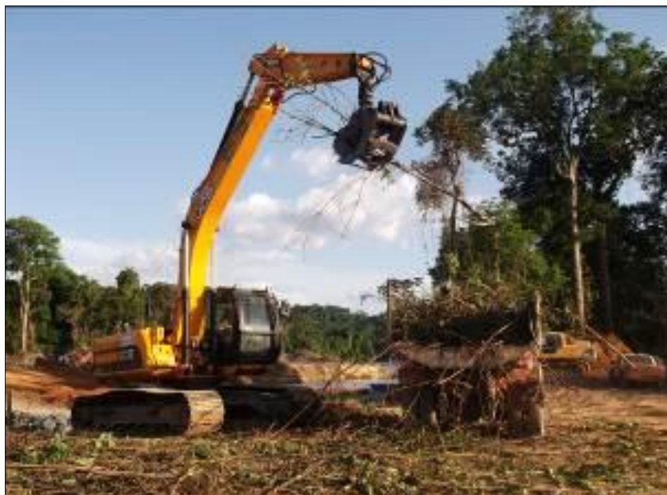
Foto 32 – Carregamento e transporte de galhadas na margem direita hidráulica – ASV nº 566/2011.
