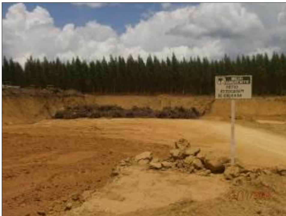
Foto 22 – Área de emprestimo utilizada para o depósito dos restos das galhadas.
