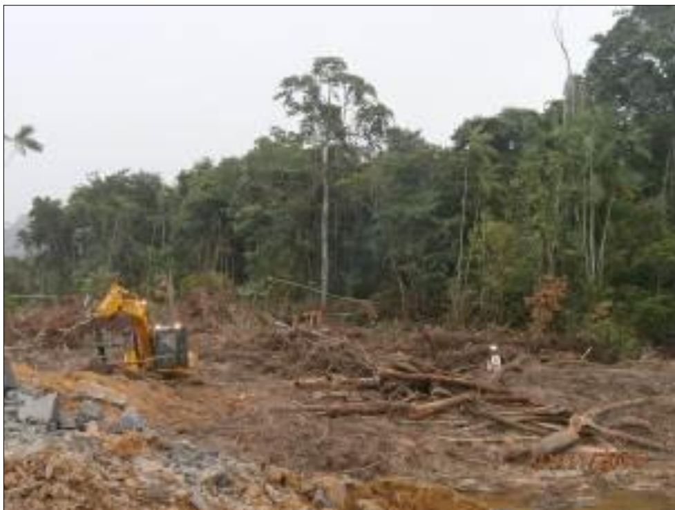
Foto 30 – Empilhamento das madeiras e destoca - ASV nº 566/2011.
