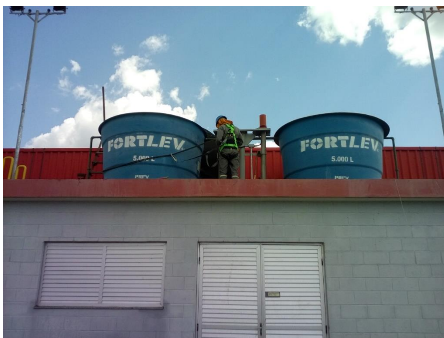
Imagem 3.3.27-19: Realização da limpeza na caixa d'água
