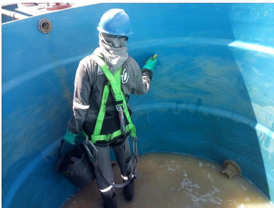
Imagem 3.3.27-18: Lavagem da caixa d'água onde é armazenada a água tratada na ETA
