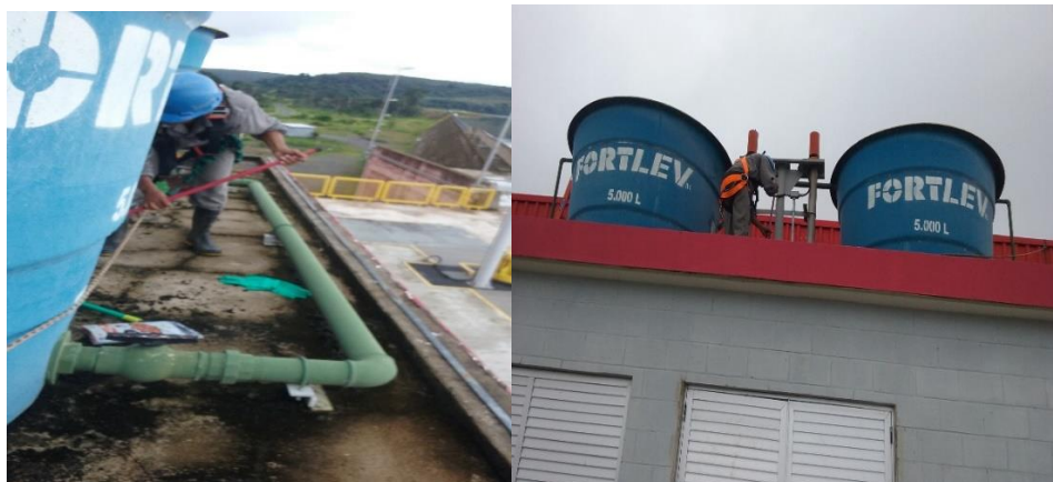
Imagem 3.3.27-20: Realização da limpeza na caixa d'água
