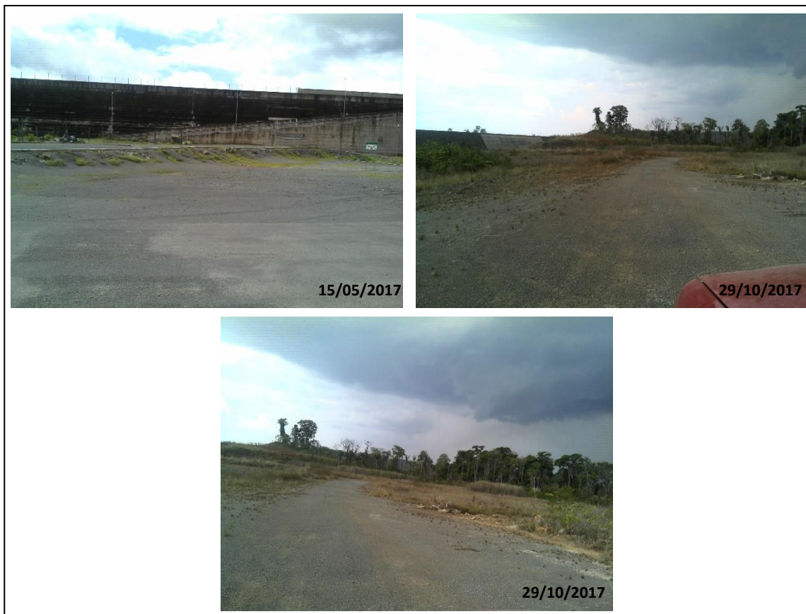
Figura 36. Novo canteiro de obras.
