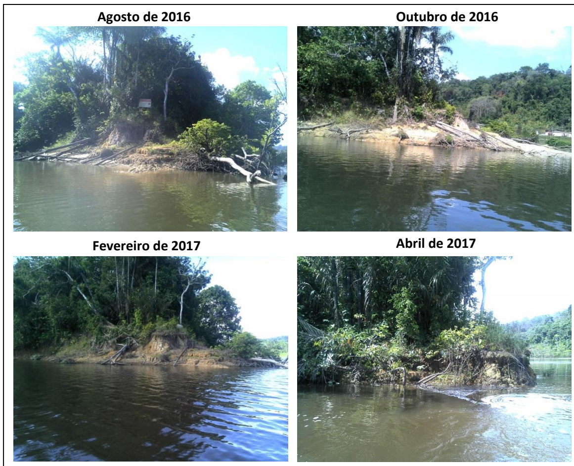
Figura 10. Ponto MJE-08 no Trecho erosivo do Canal Intermediário nas campanhas de agosto e outubro de 2016, e fevereiro e abril de 2017.
