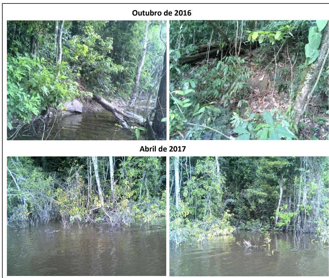
Figura 22. Ponto P6-D em outubro de 2016 e abril de 2017. Observou-se estabilidade de toda a encosta marginal nas proximidades do ponto monitorado.
