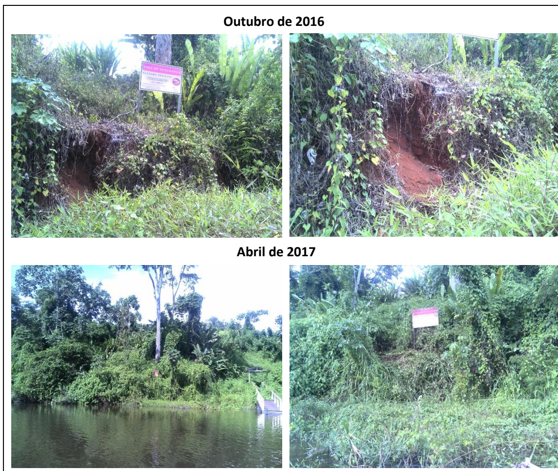
Figura 16. Ponto P1-E. Margem do reservatório em outubro de 2016 e abril de 2017.
