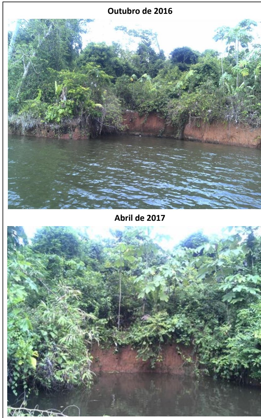
Figura 28. Ponto MM1-D. Antiga área escavada com talude marginal exposto em outubro de 2016 e abril de 2017.
