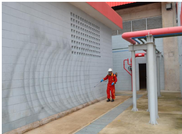
3.3.27-11: Dedetização das áreas de apoio a operação da usina
