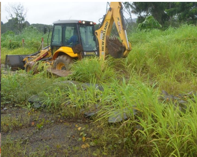
Imagem 3.3.27-32: Maquinário retirando a fossa
