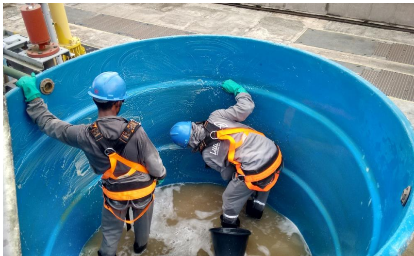
Imagem 3.3.27-25: Realização da limpeza na caixa d'água
