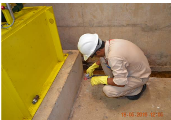
3.3.27-14: Dedetização na casa de máquinas da usina
