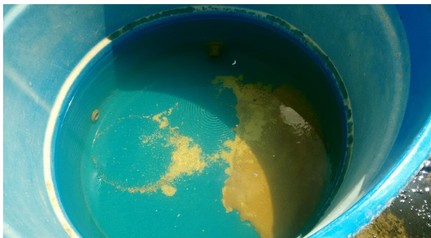
Imagem 3.3.27-22: caixa d'água onde é armazenada a água tratada na ETA
