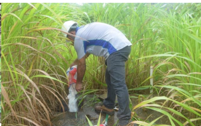
Imagem 3.3.27-30: Limpeza da fossa
