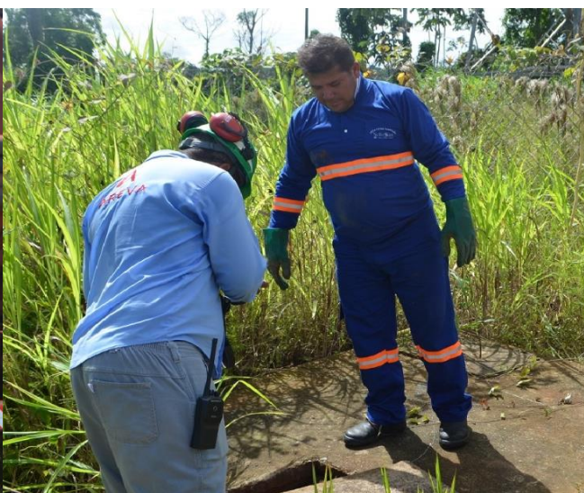
Imagem 3.3.27-34: Homens trabalhando na limpeza da fossa
