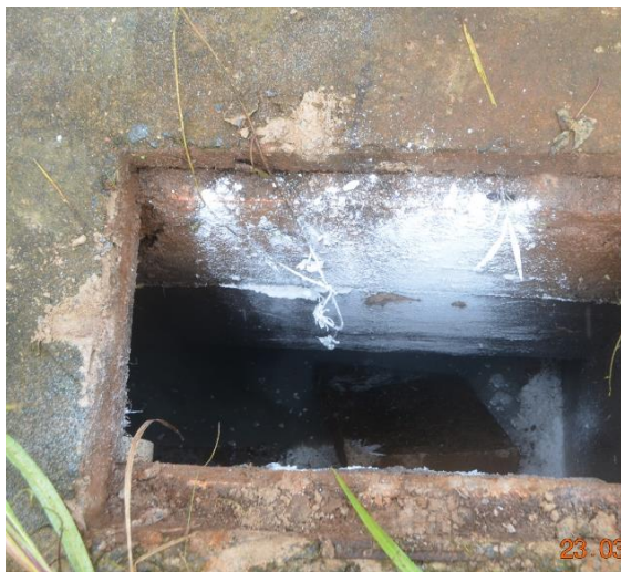
Imagem 3.3.27-31: Limpeza da fossa
