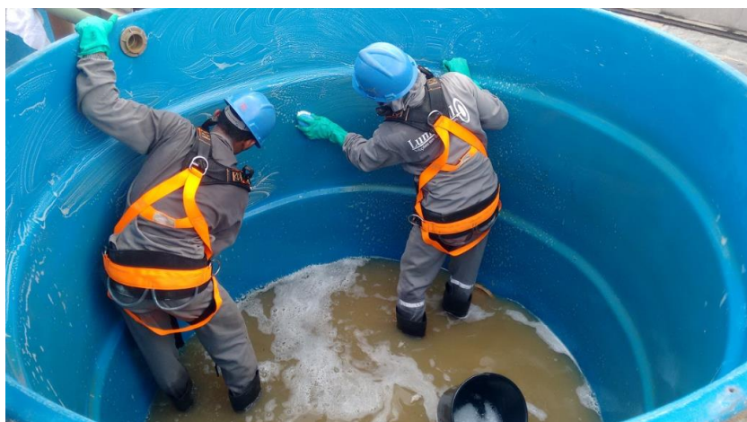
Imagem 3.3.27-24: Realização da limpeza na caixa d'água
