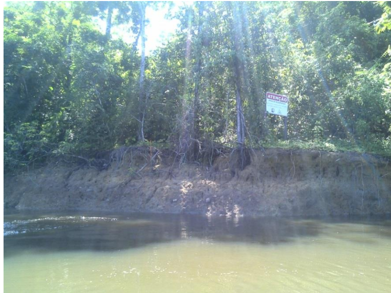
Figura 3.3.15-11: Ponto MJE-09 no Trecho erosivo do Canal Intermediário em junho de 2016.
