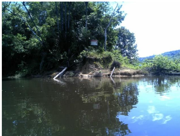
Figura 3.3.15-10: Ponto MJE-08 no Trecho erosivo do Canal Intermediário em junho de 2016.
