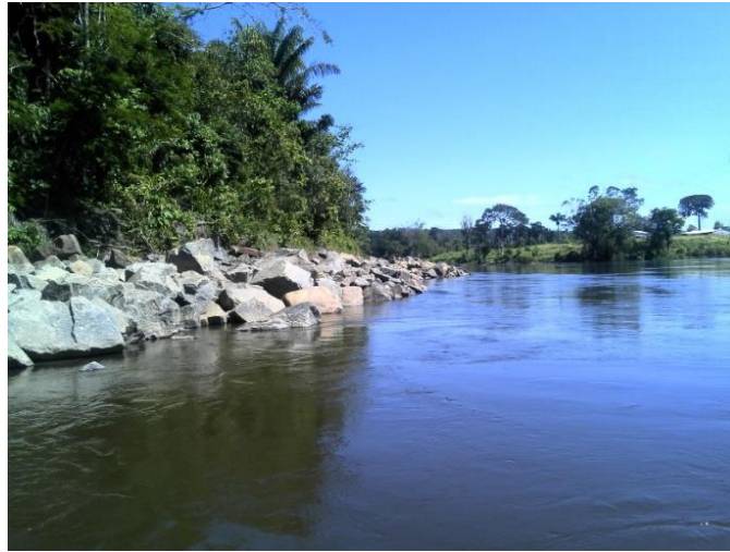
Figura 3.3.15-5. Ponto MJ1-01 no Trecho Erosivo Ilha Grande em junho de 2016.
