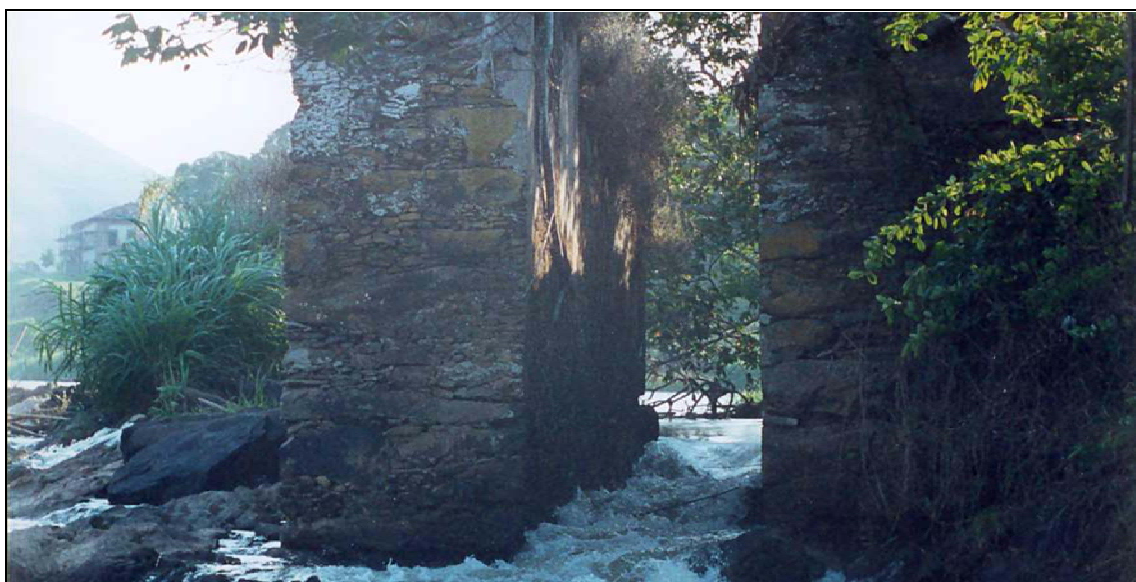
Paredes do Engenho Velho da Fazenda São Joaquim
