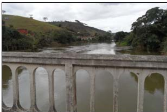
Ponte sobre o rio Preto, entre os Distritos de Manuel Duarte e Porto das Flores
