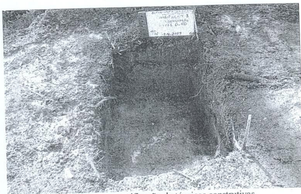
Sondagem para verificação de técnicas construtivas
