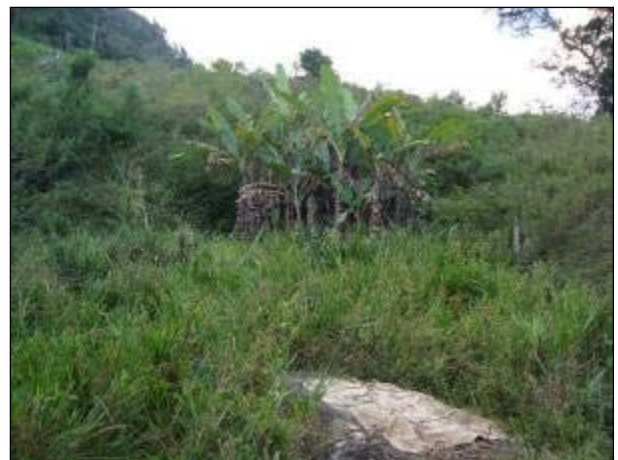
FOTO 2.13: PASTO SUJO NA ÁREA DO DESMBOQUE DO TÚNEL, MARGEM DIREITA.
