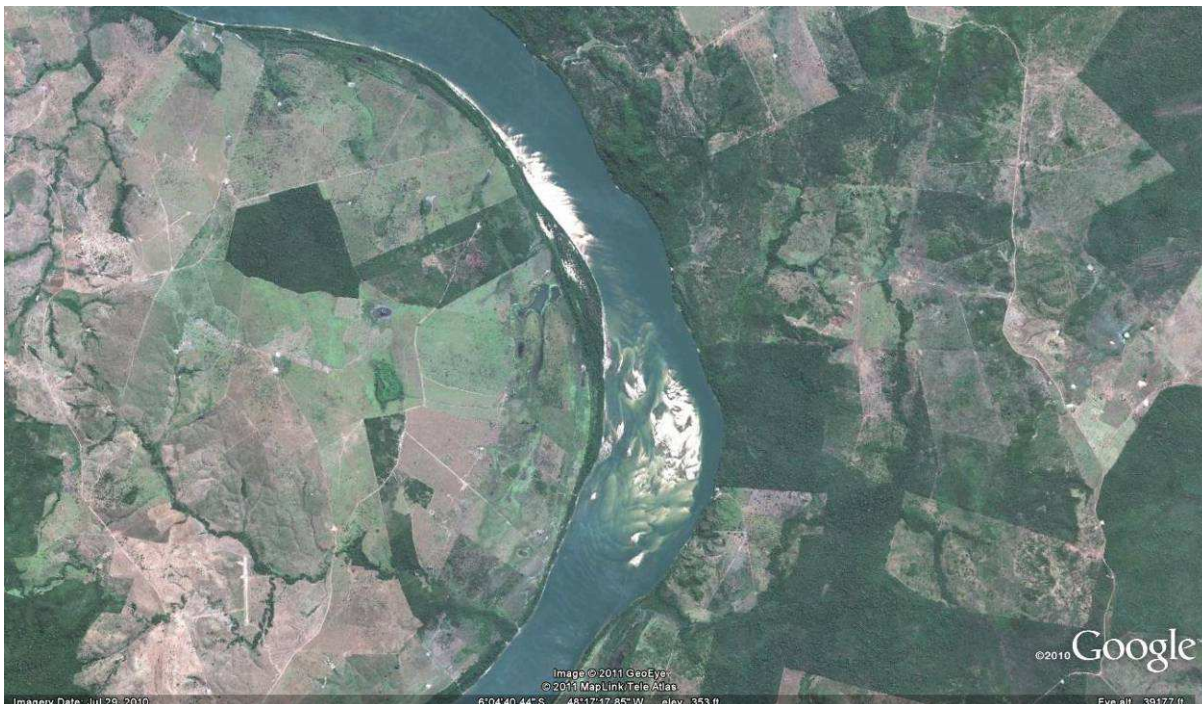
Ilustração 18. Praia e bancos de areia potencialmente impactados a jusante do AHE Santa Isabel – Coordenadas UTM WGS84 800433,83L/ 9328115,80S (Fonte: Google Earth).
