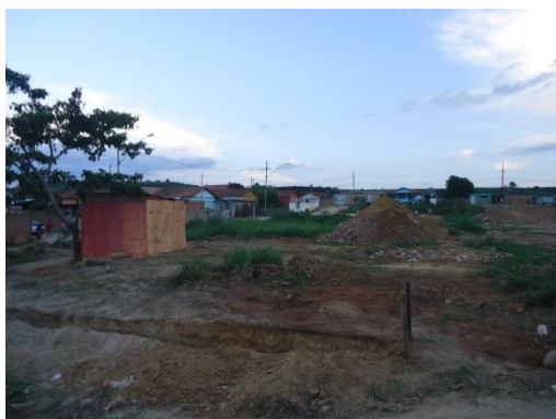
Figura 30 – Início das obras da UBP
