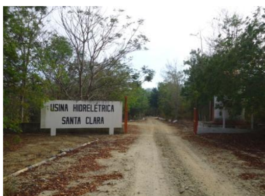
Figura 22 – Área recuperada na entrada da UHE Santa Clara (antigo canteiro de obras).
