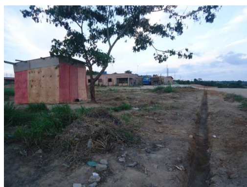
Figura 29 – Mobilização das obras da Unidade de Beneficiamento do Pescado
