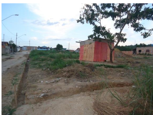
Figura 28 – Mobilização das obras da Unidade de Beneficiamento do Pescado
