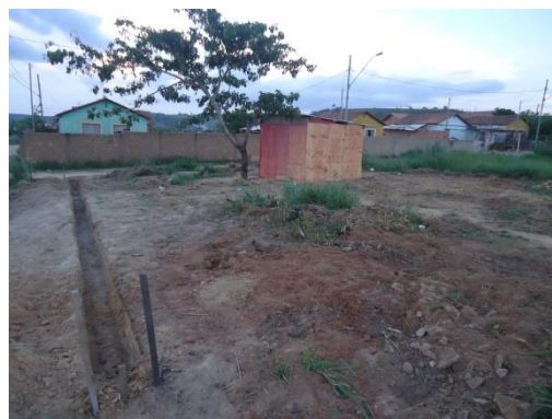
Figura 31 – Início das obras da UBP
