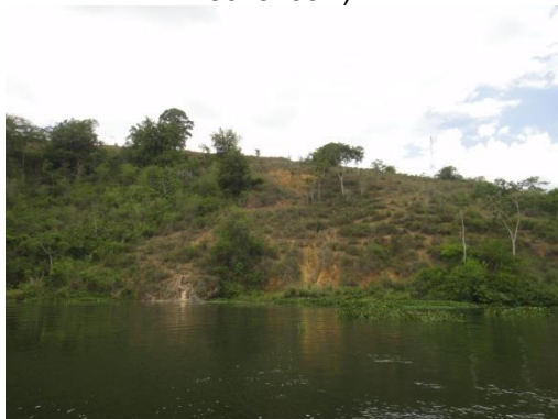
Figura 14 – Foco Erosivo P11 (Coord. UTM 365884E/ 8024662N).
