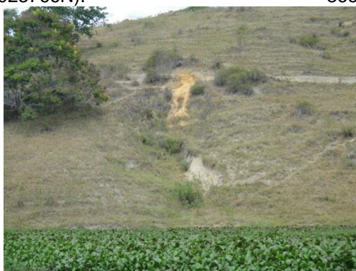
Figura 20 – Foco Erosivo P17 (Coord. UTM 367708E/ 8022366N).
