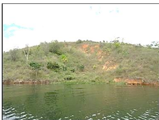
Figura 48 – Foco erosivo P15 (Coord. UTM 365886 E/8023766N).
