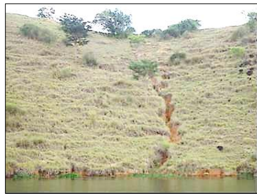
Figura 41 – Foco erosivo P8 (Coord. UTM 366837 E/8023393N).
