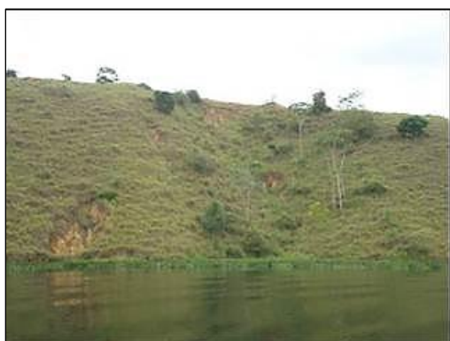
Figura 36 – Foco erosivo P3 (Coord. UTM 367093E/8023182N).
