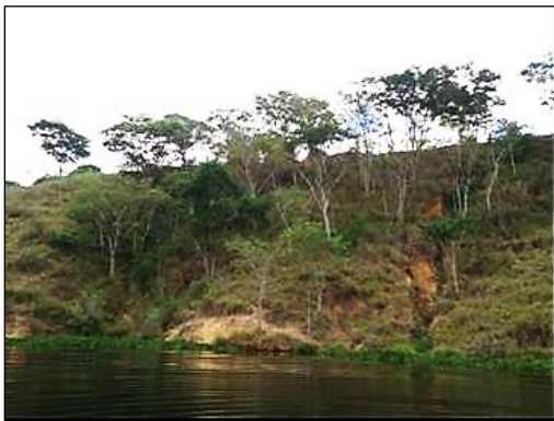
Figura 42 – Foco erosivo P9 (Coord. UTM 366731E/8023450N).
