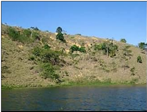
Figura 38 – Foco erosivo P5 (Coord. UTM 367322 E/8023478N).
