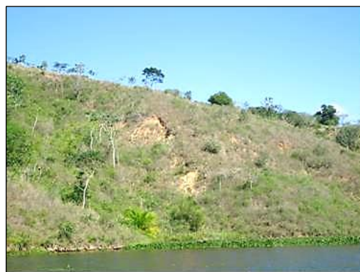
Figura 47 – Foco erosivo P14 (Coord. UTM 365831 E/8023829N).
