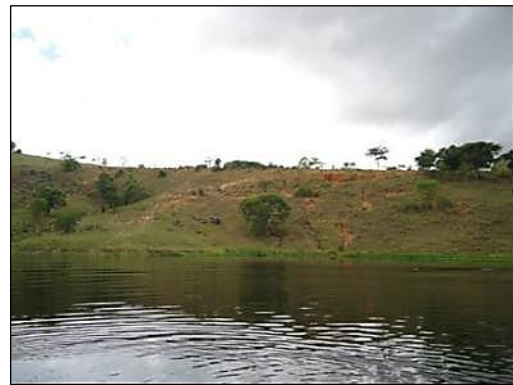
Figura 43 – Foco erosivo P10 (Coord. UTM 366533 E/8023657N).
