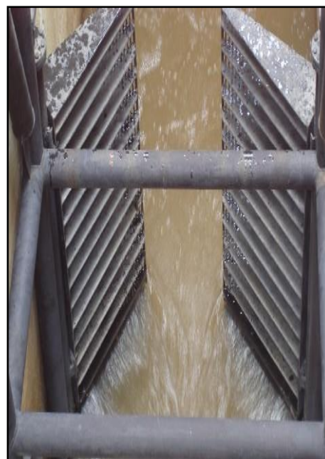
Figura 53 – Detalhe da grade confinadora.
