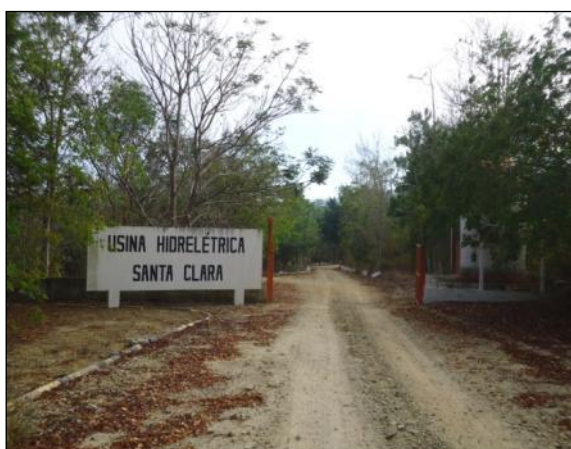
Figura 43 – Área recuperada na entrada da UHE Santa Clara (antigo canteiro de obras).
