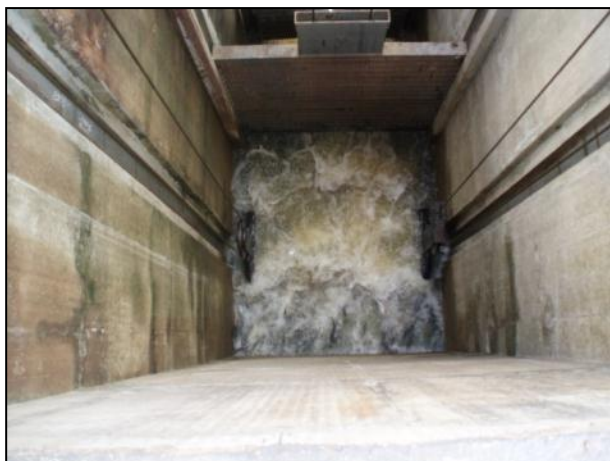
Figura 56 – Início da elevação da caçamba.
