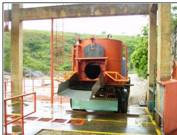
Figura 71 – Manutenção do STP.
