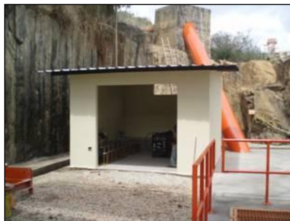
Figura 65 – Abrigo dos operadores do STP.
