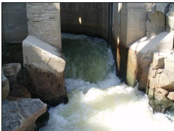
Figura 54 – Detalhe da atração ao final do canal.
