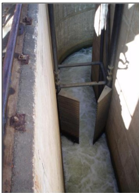
Figura 52 – Canal de atração. Detalhe da grade confinadora.
