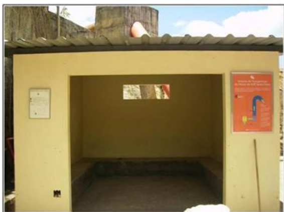
Figura 70 – Detalhe do Abrigo dos operadores
