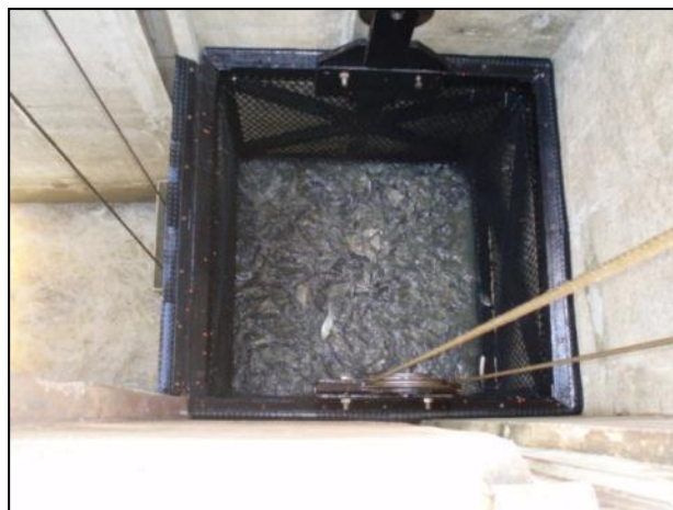
Figura 57 – Elevação da caçamba.
