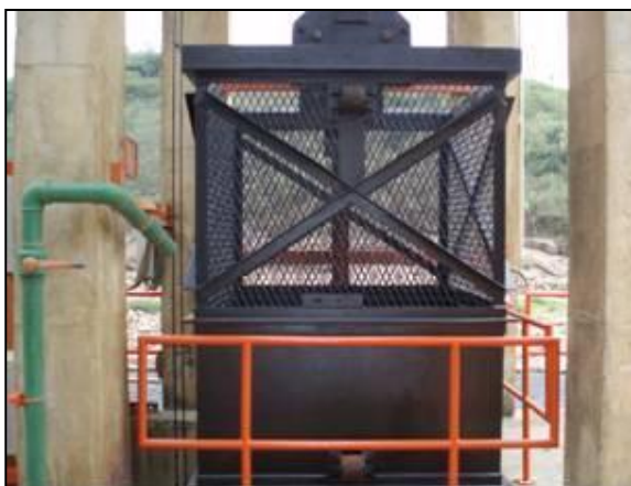
Figura 68 – Pintura da caçamba e guarda corpos.
