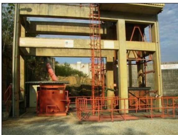
Figura 66 – Manutenção do STP.
