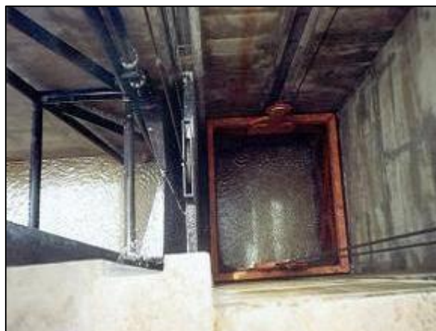
Figura 55 – Grade confinadora, grade móvel e caçamba.
