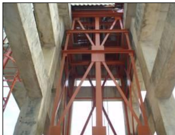
Figura 69 – Pintura do elevador.
