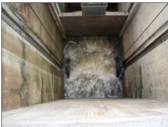
Figura 47 – Início da elevação da caçamba.
