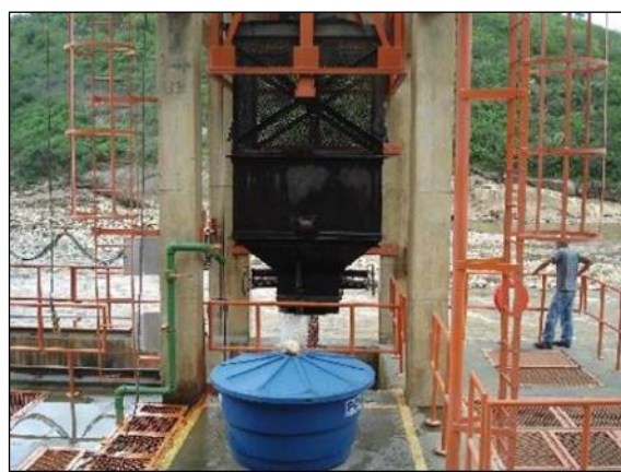
Figura 50 – Elevação da caçamba.
