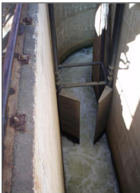
Figura 43 – Canal de atração. Detalhe da grade confinadora.
