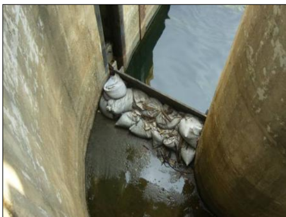
Figura 55 – Manutenção da comporta.
