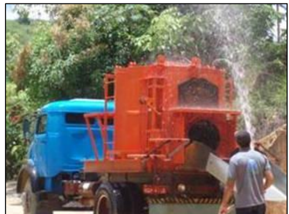
Figura 70 – Aplicação de água no tanque.
