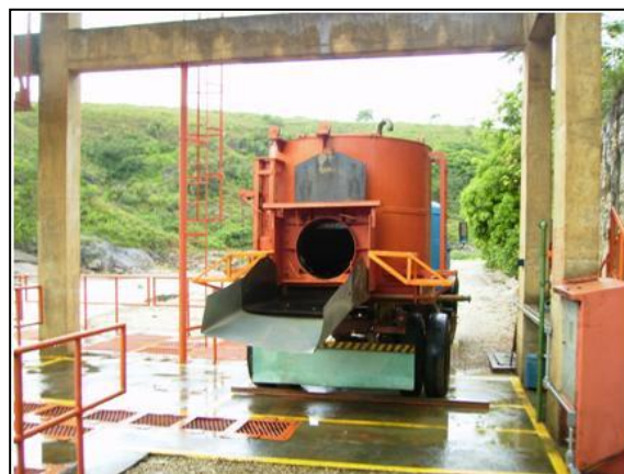
Figura 62 – Manutenção do STP.
