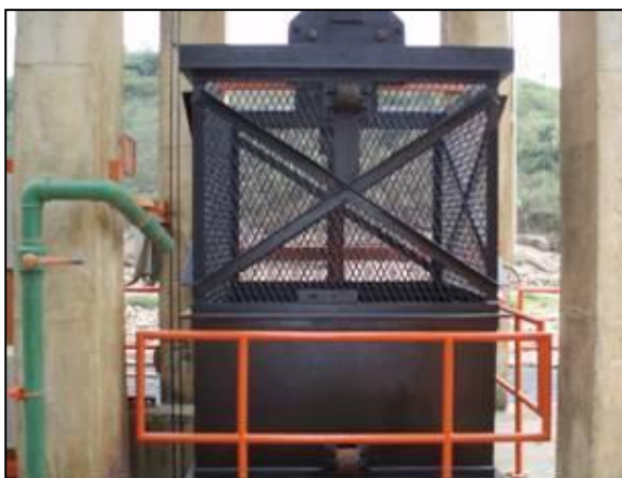
Figura 59 – Pintura da caçamba e guarda corpos.
