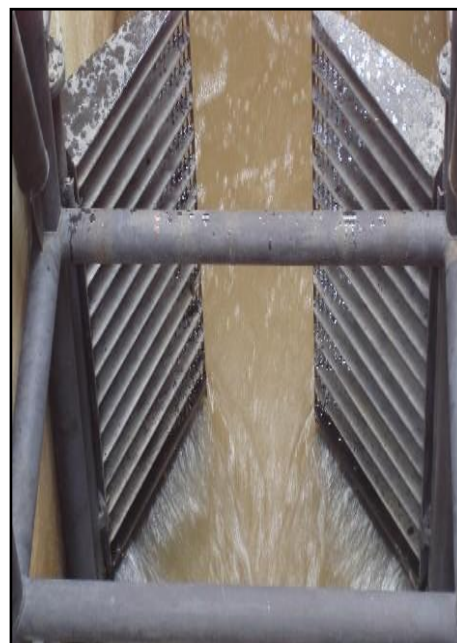
Figura 44 – Detalhe da grade confinadora.
