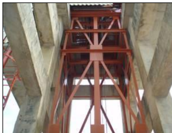
Figura 60 – Pintura do elevador.
