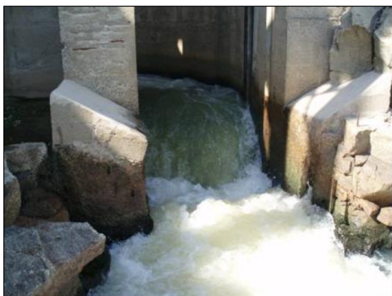
Figura 45 – Detalhe da atração ao final do canal.
