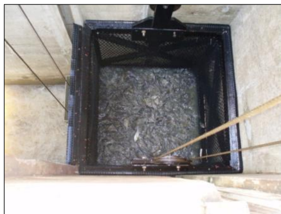
Figura 48 – Elevação da caçamba.
