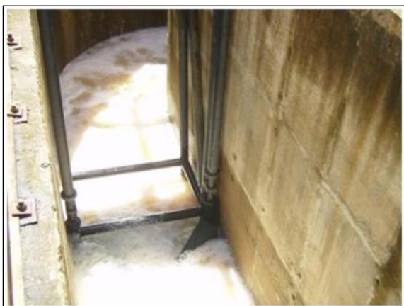
Figura 81 – Detalhe do canal de atração.
