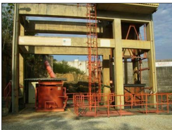
Figura 57 – Manutenção do STP.
