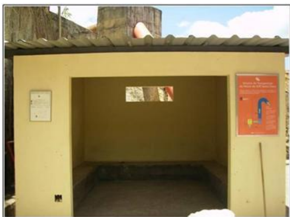
Figura 61 – Detalhe do Abrigo dos operadores
