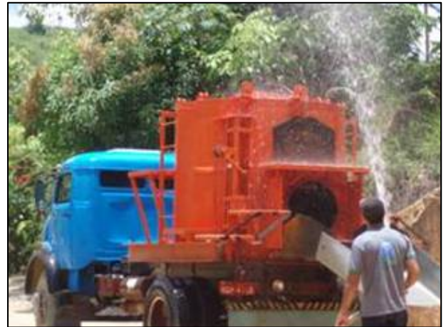
Foto 29 – Aplicação de água no tanque.
