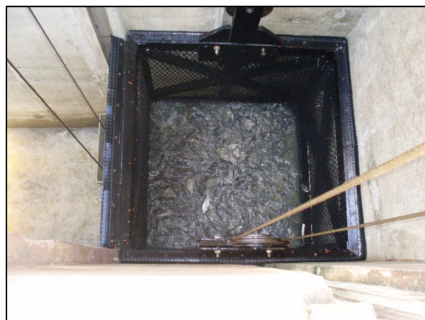
Foto 7 – Elevação da caçamba.
