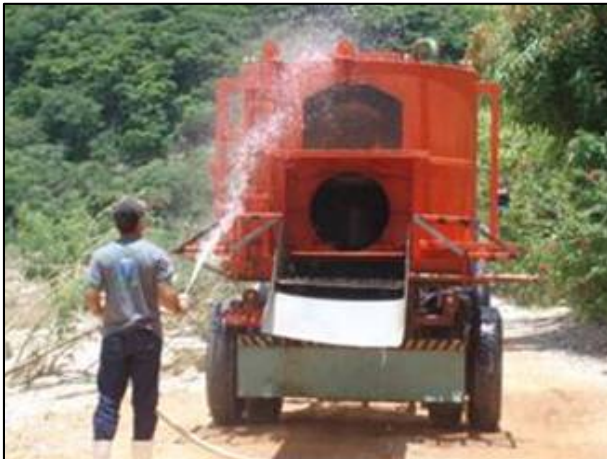
Foto 28 – Aplicação de água no tanque.
