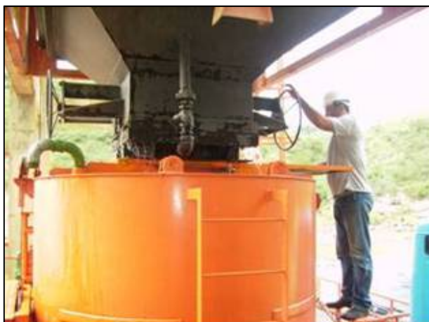
Foto 36 – Detalhe do encaixe da caçamba no tanque.
