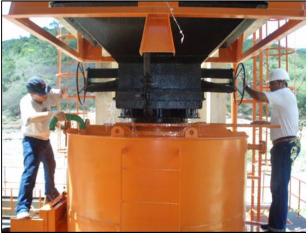
Foto 10 – Acoplamento da caçamba ao tanque.
