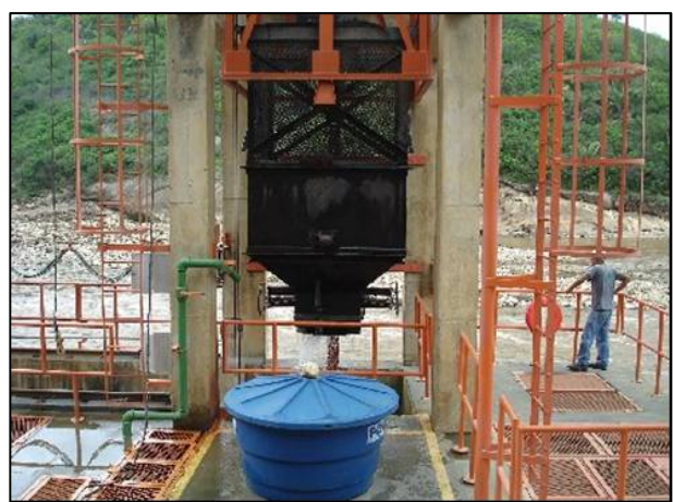
Foto 9 – Elevação da caçamba.
