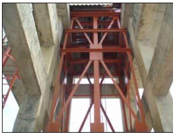
Foto 19 – Pintura do elevador.
