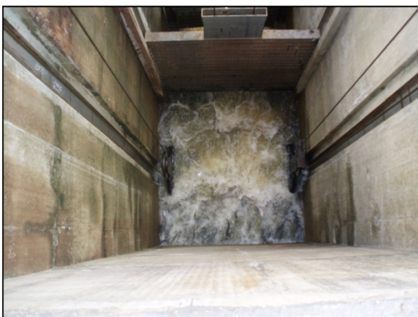
Foto 6 – Início da elevação da caçamba.
