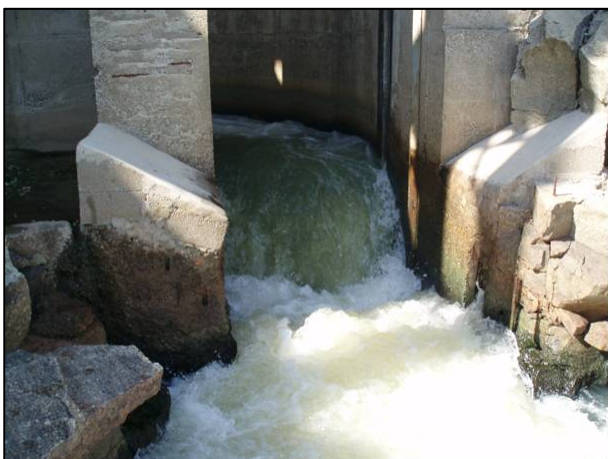
Foto 4 – Detalhe da atração ao final do canal.
