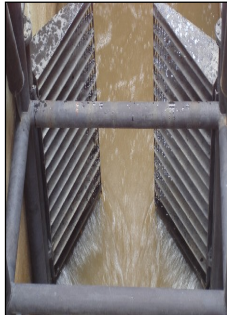
Foto 3 – Detalhe da grade confinadora.
