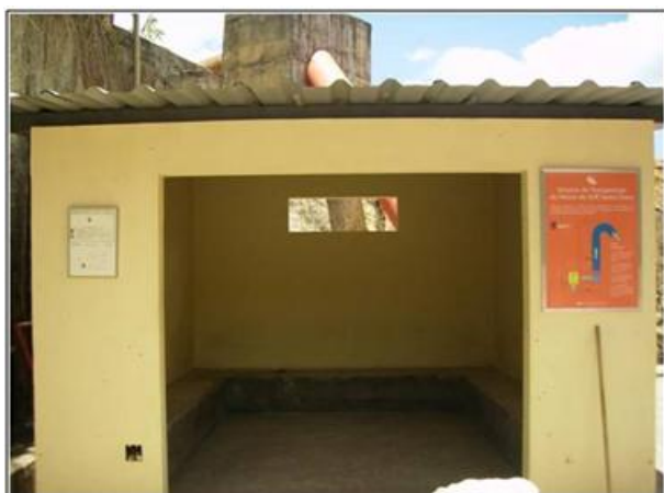
Foto 20 – Detalhe do Abrigo dos operadores
