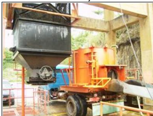
Foto 35 – Detalhe da elevação da caçamba.
