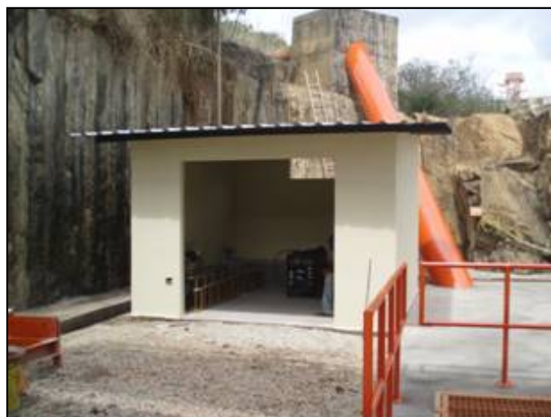
Foto 15 – Abrigo dos operadores do STP.
