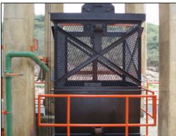
Foto 18 – Pintura da caçamba e dos guarda corpos.
