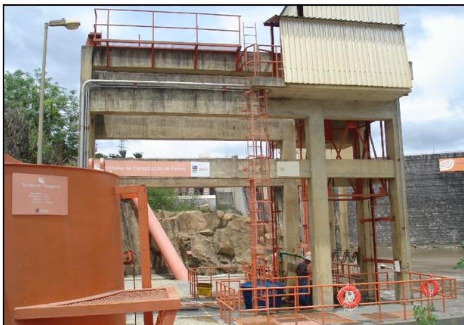
Foto 1 – STP. Vista geral.
