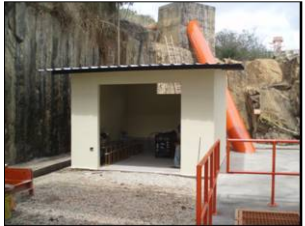
Foto 15 – Construção do “abrigo dos operadores do STP”.
