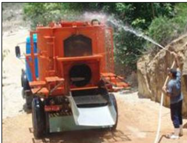
Foto 32 – Aplicação de água no tanque.
