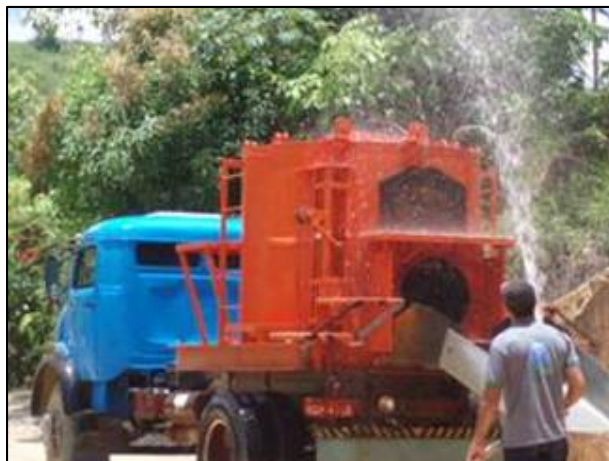
Foto 31 – Aplicação de água no tanque.
