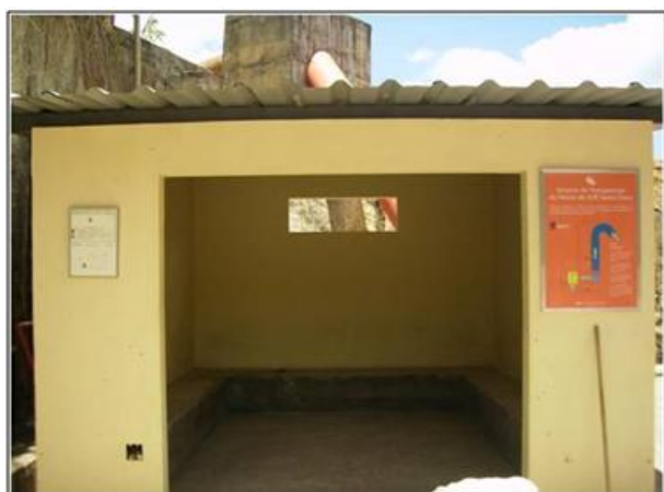
Foto 24 – Localização da placa indicativa dos equipamentos do STP
