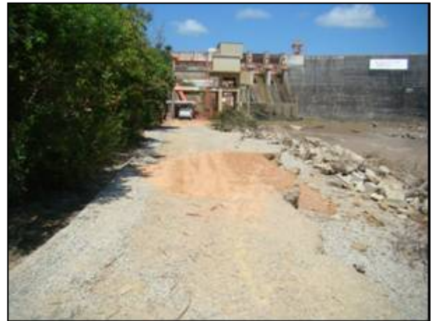
Foto 40 – Acesso consertado. Vista geral.
