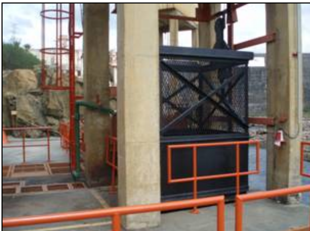
Foto 20 – Pintura da caçamba, escada e guarda-corpos.
