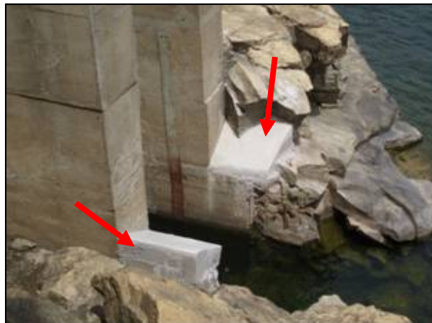
Foto 21 – Construção de estruturas para evitar aprisionamento de peixes.
