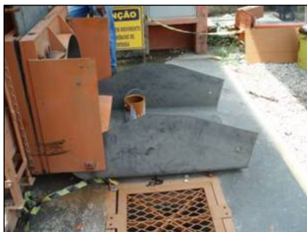
Foto 23 – Detalhe da canaleta ainda sem o seu alongamento.
