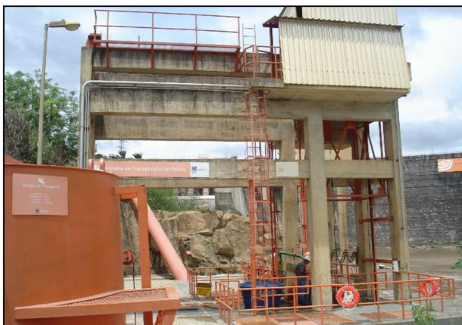
Foto 1 – STP. Vista geral.
