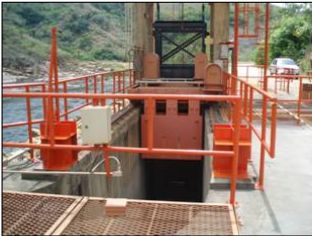
Foto 16 – Pintura dos guarda corpos.
