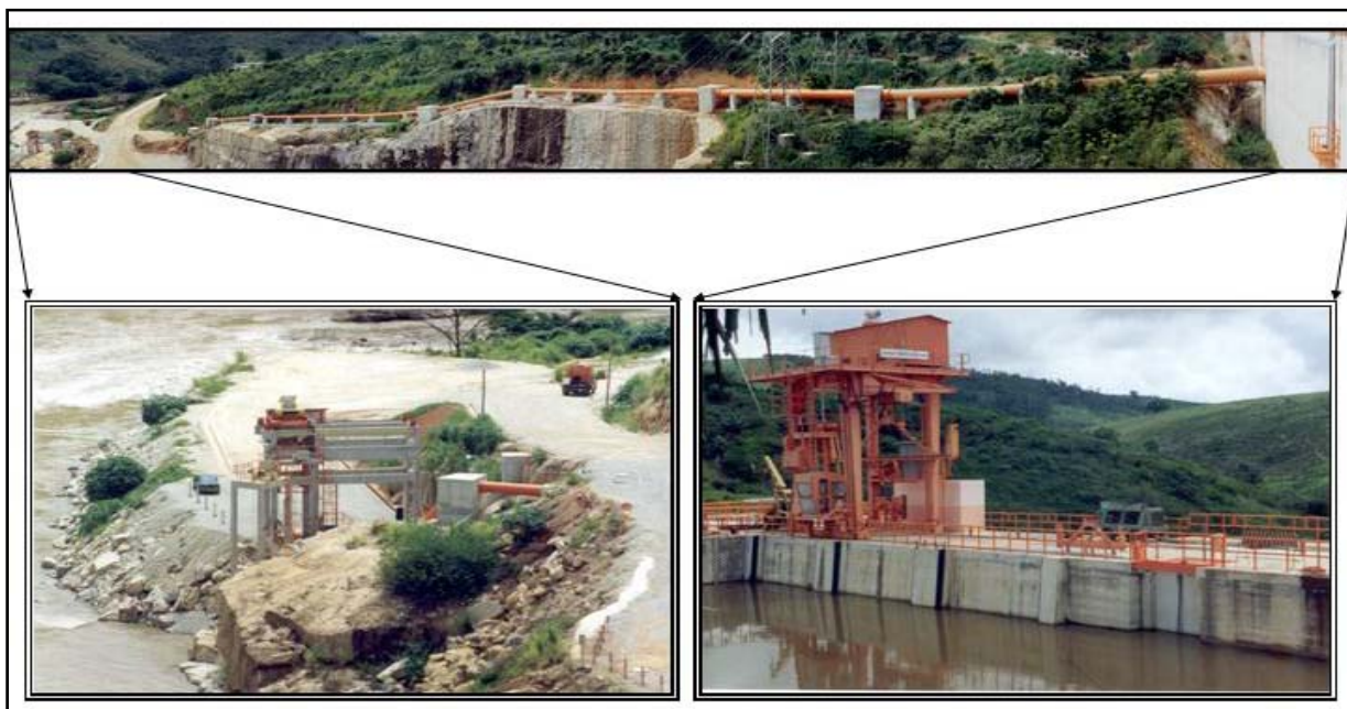
Figura 4 – Tubulação de “água de atração” junto à barragem da UHE até o “elevador para peixes”.
