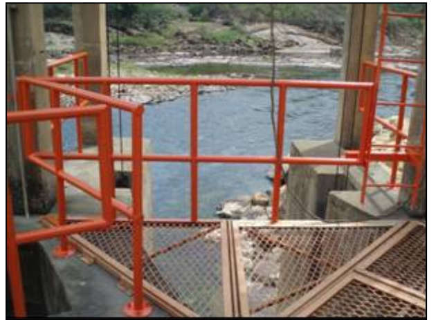
Foto 17 – Pintura dos guarda corpos
