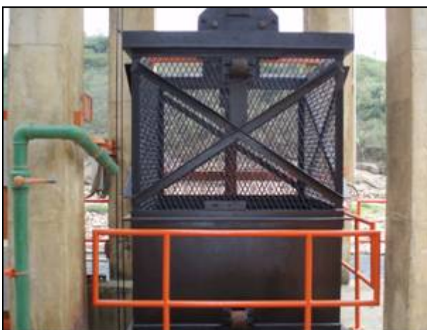
Foto 18 – Pintura da caçamba e dos guarda corpos.
