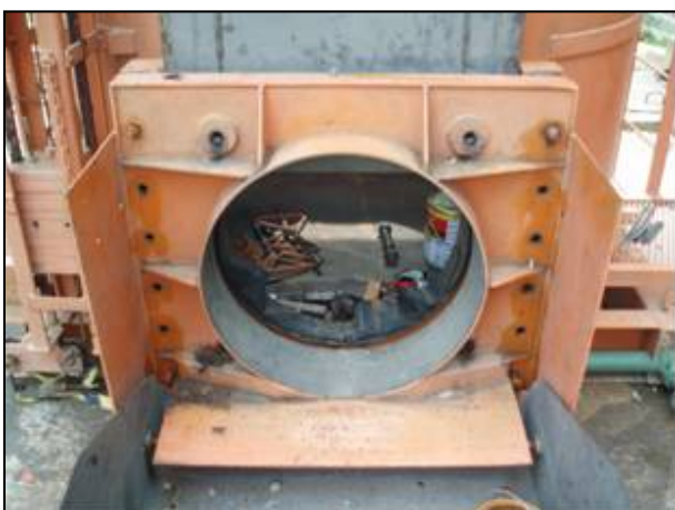
Foto 22 – Detalhe da abertura/comporta do tanque.
