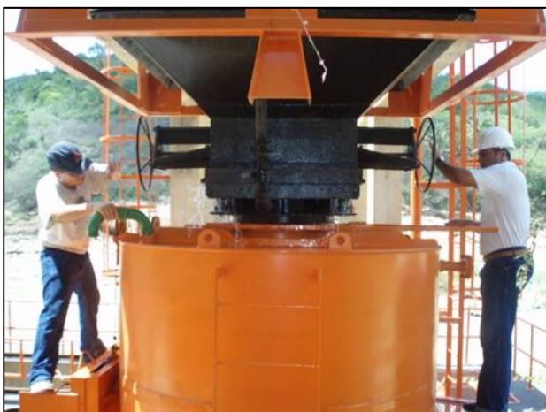
Foto 10 – Acoplamento da caçamba ao tanque.
