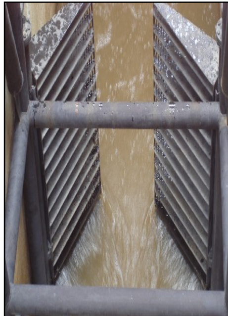
Foto 3 – Detalhe da grade confinadora.
