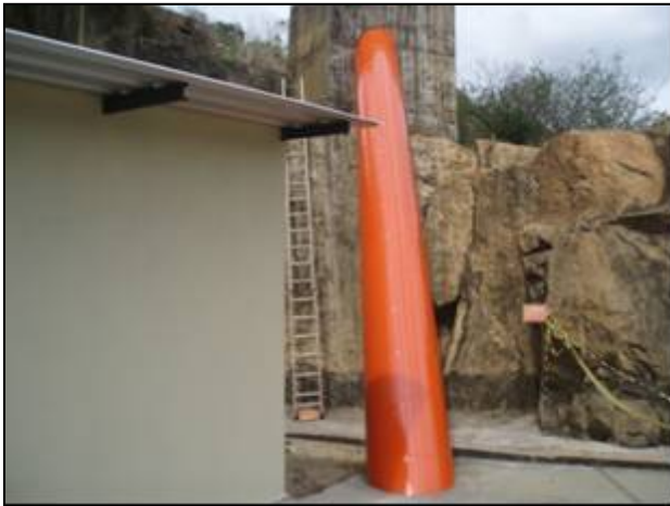
Foto 14 – Pintura do conduto forçado.
