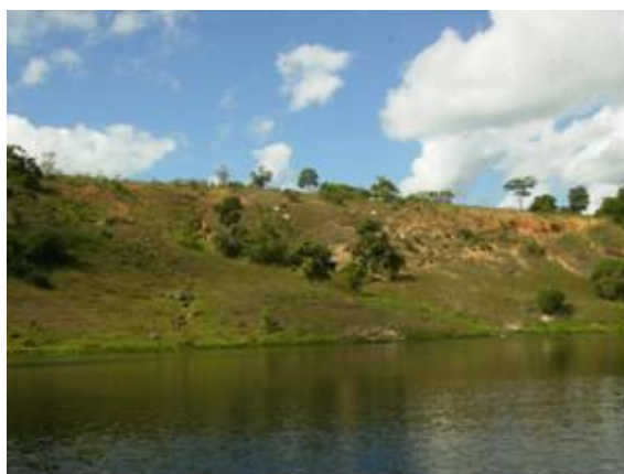
Foto 13 – Foco erosivo com sulcamento e início de ravinamento
