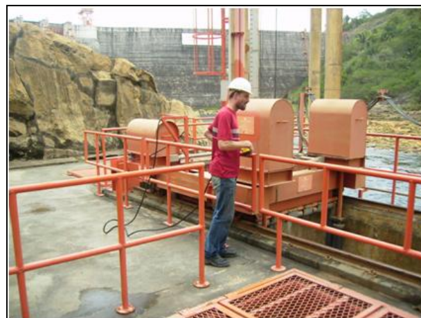
Foto 53 – Detalhe da operação do STP.
