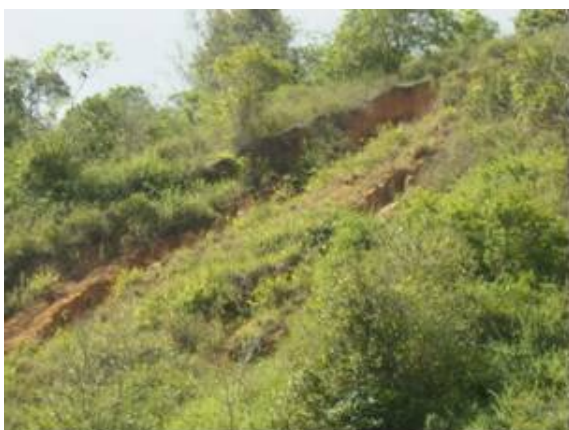
Foto 12 – Foco erosivo com início de deslocamento de massa
