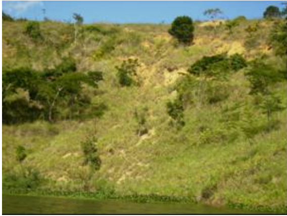
Foto 16 – Foco erosivo com sulcamento
