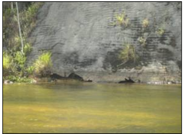
Foto 19 – Ombreira Margem esquerda. Detalhe da saída da água por trás do concreto projetado
