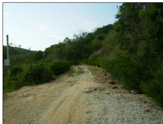
Foto 47 – Limpeza dos acessos.
