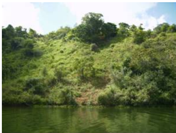
Foto 11 – Foco erosivo com início de sulcamento
