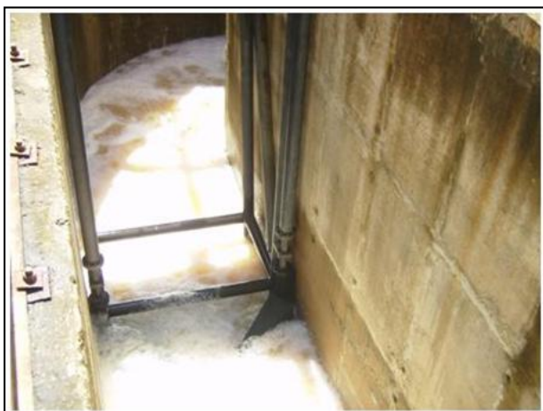
Foto 54 – Detalhe do canal de atração.
