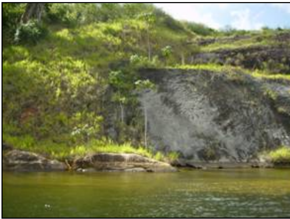
Foto 18 – Ombreira Margem esquerda
