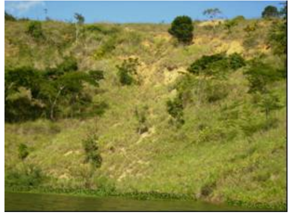
Foto 17 – Foco erosivo com sulcamento
