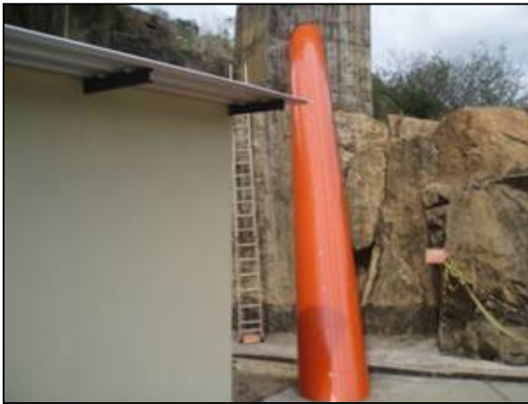
Foto 103 – Pintura do conduto forçado.
