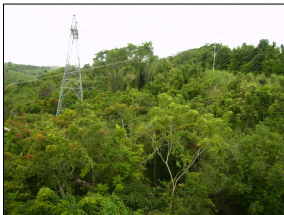
Foto 74 – Área recuperada próxima ao eixo da barragem (2010).
