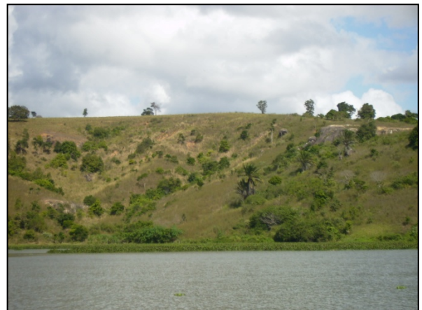
Foto 14 – Foco erosivo com início de sulcamento
