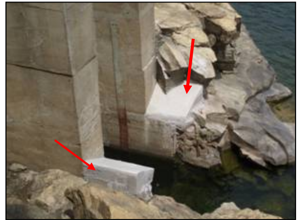
Foto 110 – Construção de estruturas para evitar aprisionamento de peixes durante a atração.
