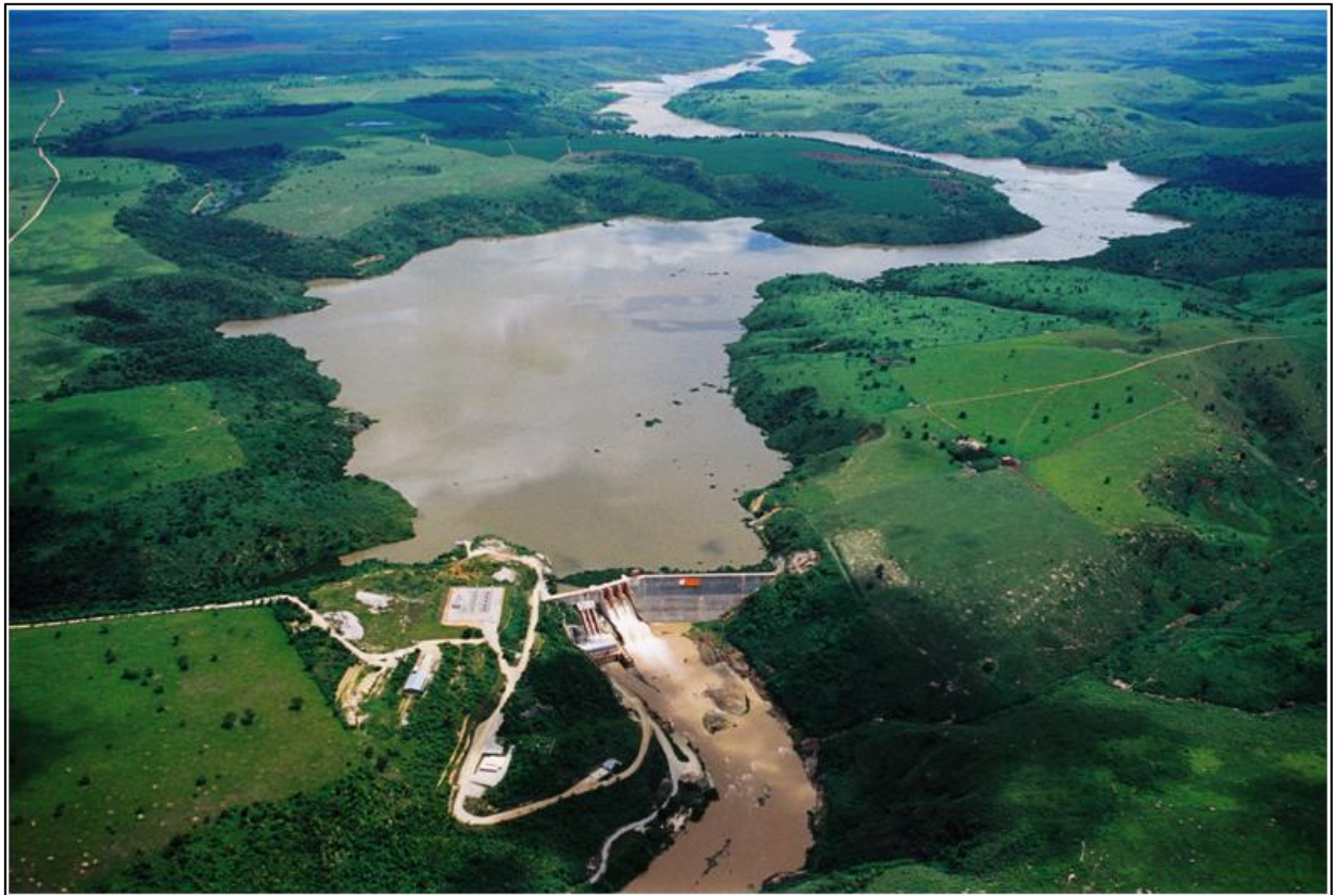
Foto 43 – Área ciliar em processo de recuperação Visão geral do reservatório.
