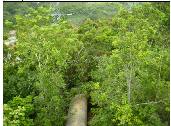
Foto 72 – Área recuperada próxima ao eixo da barragem. Tomada d'água para o STP (2010).
