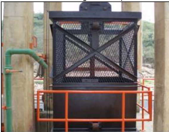
Foto 107 – Pintura da caçamba e dos guarda corpos.
