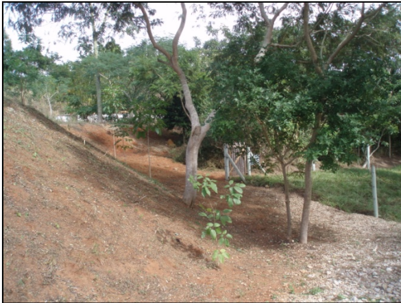
Foto 99 – Acesso ao sítio cemitério após sua manutenção.
