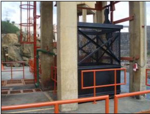
Foto 109 – Pintura da caçamba, escada e guarda corpos.
