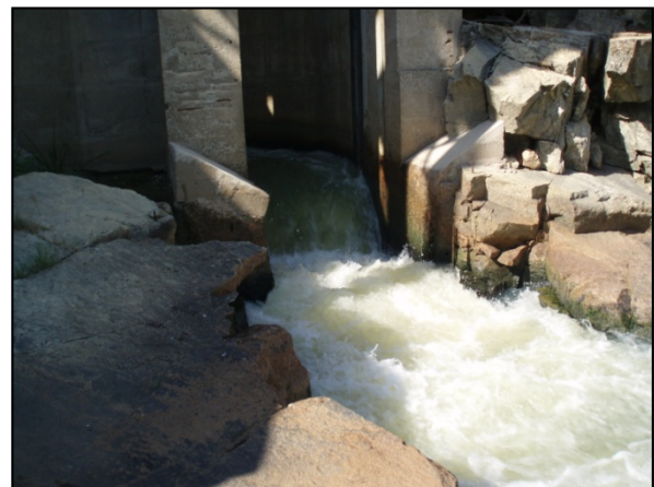
Foto 124 – Detalhe do turbilhonamento da água de atração.
