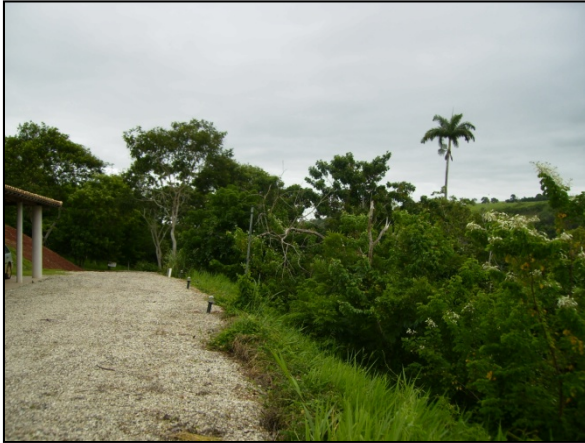
Foto 97 – Acesso ao Sítio cemitério após sua manutenção.
