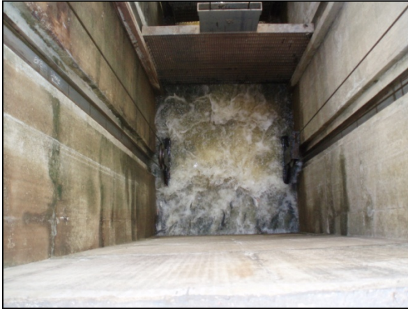
Foto 125 – Detalhe da caçamba sendo elevada após fechamento da comporta.
