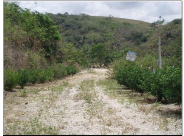
Foto 88 – Acesso durante manutenção.
