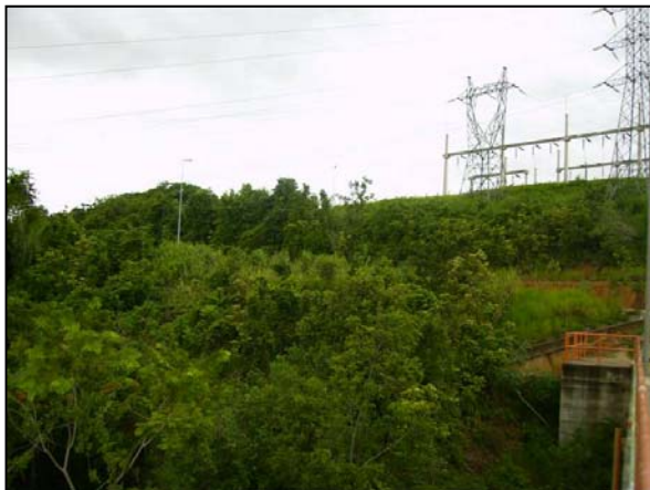
Foto 71 – Área recuperada próxima ao eixo da barragem (2010).
