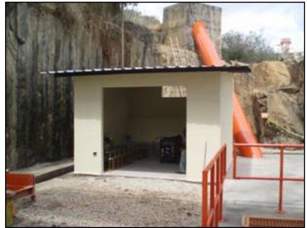
Foto 104 – Construção do “abrigo dos operadores do STP”.
