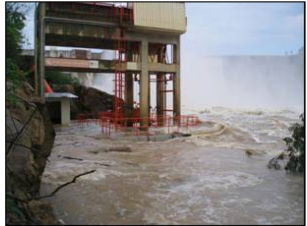
Foto 114 – Cheia do rio Mucuri no STP
