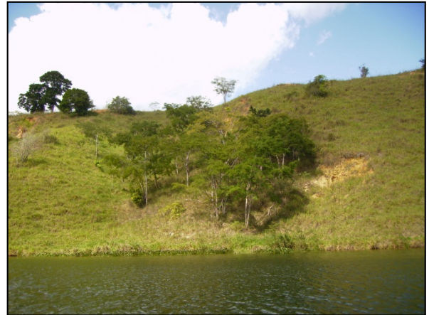
Foto 18 – Foco erosivo em recuperação e estabilização.
