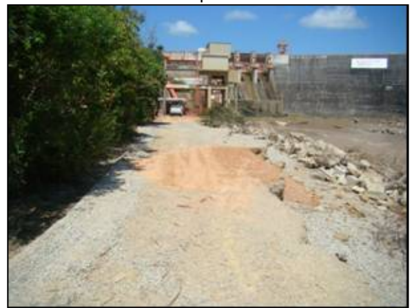
Foto 122 – Acesso recuperado. Vista geral.
