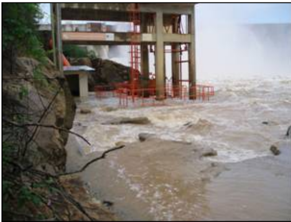
Foto 115 – Cheia do rio Mucuri no STP
