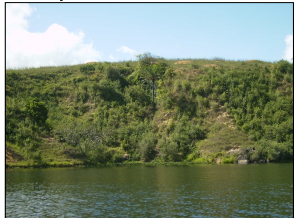
Foto 20 – Foco erosivo em estabilização.
