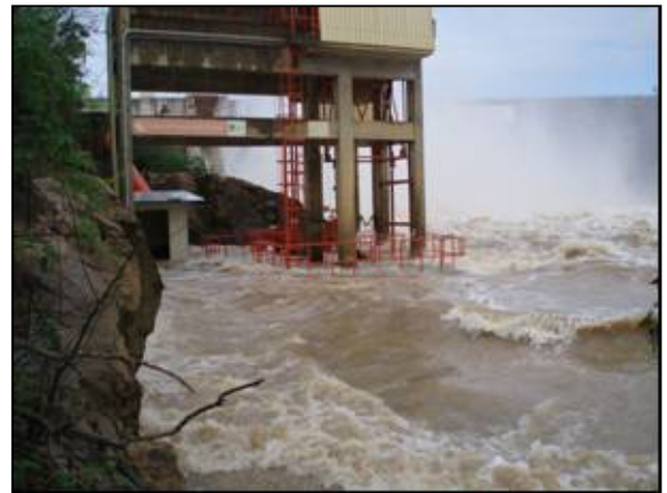
Foto 116 – Cheia do rio Mucuri no STP
