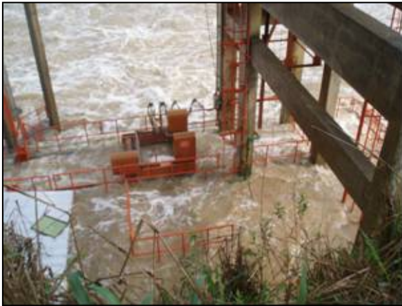
Foto 113 – Cheia do rio Mucuri no STP
