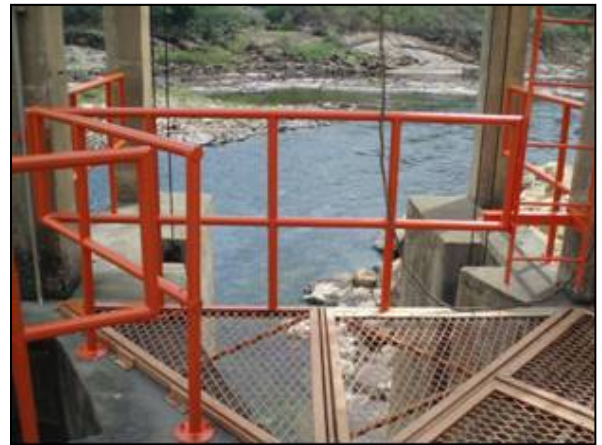
Foto 106 – Pintura dos guarda corpos
