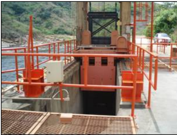
Foto 105 – Pintura dos guarda corpos.
