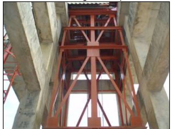
Foto 108 – Pintura do elevador.
