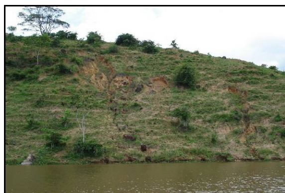
Figura 5.29 – Vista panorâmica do processo erosivo – ME / FOCO 15.
