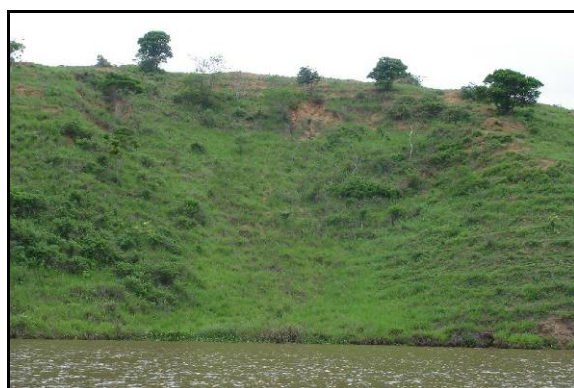
Figura 5.38 – Vista panorâmica do processo erosivo – ME / FOCO 19.
