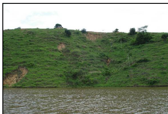
Figura 5.39 – Vista panorâmica do processo erosivo – ME / FOCO 20.
