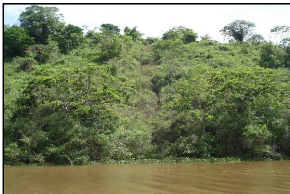
Figura 5.13 – Vista panorâmica do processo erosivo – ME / FOCO 01. Presença de grande disseminação de plantas invasoras.
