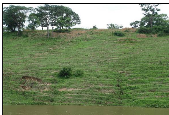
Figura 5.24 – Vista panorâmica do processo erosivo – ME / FOCO 11.
