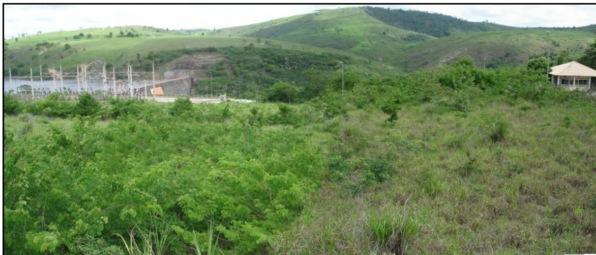
Figura 7.21 – Vista parcial de uma área interna da UHE que sofreu reabilitação.
