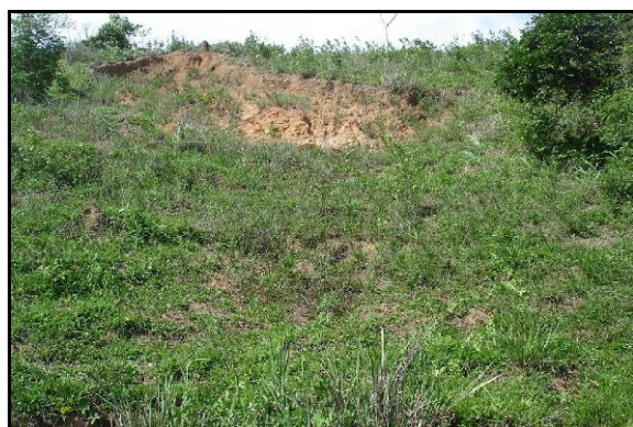
Figura 5.10 – Vista panorâmica do processo erosivo – MD / FOCO 09 . Observar a
