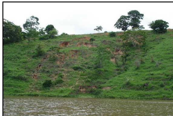
Figura 5.31 – Vista panorâmica do processo erosivo – ME / FOCO 17.
