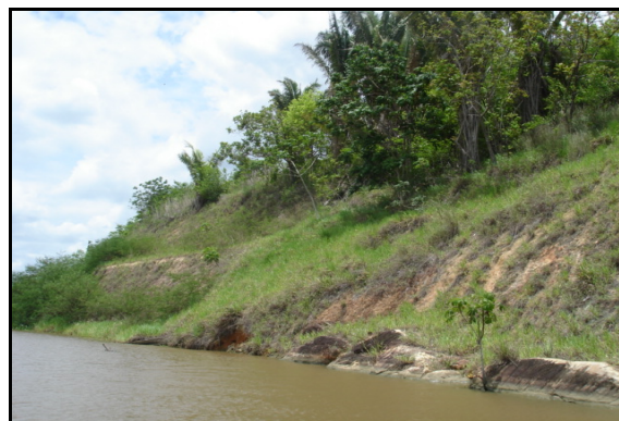
Figura 5.50 – Vista panorâmica do processo erosivo controlado próximo ao eixo da barragem - ME / FOCO 30.
