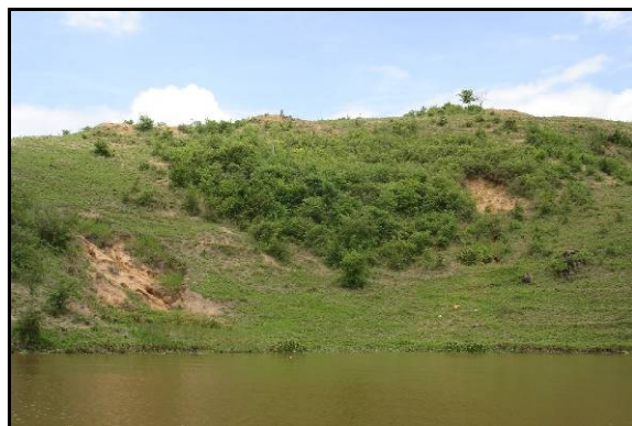
Figura 5.42 – Vista panorâmica do processo erosivo – ME / FOCO 23.
