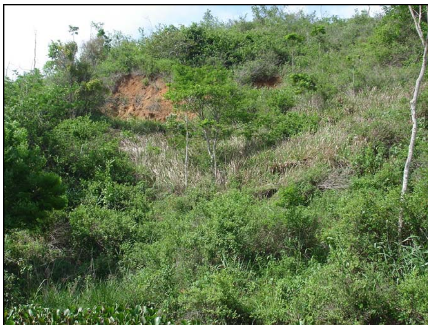
Figura 5.3 – Vista panorâmica do processo erosivo – Notar a ocupação por espécies arbustivas denotando grande disseminação. MD / FOCO 03 .
