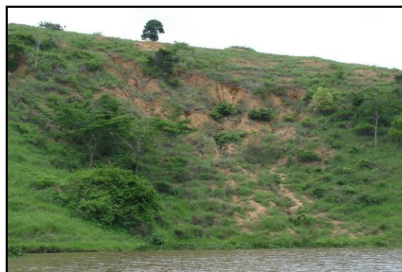
Figura 5.33 – Vista panorâmica do processo erosivo – ME / FOCO 17.
