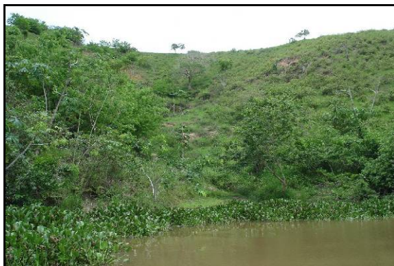
Figura 5.46 – - Vista panorâmica do processo erosivo – MD / FOCO 27.
