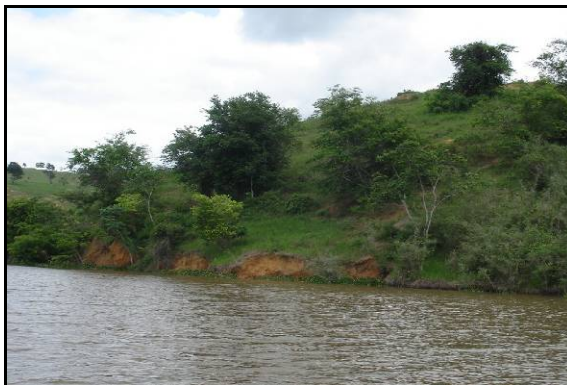
Figura 5.40 – Vista panorâmica do processo erosivo – ME / FOCO 21.
