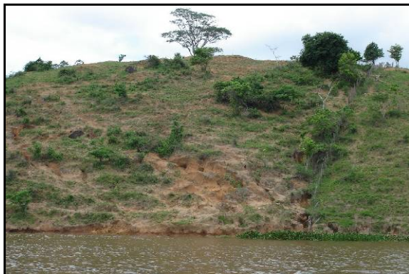
Figura 5.30 – Vista panorâmica do processo erosivo – ME / FOCO 16.
