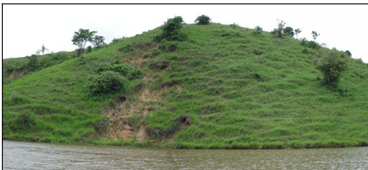
Figura 5.37 – Vista panorâmica do processo erosivo – ME / FOCO 18.
