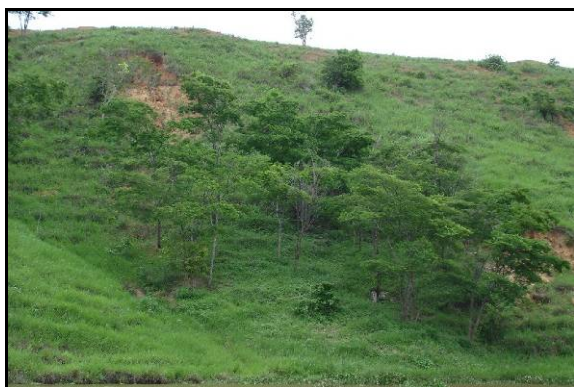
Figura 5.32 – Vista panorâmica do processo erosivo – ME / FOCO 17.
