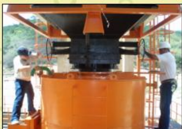
BASCULAMENTO DA ESTAÇÃO ELEVATÓRIA NO CAMINHÃO TANQUE ADAPTADO PARA O PROCESSO DE TRANSPORTE.
