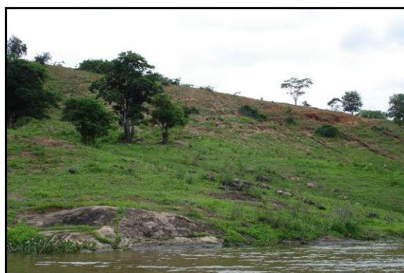
Figura 5.23 – Vista panorâmica do processo erosivo – ME / FOCO 10.
