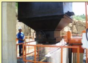
BASCULAMENTO DA CAÇAMBA QUE IRÁ ABASTECER O CAMINHÃO TANQUE. OBSERVAR QUE A OPERAÇÃO É CONTROLADA DE PERTO PELO OPERADOR DO PROCESSO.
