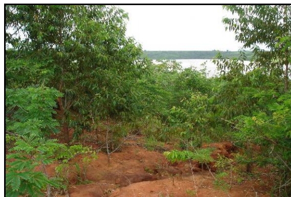
Figura 7.23 – Vista de uma área próxima à figura anterior. Área anteriormente atingida por uma Voçoroca com cobertura vegetal.
