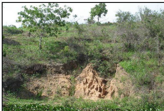
Figura 5.8 – Vista panorâmica do processo erosivo – MD / FOCO 08.
