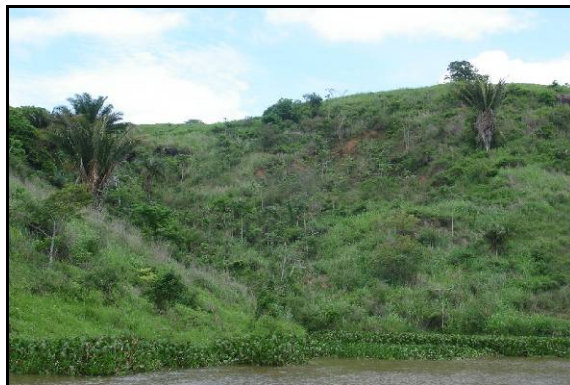
Figura 5.45 – Vista panorâmica do processo erosivo – MD / FOCO 26.
