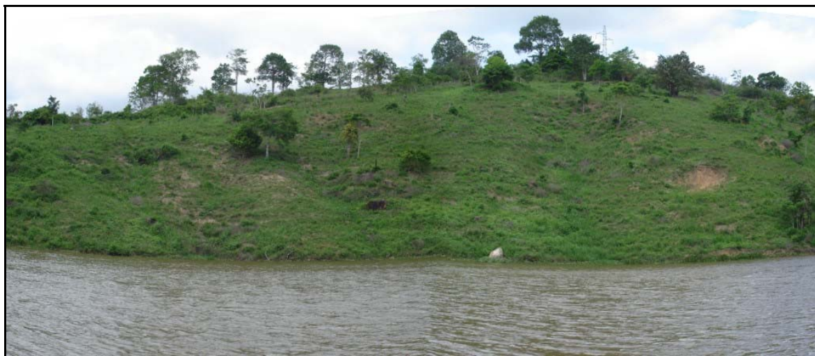
Figura 5.20 – Vista panorâmica do processo erosivo – ME / FOCO 08.
