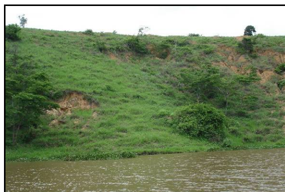
Figura 5.35 – Vista panorâmica do processo erosivo – ME / FOCO 17.
