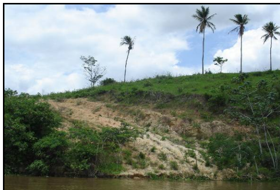
Figura 5.47 – - Vista panorâmica do processo erosivo – MD / FOCO 28.
