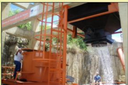
OBSERVAR A OPERAÇÃO DA ESTAÇÃO ELEVATÓRIA, QUE IRÁ LEVAR CUIDADOSAMENTE OS PEIXES ATÉ O CAMINHÃO ADAPTADO PARA O PROCESSO.
