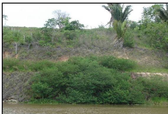
Figura 5.48 - Vista geral do processo erosivo controlado próximo ao eixo da barragem.
