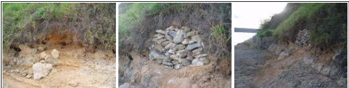
FOTO 9.5: CONTENÇÃO DE EROSÃO.
