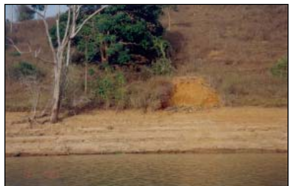
FOTO 7.16: SETOR 364/65, COORD. (UTM) 364.607 / 8.024.716, MARGEM MD. PROCESSO EROSIVO INSTALADO NA FAIXA ESTUDADA, CAUSANDO LEVE SOLAPAMENTO DE PROC. EROS. NA MARGEM, DE TAMANHO AINDA IRRELEVANTE, LOCALIZADO ACIMA DA ELEVAÇÃO 86, O QUAL NÃO TINHA SIDO IDENT. EM MONITORAMENTOS ANTERIORES.
