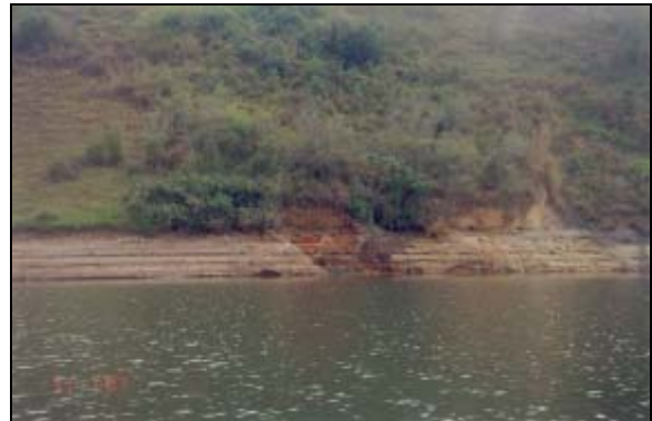
FOTO 7.32: SETOR 367/68, COORD. (UTM) 367.999 / 8.022.440, MARGEM ME. PROCESSO EROSIVO INSTALADO NA FAIXA ESTUDADA, CAUSANDO LEVE SOLAPAMENTO DE PROC. EROSIVO NA MARGEM, DE TAMANHO AINDA IRRELEVANTE, LOCALIZADO ACIMA DA ELEVAÇÃO 86, O QUAL NÃO TINHA SIDO IDENTIFICADO EM MONIT. ANTERIORES.
