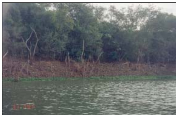
FOTO 7.21: SETOR 362/63, COORD. (UTM) 362.368 / 8.025.515, MARGEM ME. VISTA GERAL DE TRECHO DO SETOR, SEM NENHUMA OCORRÊNCIA DE PROCESSO EROSIVO INSTALADO.
