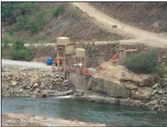
FOTO 5.7: SISTEMA DE TRANSPOSIÇÃO DE PEIXES.
