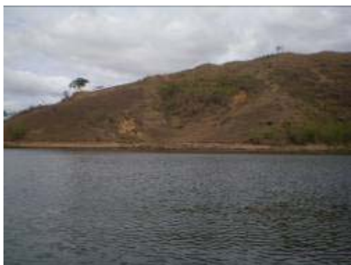
FIGURA 3.2: NÍVEL DAS ÁGUAS NO RESERVATÓRIO DA UHE SANTA CLARA, EM NOVEMBRO/07.
