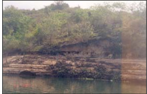
FOTO 7.2: SETOR 371/72, COORD. (UTM) 371.560 / 8.020.672, MARGEM MD. PROCESSO EROSIVO INSTALADO NA FAIXA ESTUDADA, CAUSANDO SOLAPAMENTO DE PROC. EROSIVO DE PEQUENA MONTA EXISTENTE NA MARGEM, ACIMA DA ELEVAÇÃO 86, O QUAL NÃO TINHA SIDO IDENTIFICADO EM MONITORAMENTOS ANTERIORES.
