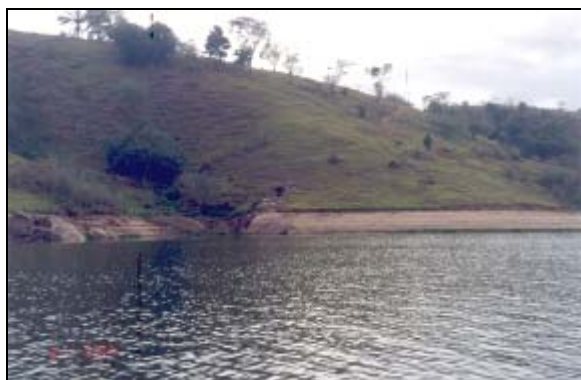
FOTO 7.33: SETOR 368/96, COORD. (UTM) 368.036 / 8.024.426, MARGEM ME. VISTA GERAL DE TRECHO DO SETOR, SEM NENHUMA OCORRÊNCIA DE PROCESSO EROSIVO INSTALADO.
