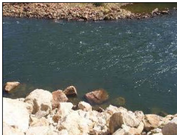
FOTO 2.6: PONTO DE COLETA MUC-03, A JUSANTE DA BARRAGEM DA UHE SANTA CLARA.
