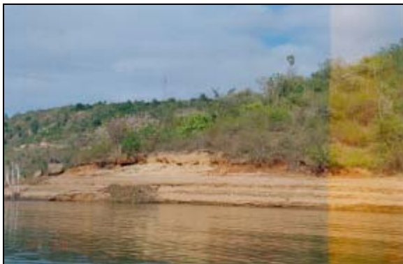
FOTO 7.3: SETOR 371/72, COORD. (UTM) 371.560 / 8.020.672, MARGEM MD. PROCESSO EROSIVO INSTALADO NA FAIXA ESTUDADA, AINDA SEM REFLEXOS EM ALGUM PROCESSO EROSIVO EXISTENTE NA MARGEM, ACIMA DA ELEVAÇÃO 86.
