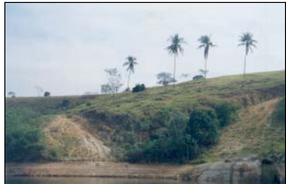
FOTO 7.38: SETOR 372/BARR, COORD. (UTM) 372.658 / 8.021.047, MARGEM ME. PROCESSO EROSIVO INSTALADO NA FAIXA ESTUDADA, AINDA SEM REFLEXOS NO PROCESO EROSIVO EXISTENTE NA MARGEM, ACIMA DA ELEVAÇÃO 86, IDENTIFICADO EM MONITORAMENTOS ANTERIORES COMO E-1B E E-1C.
