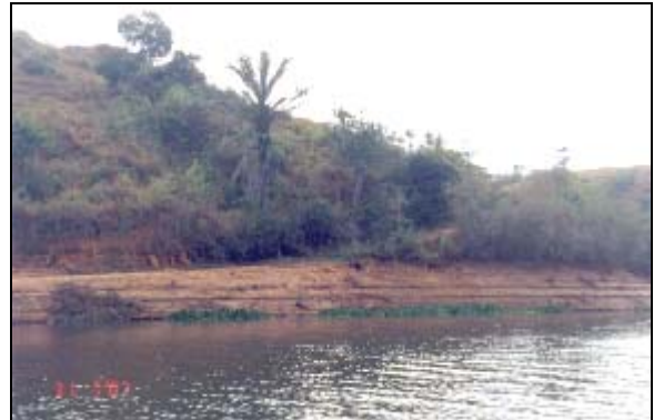
FOTO 7.30: SETOR 367/68, COORD. (UTM) 367.107 / 8.022.961, MARGEM ME. VISTA GERAL DE TRECHO DO SETOR, SEM NENHUMA OCORRÊNCIA DE PROCESSO EROSIVO INSTALADO.
