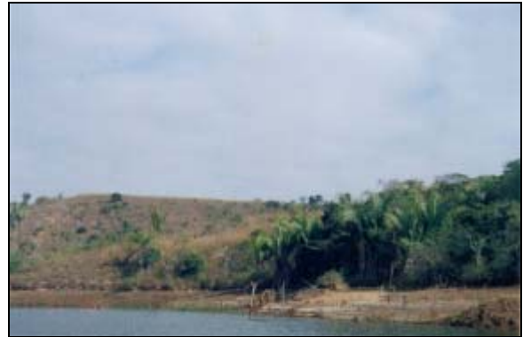
FOTO 7.6: SETOR 370/71, COORD. (UTM) 370.593 / 8.021.986, MARGEM MD. VISTA GERAL DE TRECHO DO SETOR, SEM NENHUMA OCORRÊNCIA DE PROCESSO EROSIVO INSTALADO.
