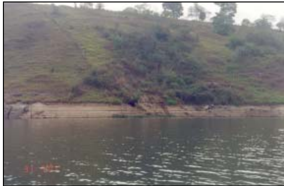
FOTO 7.31: SETOR 367/68, COORD. (UTM) 367.768 / 8.022.508, MARGEM ME. PROC. EROSIVO INSTALADO NA FAIXA ESTUDADA, CAUSANDO LEVE SOLAPAMENTO DE PROC. EROS. NA MARGEM, DE TAMANHO AINDA IRRELEVANTE, LOCALIZADO ACIMA DA ELEVAÇÃO 86, O QUAL FOI IDENTIFICADO EM MONIT. ANTERIORES COMO E8-A.
