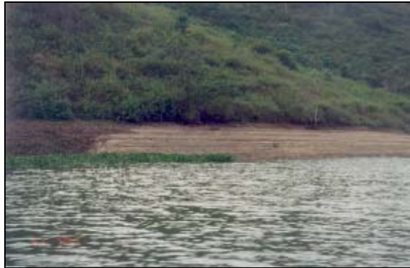
FOTO 7.23: SETOR 364/65, COORD. (UTM) 364.038 / 8.025.047, MARGEM ME. VISTA GERAL DE TRECHO DO SETOR, SEM NENHUMA OCORRÊNCIA DE PROCESSO EROSIVO INSTALADO.
