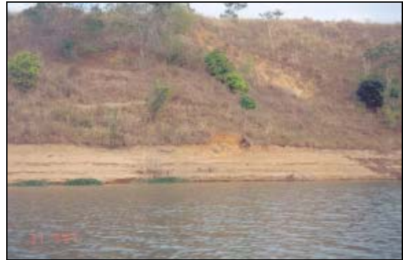
FOTO 7.14: SETOR 365/66, COORD. (UTM) 365.399 / 8.023.424, MARGEM MD. PROCESSO EROSIVO INSTALADO NA FAIXA ESTUDADA, CAUSANDO LEVE SOLAPAMENTO DE PROC. EROSIVO NA MARGEM, DE TAMANHO AINDA IRRELEVANTE, LOCALIZADO ACIMA DA ELEVAÇÃO 86, O QUAL NÃO TINHA SIDO IDENTIFICADO EM MONITORAMENTOS ANTERIORES.
