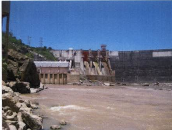
Foto 2 – Barragem da UHE Santa Clara.
