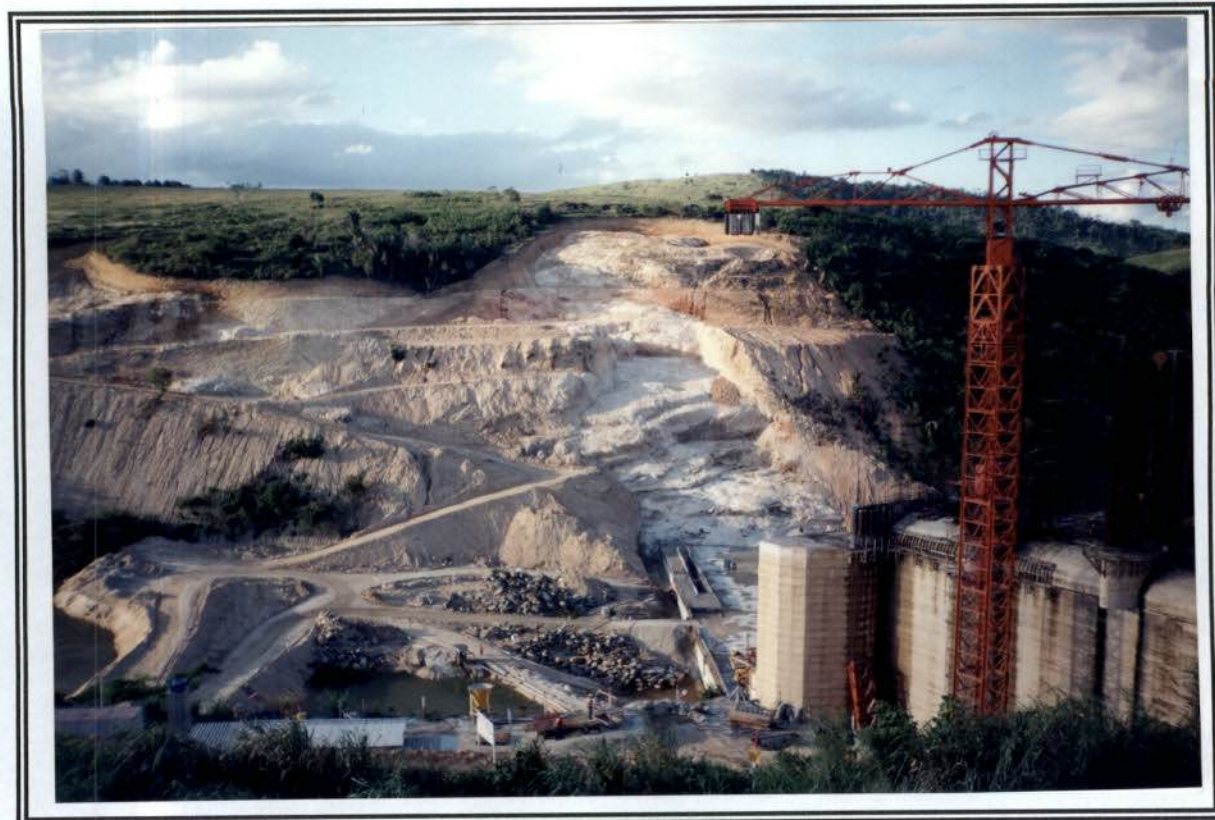
Foto 04 - AHE Santa Clara - Barragem com 60m de altura.
