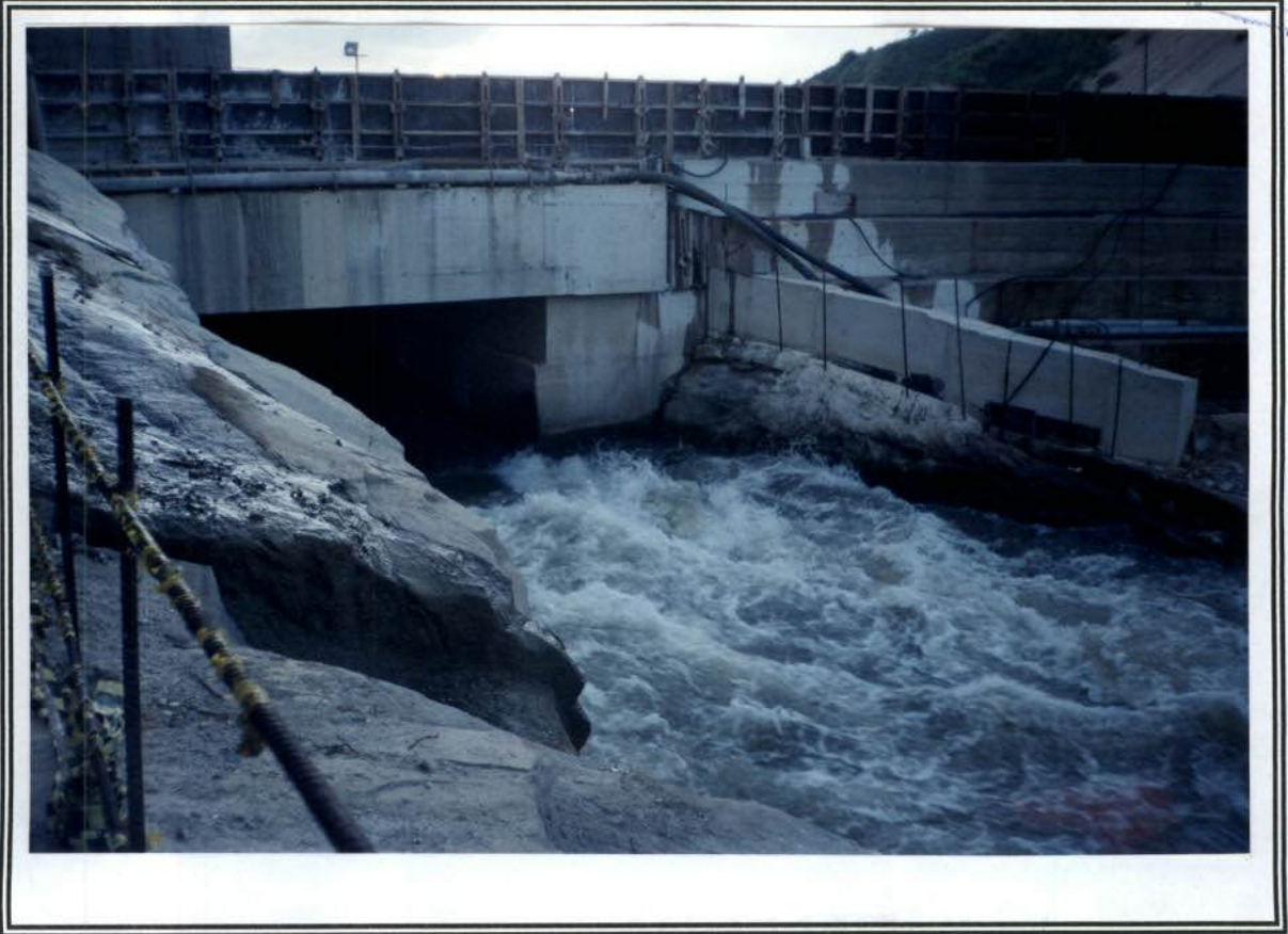
Foto 11 - canal de fuga - jusante.
