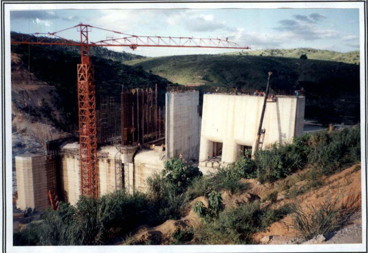
Foto 03 - AHE Santa Clara - Barragem com 60m de altura.
