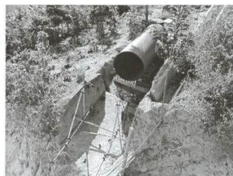
À esquerda, concretagem da fundação do mecanismo; ao centro, armação das estruturas da construção; à esquerda e abaixo, a tubulação
