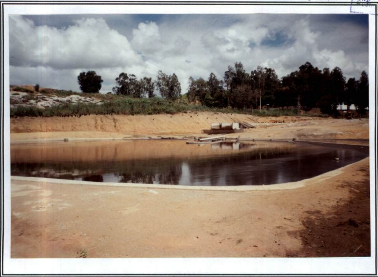
Foto 17 - Estação de Tratamento de Efluentes do FRISA.
