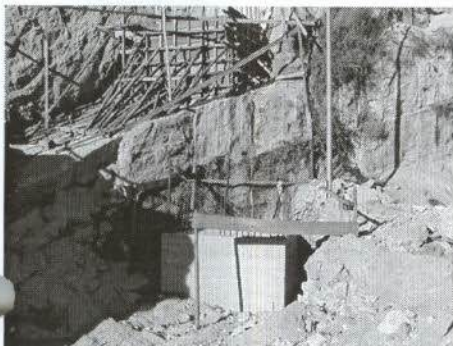
À esquerda, concretagem da fundação do mecanismo; ao centro, armação das estruturas da construção; à esquerda e abaixo, a tubulação
