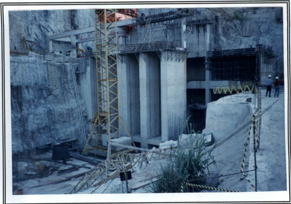
Foto 06 - Local onde serão instaladas as turbinas da usina.
