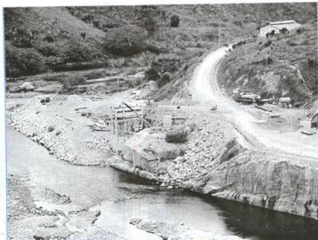
Acima e ao lado, estrutura de concreto do mecanismo
