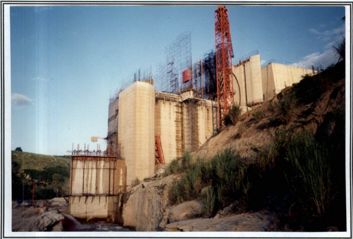
Foto 02 - AHE Santa Clara - Barragem com 60m de altura.
