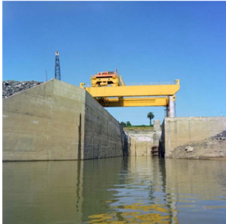
Figura 101i/b – Detalhe do Atracadouro do Pórtico (Fonte: Eletronorte)
