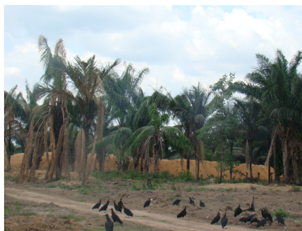
Foto 84/16 - Lagoas de decantação de efluente
