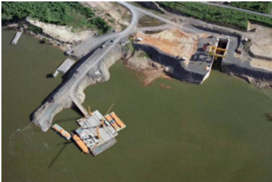
Figura 101i/a – Vista Geral do Porto do AHE Tucuruí (Fonte: Eletronorte)
