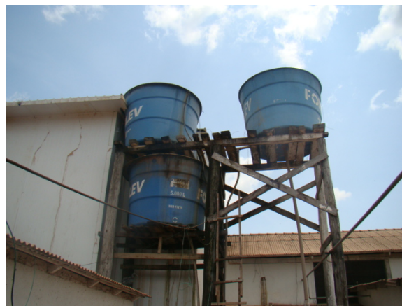
Foto 84/14 - Caixa d'água do Frigorífico Friara
