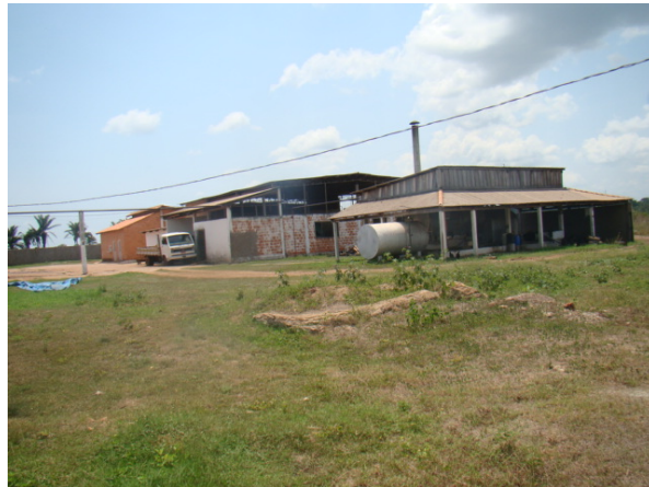
Foto 84/06 - Instalações do Frigorífico e Matadouro
