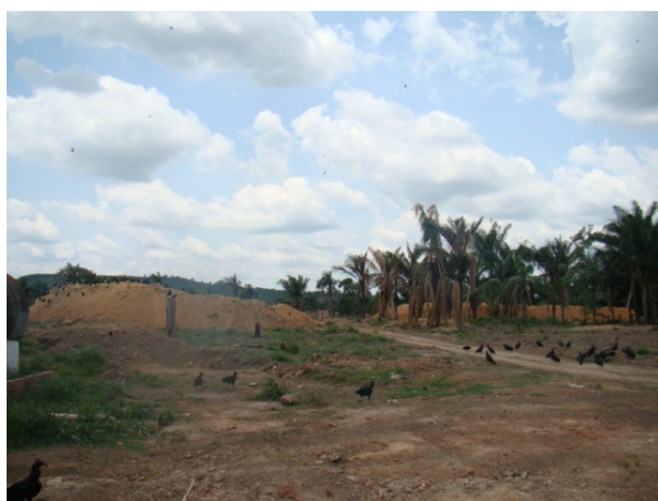
Foto 84/15 - Lagoas de decantação de efluente
