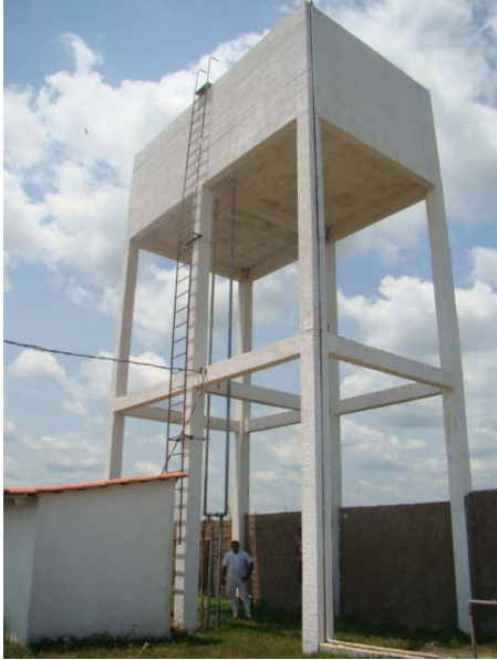
Foto 84/03 - Caixa d'água de 50.000 litros
