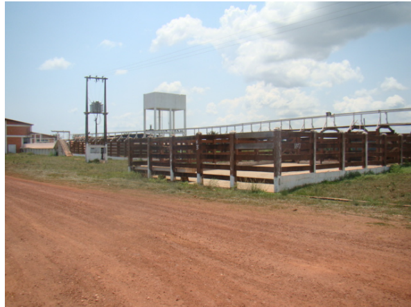
Foto 84/04 - Instalações do Frigorífico e Matadouro
