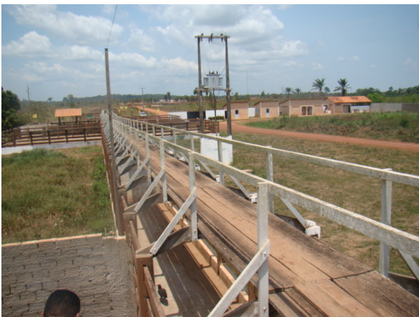
Foto 84/07 - Instalações do Frigorífico e Matadouro
