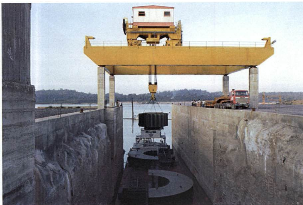
Figura 2/03: Detalhe do Atracadouro do Pórtico deslocando equipamento de grande porte.
