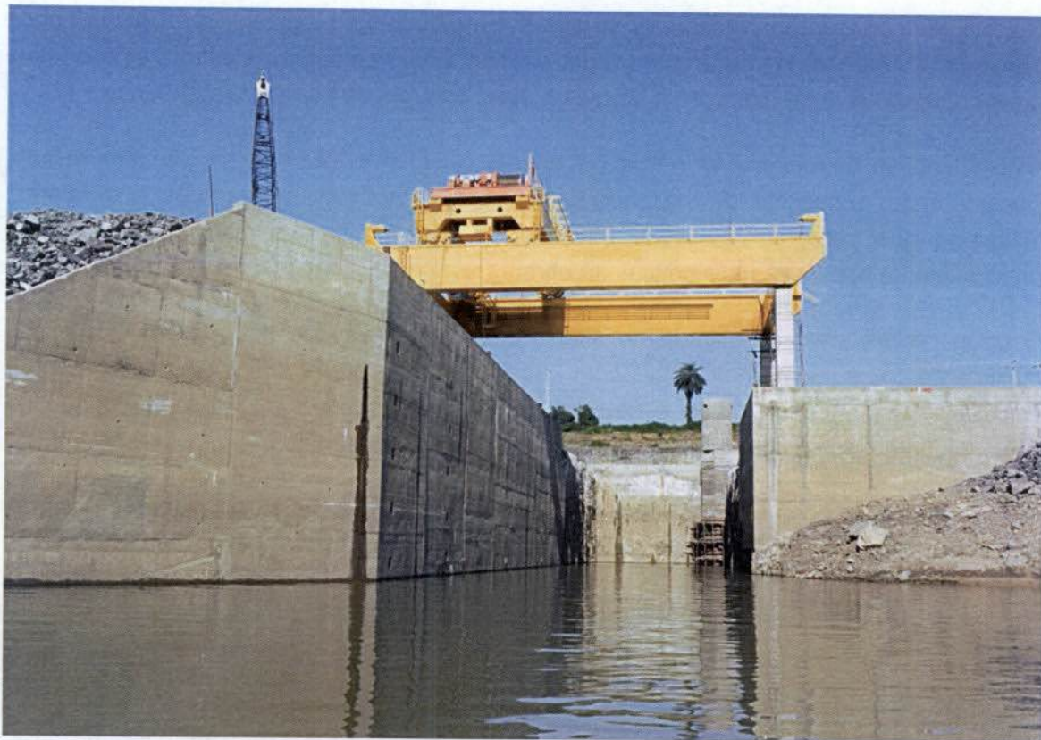
Figura 2/02: Detalhe do Atracadouro do Pórtico.
