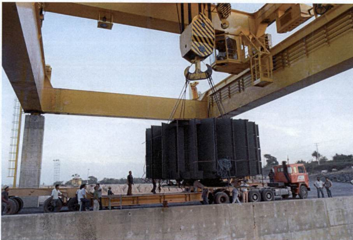
Figura 2/04: Detalhe do Pórtico deslocando equipamento de grande porte.
