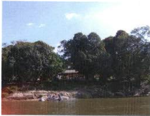
Foto 15 – Comunidade de Pimental, ponto de possível implantação do eixo da barragem
