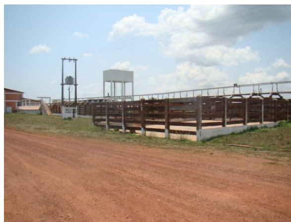
Foto 02/23 – Instalações do Frigorífico e Matadouro Frivata
