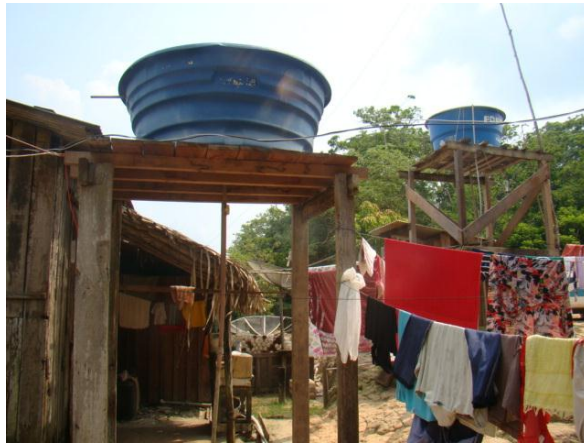
Foto 05/03 – Caixa d'água do Buburé
