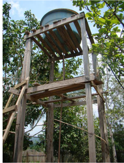
Foto 35/06 – Caixa d'água da moradia do Sr. João
