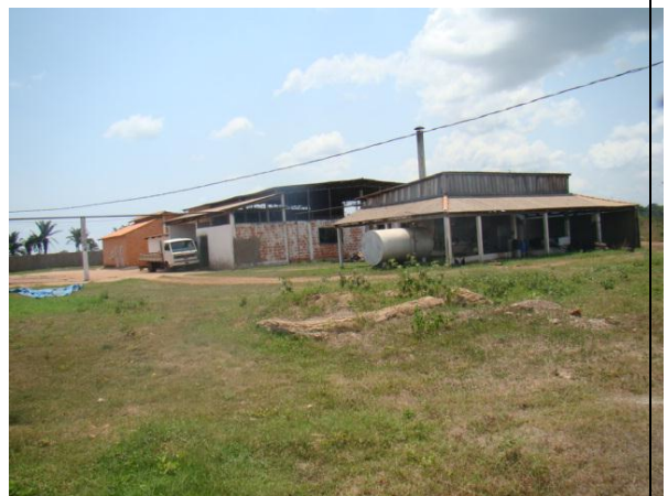
Foto 02/25 – Instalações do Frigorífico e Matadouro Frivata
