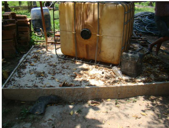
Foto 25/29 – Local da fossa da residência do Sr. Francisco (Chico Maratá)
