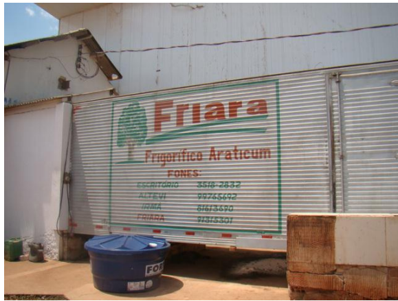
Foto 02/32 – Instalações do Frigorífico Friara
