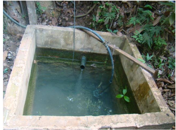
Foto 02/02 - Cacimba de 1,2m de profundidade – água o ano todo.
