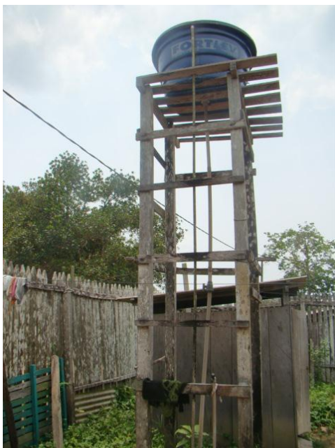
Foto 35/11 – Caixa d'água da moradia do Sr. José e Dona Genuína
