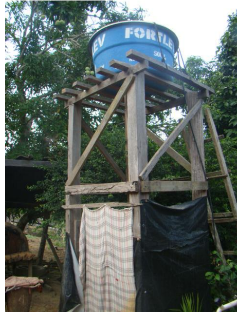
Foto 25/48 – Caixa d'água da moradia do Sr. José Francisco.
