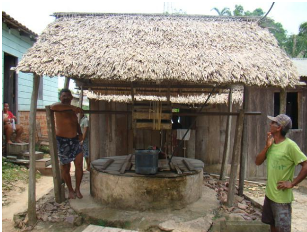
Foto 24/09 – Cobertura da cacimba.
