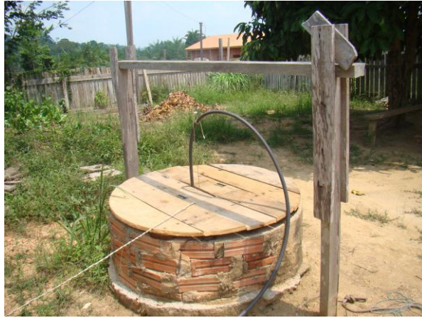
Foto 38/05 – Cacimba com profundidade de 15,50m da moradia do Sr. João
