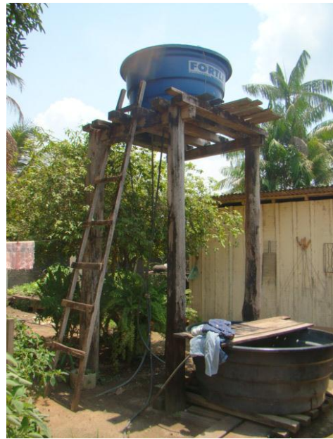
Foto 38/02 – Caixa d'água do Sr. Izaque.
