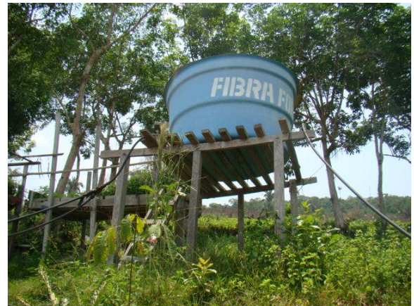
Foto 16/02 – Caixa d'água no Jatobá.
