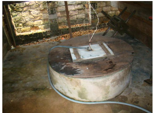
Foto 35/10 – Detalhe da cacimba da moradia do Sr. José e Dona Genuína
