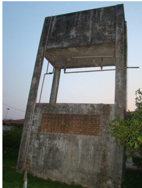
Foto 34/06 – Caixa d'água de 15.000L do Hospital Municipal.
