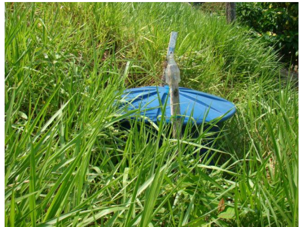
Foto 14/02 – Caixa d'água onde a água da nascente é armazenada.
