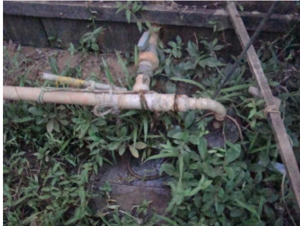
Foto 34/07 – Poço tubular profundo da Escola Instituto de Educação.
