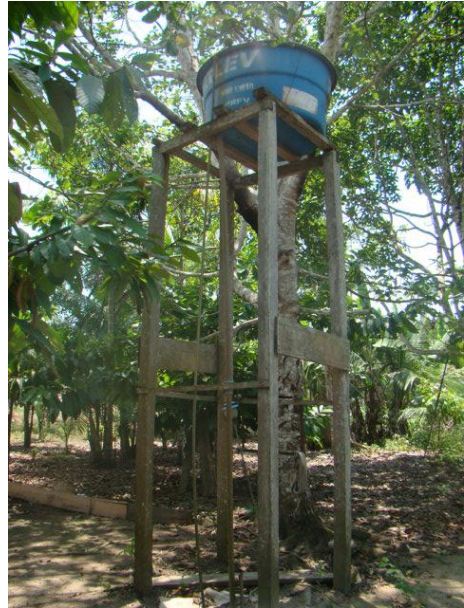
Foto 25/32 - Caixa d'água da residência do Sr. Sebastião Barbosa.
