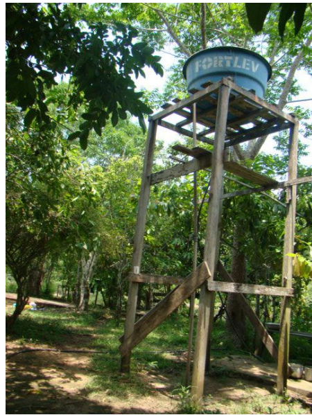
Foto 25/28 – Caixa d'água da moradia do Sr. Francisco (Chico Maratá)
