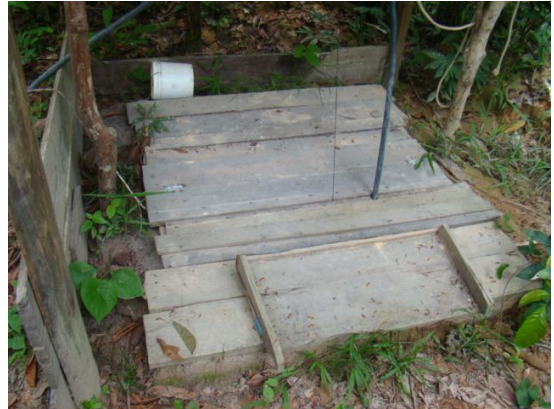
Foto 25/08 – Detalhe da cacimba na moradia de Dona Isandrea.
