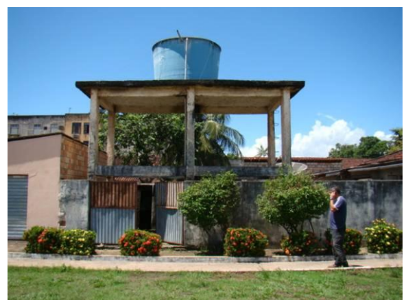
Foto 01/10 – PTP 13 detalhe da caixa d'água no Banco do Brasil
