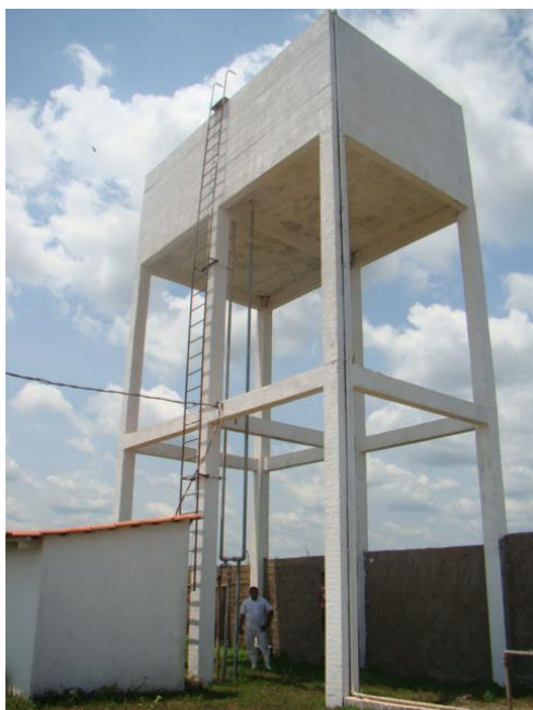
Foto 02/22 - Caixa d'água de 50.000L no Frigorífico Frivata
