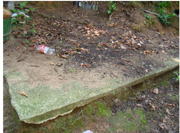
Foto 29/02 – Local da fossa séptica.
