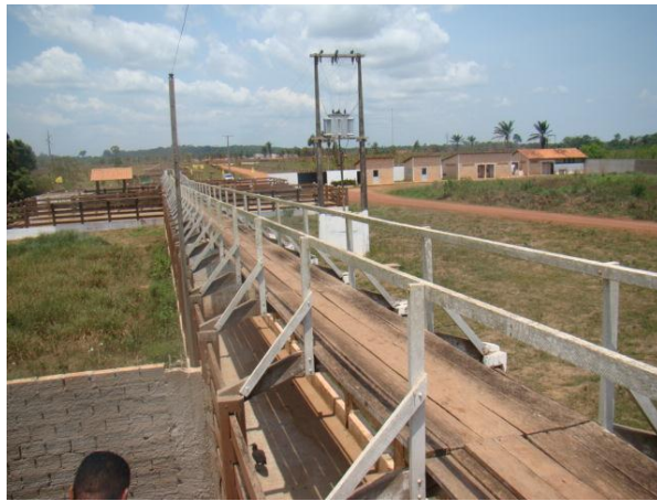
Foto 02/26 – Instalações do Frigorífico e Matadouro Frivata
