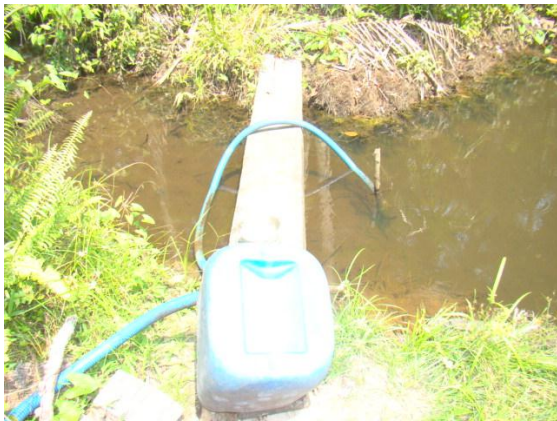
Foto 10/01 – Captação de água no igarapé Palmital
