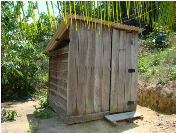
Foto 19/07 – Sanitário no Machado
