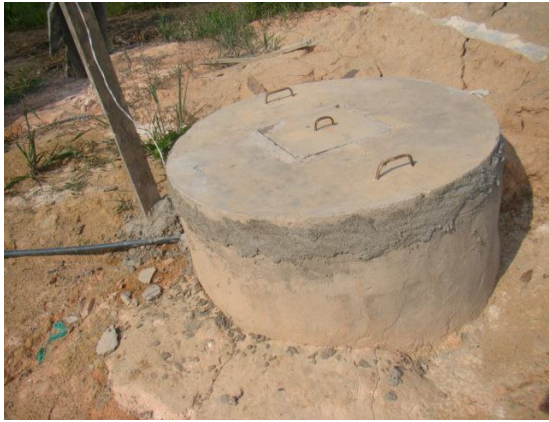
Foto 37/03 – Cacimba da escola – não está em uso, sem ligação elétrica.
