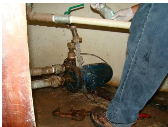
Foto 01/09 - PTP 12 amostragem de captação de água subterrânea no Hotel Apicás
