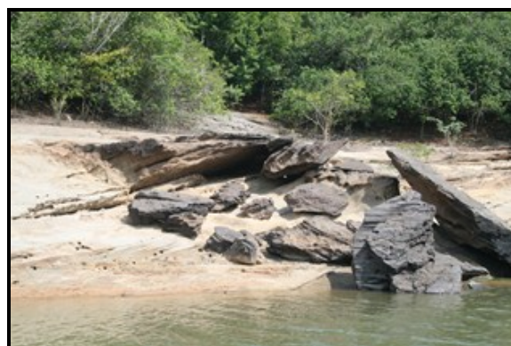
Foto 02: Abrigo por blocos abatidos e inclinação do pacote rochoso.
