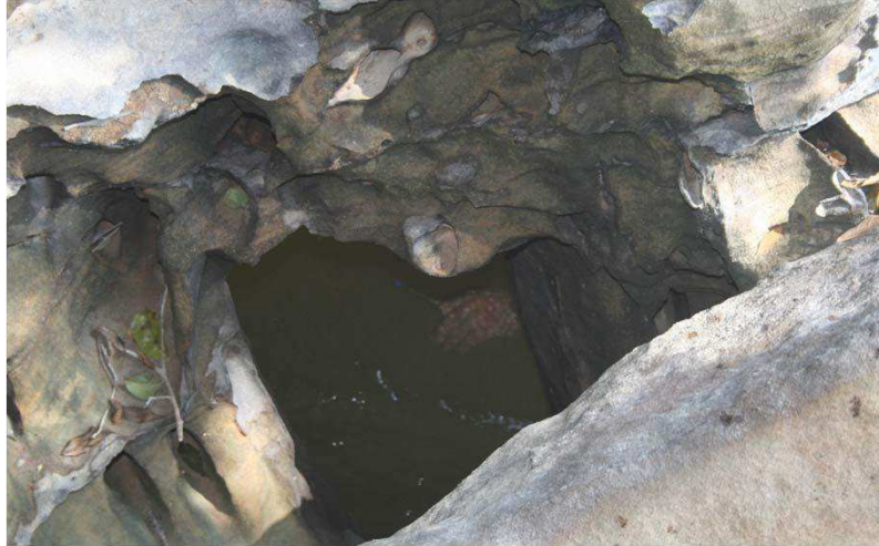
Foto 04: Detalhe da claraboia existente na TAP-02 .
