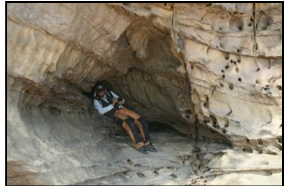
Foto 02: Entrada do abrigo com plano de fratura subvertical.
