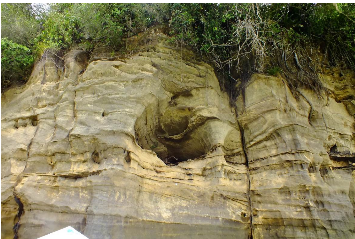
AB 11 (Abrigo da Paca) Vista Frontal.
