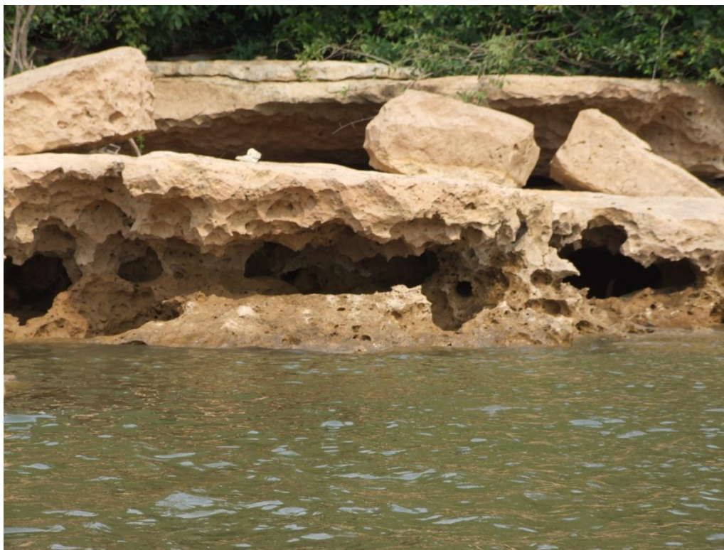
Foto 7.4.1.10/11 – Feições de dissolução, abrasão e blocos caídos por solapamento em margem baixa em calcário pouco fraturado da Formação Itaituba (Coordenadas UTM 0606109 x 9525491).
