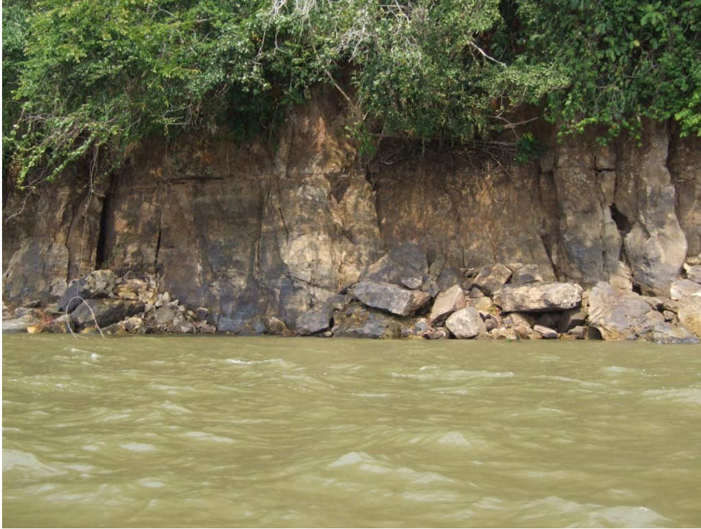
Foto 7.4.1.10/13 – Queda de blocos angulosos, de arenito da Formação Monte Alegre, condicionados ao sistema de juntas e a processos de erosão por arranque (Coordenadas UTM 0603865 x 9523882).
