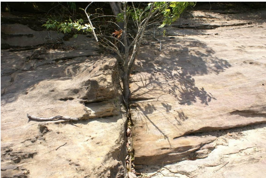
Foto 42 - Sistema de fraturas N60 - 70° W/V propiciando o desenvolvimento da vegetação devido à alteração do material cisalhado.
