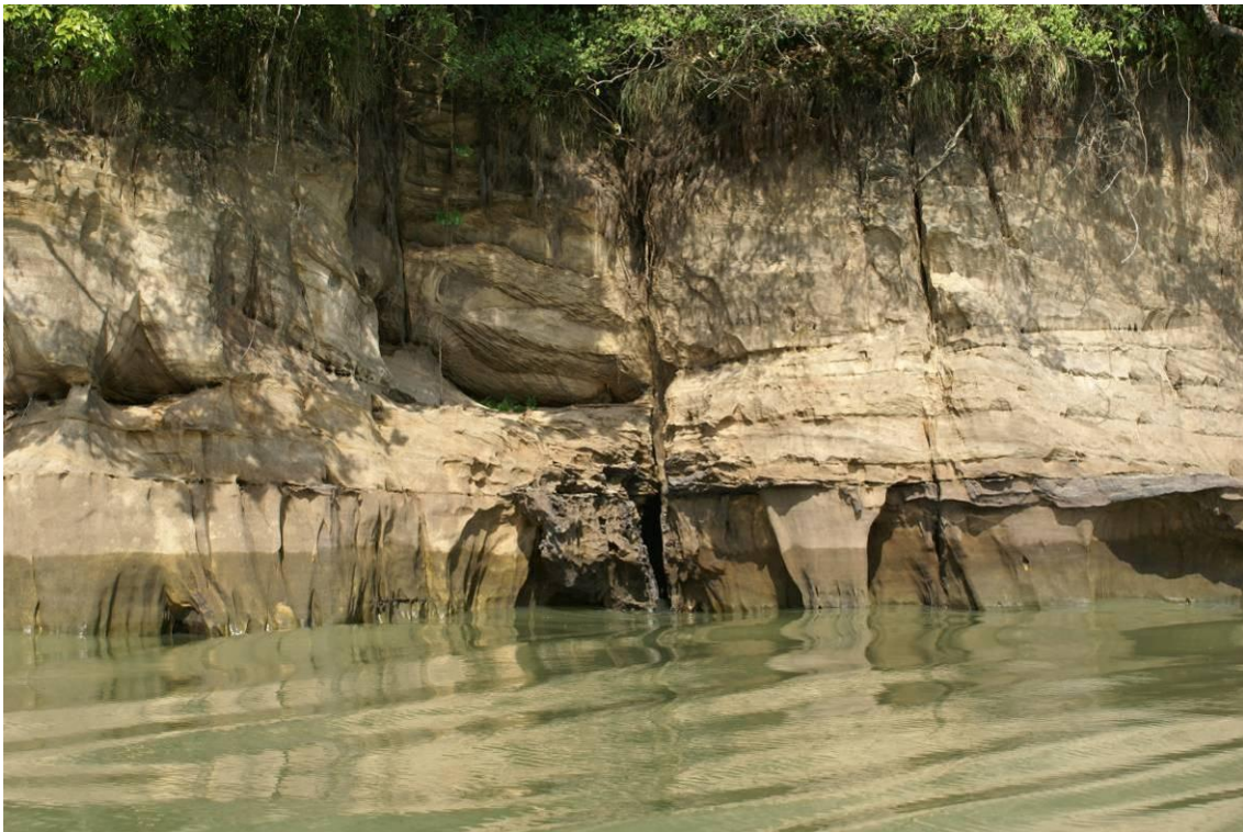
Foto 14 – Aspecto geral do paredão de arenito com intensificação do sistema de fraturas NW/V e material limonítico acompanhando os planos de fratura e o acamamento / estratificação.
