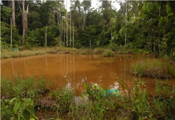
Foto 7.4.2.2.2.4.1/09 - Igarapé represado pela rodovia Transamazônica 2 (jusante)
