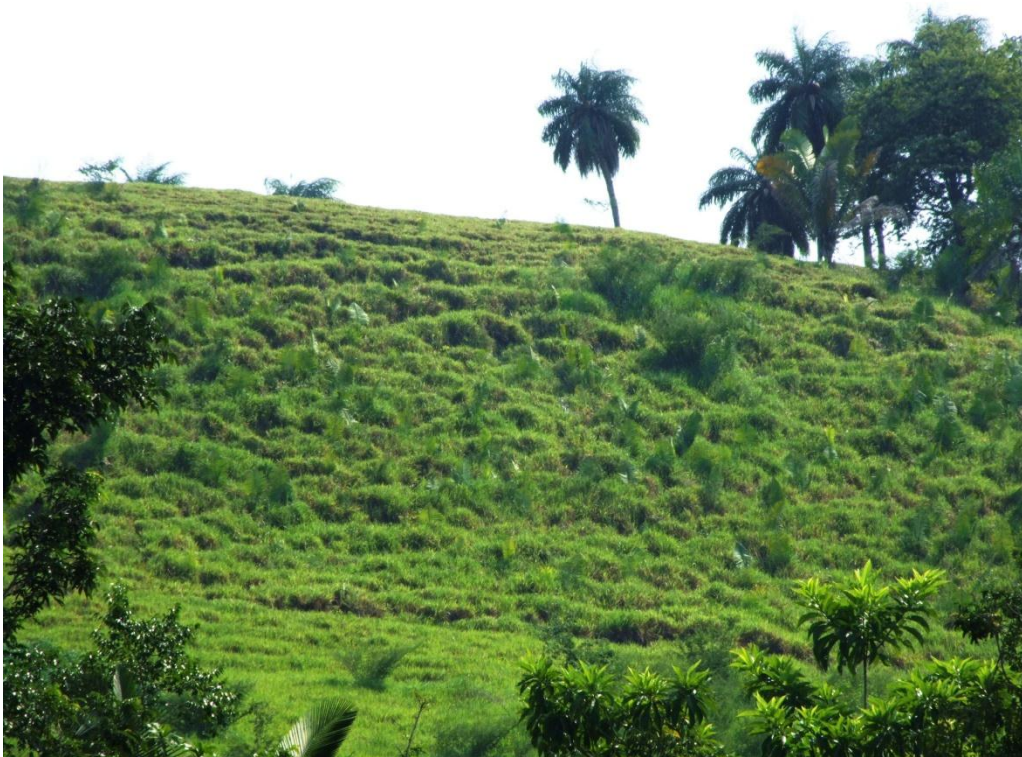
Foto 7.4.1.10/24 – Degraus de rastejo ocasionais e de baixa a média intensidade, que ocorrem em encosta inclinada de relevo Colinas pequenas, na margem direita do rio Tapajós. (Coordenadas UTM 0599785 x 9514845).
