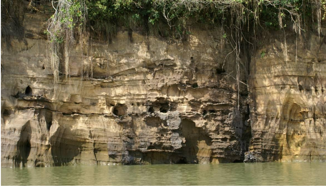
Foto 19 – Aspecto geral de paredão arenítico onde pode ser salientado a interseção de fraturas do sistema NW com o sistema NE, ambas subverticais. Notar a maior concentração de material limonítico junto aos planos de faturamento e acompanhando os planos de acamamento e da estratificação cruzada.
