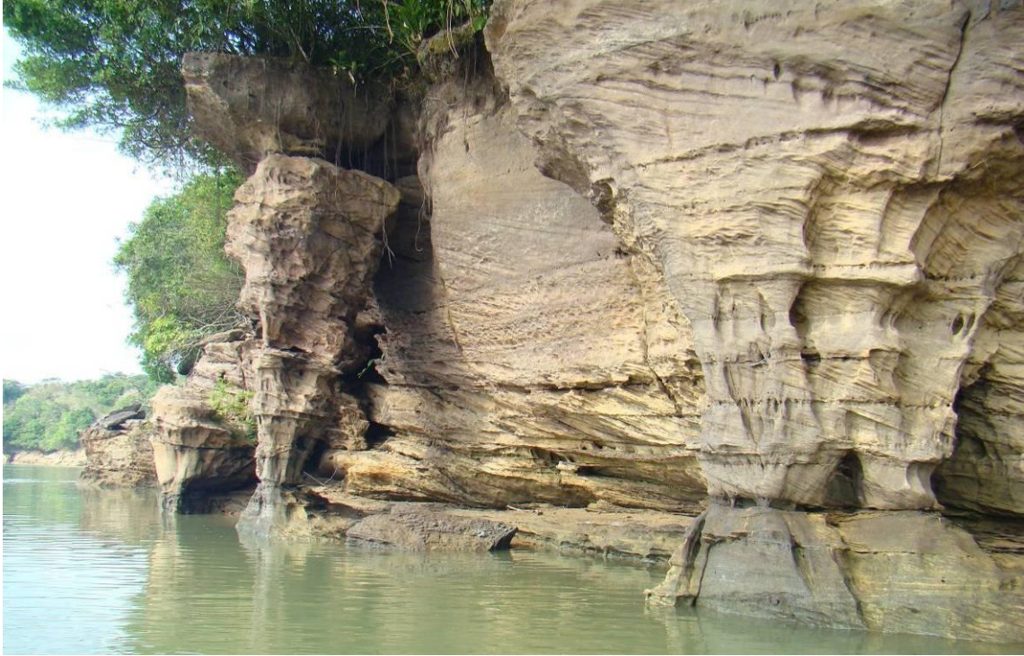
Foto 45 - Abrigo 5 (Abrigo Perna do Boi) - Aspecto geral do paredão arenítico com o desenvolvimento de colunas controladas pela estruturação litológica e mostrando instabilização na porção superior
