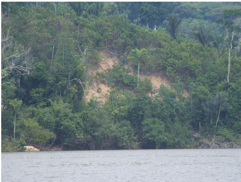
Foto 7.4.1.10/81 – Escorregamento planar ocasional e de baixa intensidade que ocorre nas encostas íngremes do relevo de Morros e Morrotes (Coordenadas UTM 521088 x 9445602).
