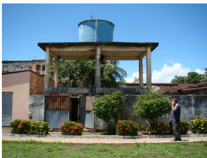
Foto 7.4.1.1.3.2/09 - Ponto 09 – Poço Profundo em Itaituba – Conjunto de 12 casas – Data: 17/04/2012.
