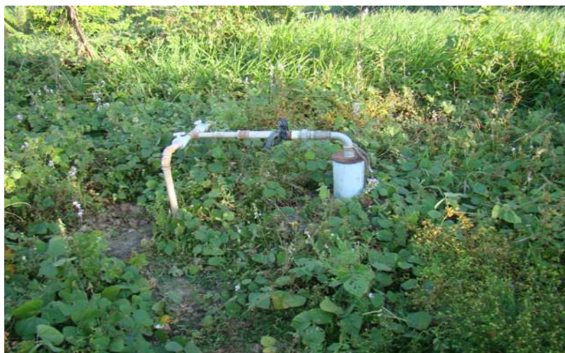
Foto 7.4.1.1.3.2/02 - Ponto 02 – Poço Profundo em Jamanxinzinho/Trairão – Madeireira Tapajós – Data: 01/07/2012.
