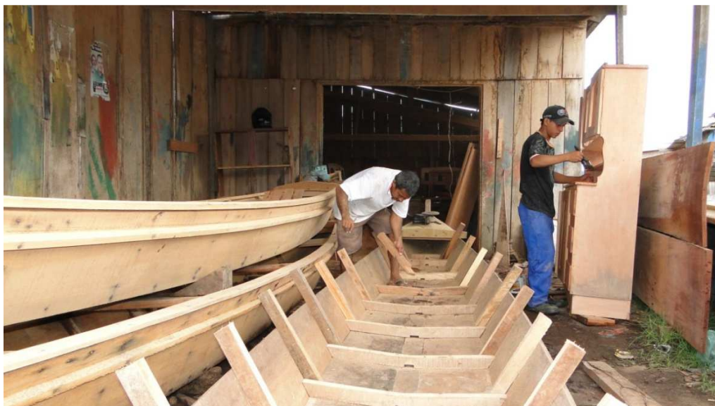
Foto 7.3.3.11.2.2.1.2/03 – Construção de “casco de rabeta”, em Vila Nova, Itaituba. Acervo Scientia/Ricardo Santos
