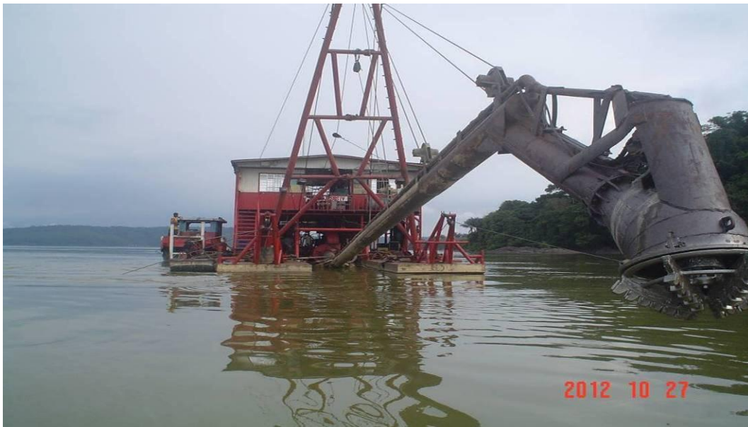
Foto 7.3.1.4.2.3/01 - Detalhe da lança com o “abacaxi” na extremidade, de uma Draga “Escarilhança”, trabalhando próximo à margem direita, no leito do rio Tapajós (SIRGAS 2000/21M/518362/9436536).
