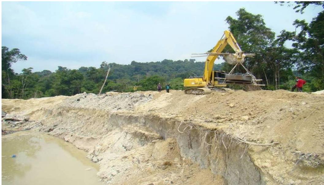
Foto 7.3.1.4.2.3/05 – Escavadeira hidráulica de esteiras, conhecida no garimpo como “PC”, auxiliando na mudança da “bica” ou caixa concentradora, escavação ao lado efetuada com a escavadeira, em aluviões do rio Ratão (SIRGAS 2000/21M/514296/9396930).
