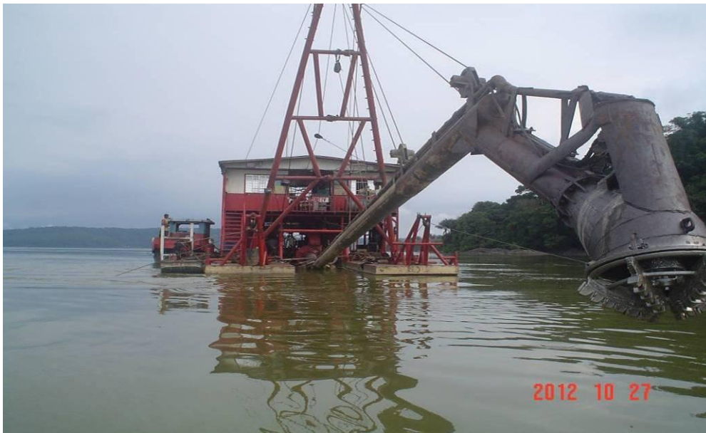
Foto 7.3.1.2.2.8.3.1/01 – Detalhe da lança com o “abacaxi” na extremidade, de uma Draga “Escarilança”, trabalhando próximo à margem direita, no leito do rio Tapajós (SIRGAS 2000/21M/518362/9436536).
