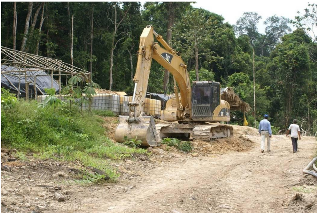
Foto 7.3.1.4.5.1/03 – Escavadeira hidráulica de esteiras (PC) em um ponto de apoio (abastecimento), no igarapé São João, garimpo Chapéu de Sol (SIRGAS 2000/21M/533766/9465592).
