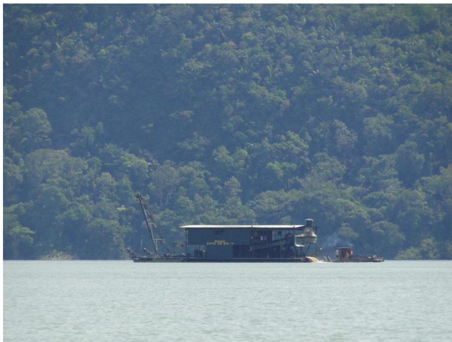
Foto 5.3.2/01 -: Dragagem localizada no rio Tapajós, dentro da área do futuro reservatório, Itaituba.
