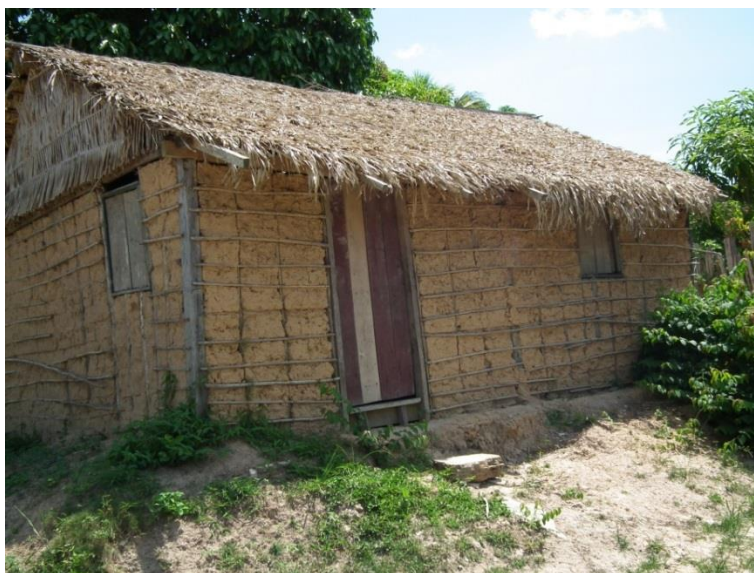
Foto 5.2.2/03 - Exemplo de casa utilizada pelos indígenas na Vila de São Luiz do Tapajós, o telhado é feito de folhas de palmeiras (Inajá e Babaçu), as amarrações são feitas de cipó-titica e a estrutura em madeira.
