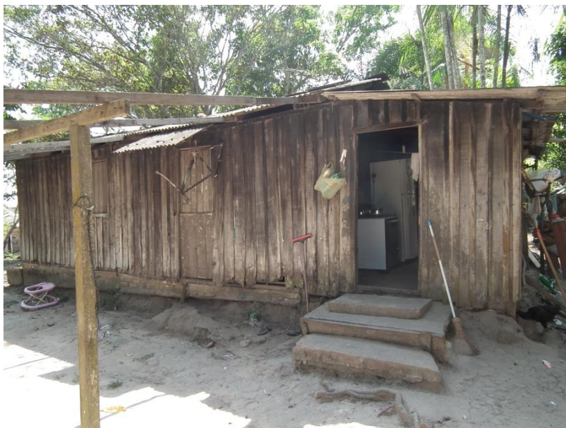
Foto 5.2.2/02 - Casa de madeira comprada em serrarias de Itaituba, TI Praia do Índio.
