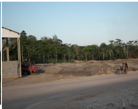
Foto 5.3.5/02 - Loteamento em fase de construção localizado nos limites da TI Praia do Índio, Itaituba.
