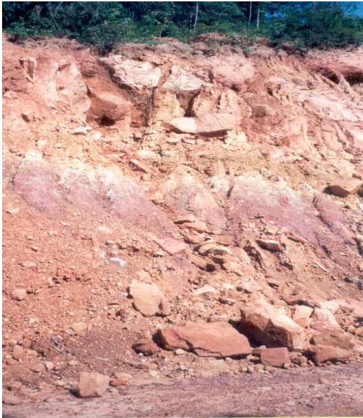
Figura 5.6-1 Mecanismo 1 - Queda de blocos por erosão diferencial no talude.
