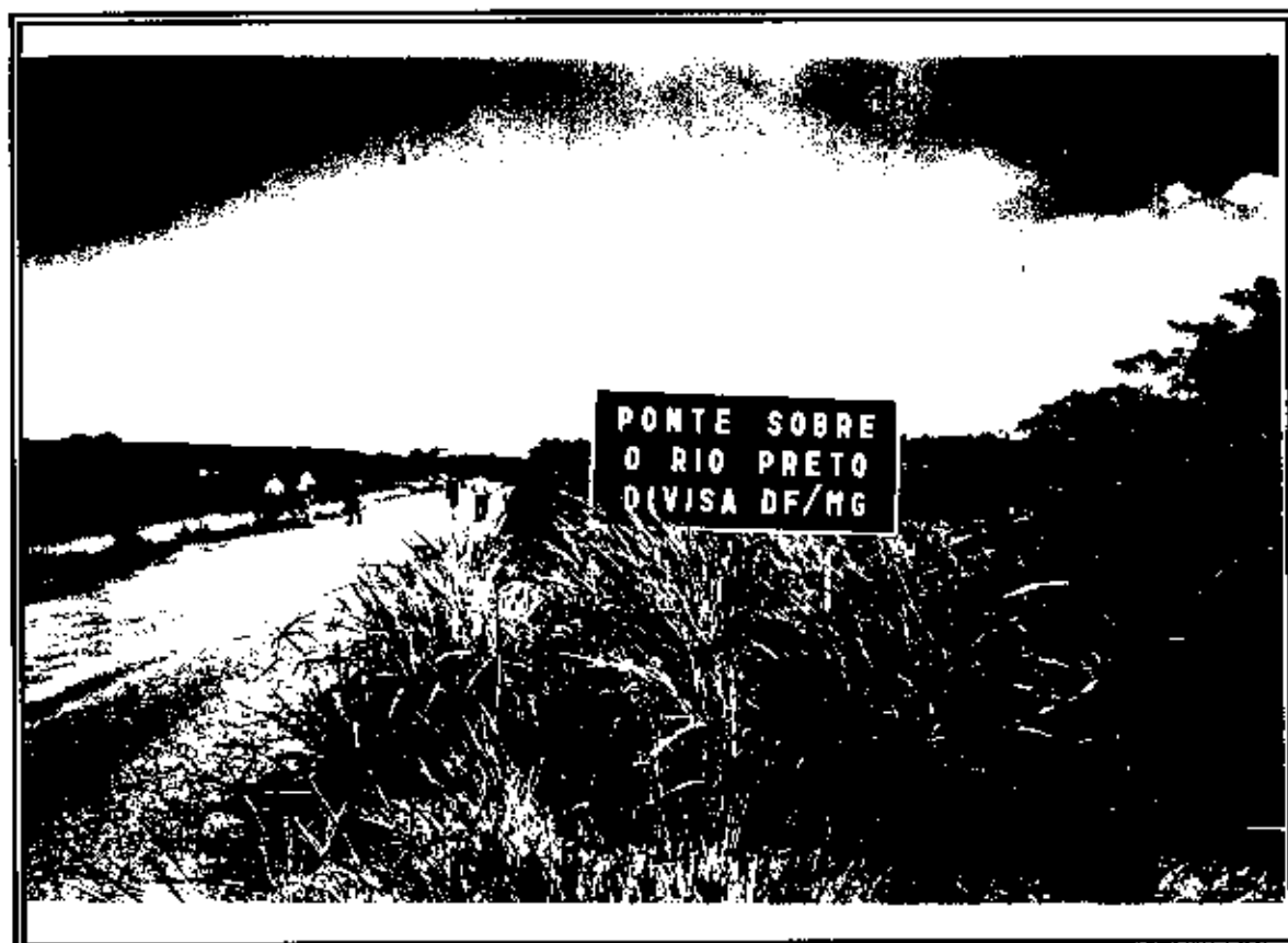
Foto 09 - Ponte na divisa DF/MG que será relocada.
