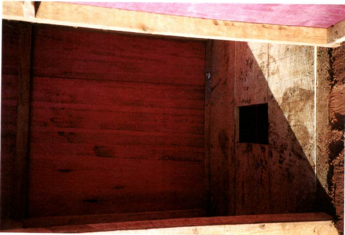
FOTO IV - Banheiro de casa provisória, reassentamento de Bataguassu/MS
