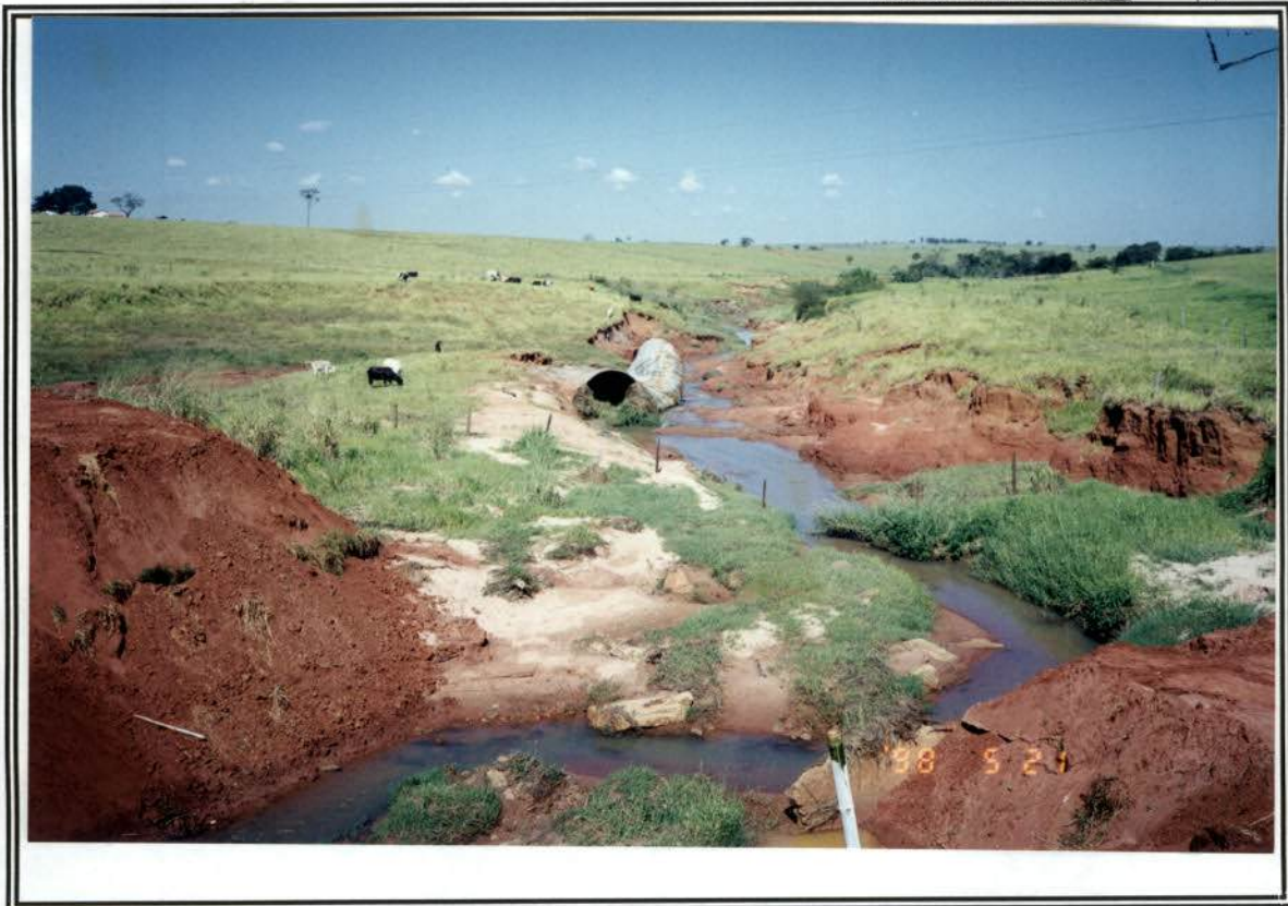
foto 7 - Problemas no manejo e conservação dos solos na bacia. Erosão e voçorocamento do leito da estrada SP 583.
