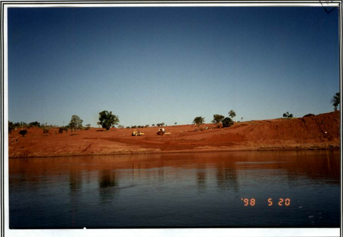
foto 5 - Parque do Figueiral terraplanagem em andamento e transplante das figueiras.
