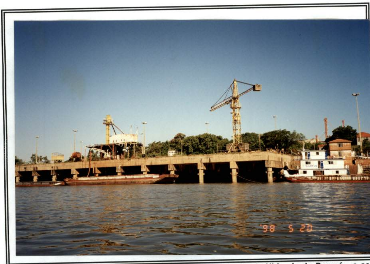
foto 10 - Plataforma do Porto da Companhia de Navegação da Hidrovia do Paraná - a ser removido para a cota 259. Pilares permanecerão submersos.
