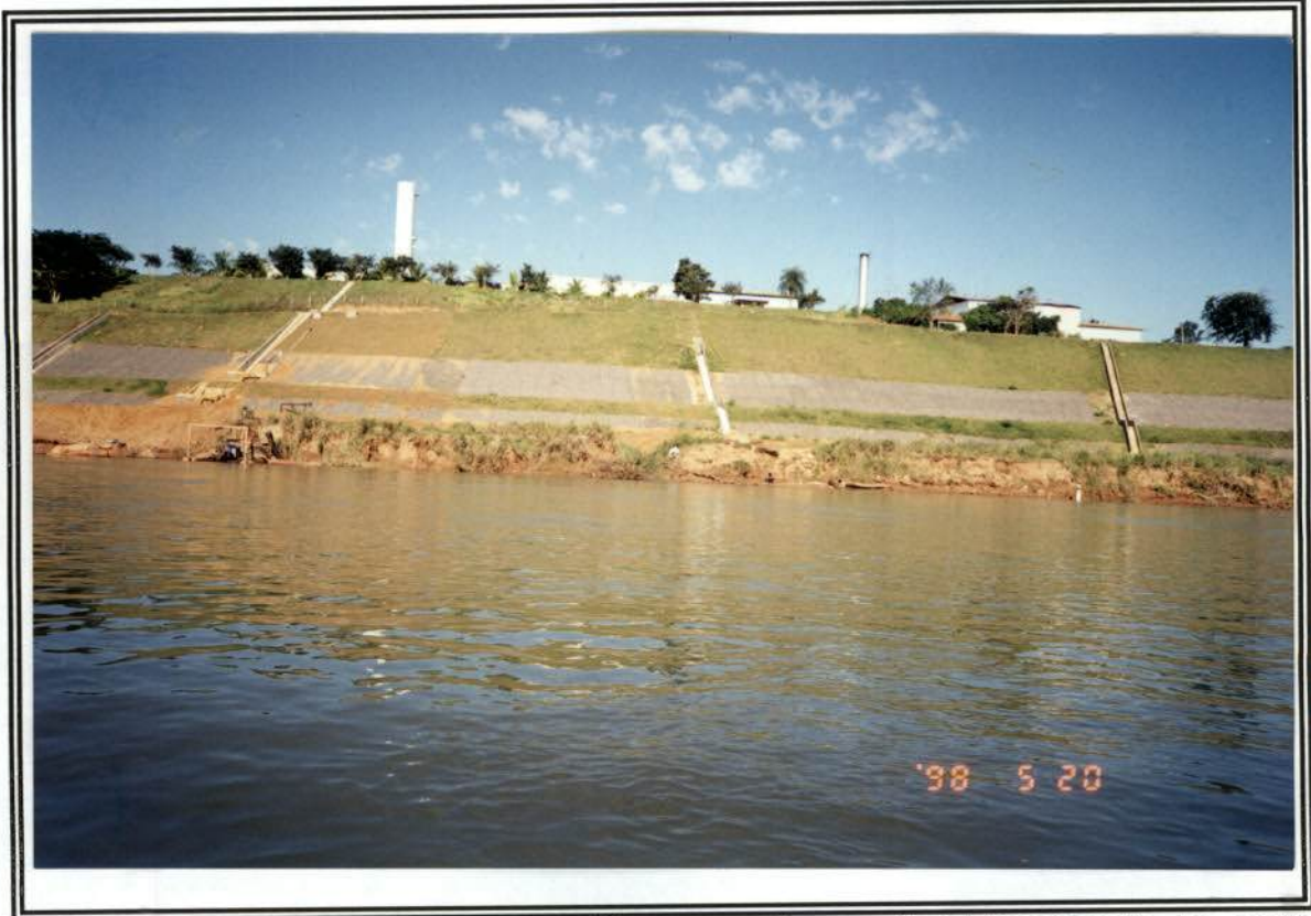
foto 2 - Frigorífico Bordoun, encosta já se encontra protegida/recuperada, no canto esquerdo. No centro da foto, drenagens para extravasamento de água e esgoto do frigorífico.
