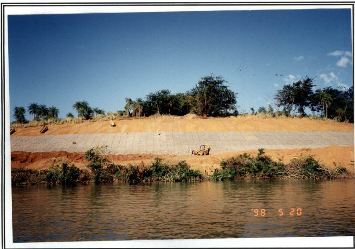
foto 4 - Proteção das margens com gabião e manta de "Bidin".
