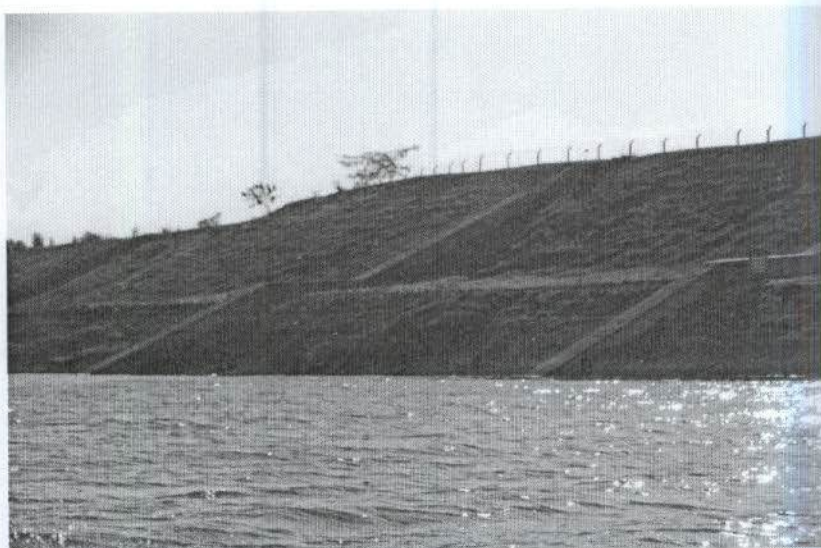
Encostas protegidas com gabião
