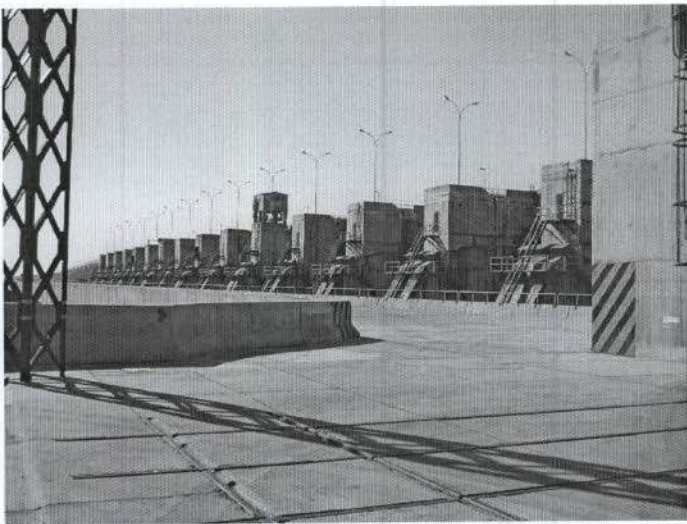
Foto 43: Vista das estruturas para comportas da UHE.
