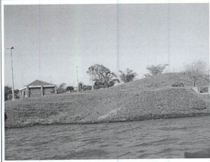
Foto 33: Margem já recuperada.
