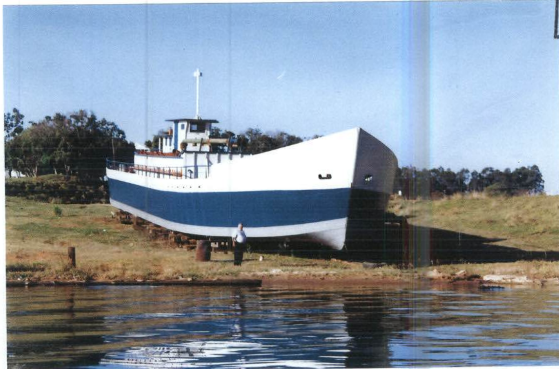
EMBARCAÇÃO EM FASE FINAL DE CONSTRUÇÃO
