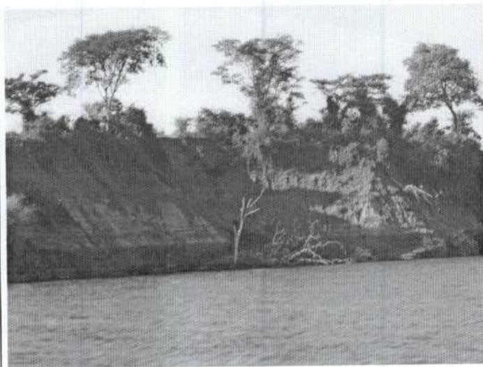
Foto 21: Processo erosivo as margens do lago (Presidente Epitácio).
