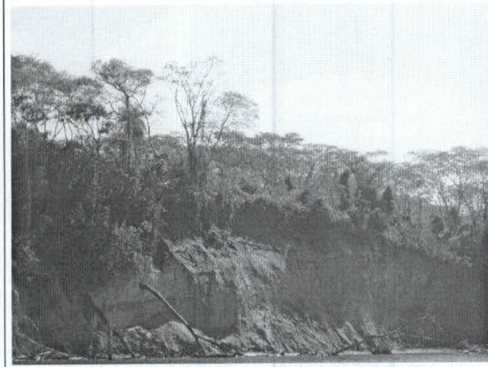
Foto 29: Processo erosivo as margens do lago (Paredão das Araras).
