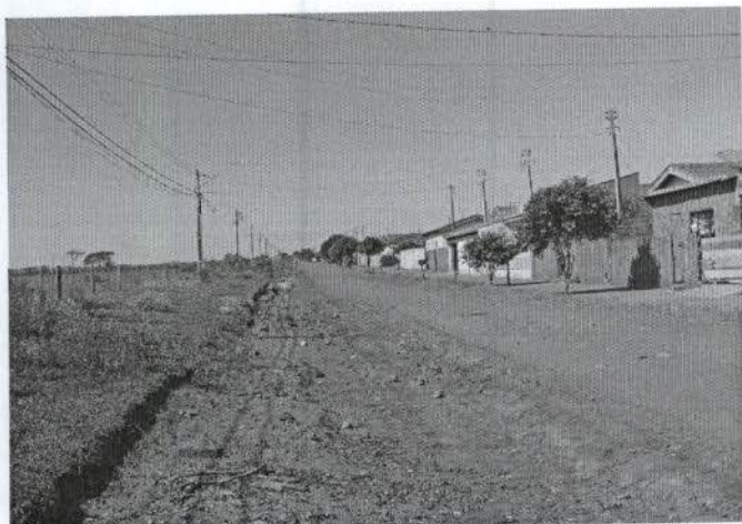
Rua no reassentamento Alto do Mirante
