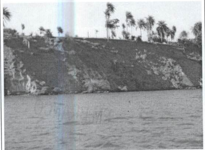
Foto 22: Processo erosivo as margens do lago (Presidente Epitácio).
