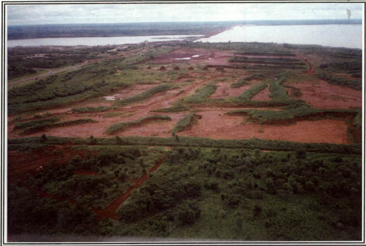
Foto 05. Área de empréstimo - Margem esquerda (lado de São Paulo).
