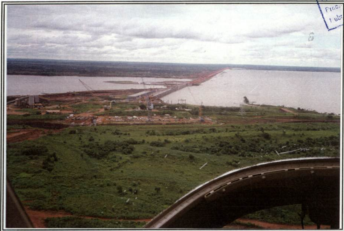
Foto 01. Vista Geral da UHE Porto Primavera - Barragem de Terra (lado Mato Grosso do Sul) e Vertedouro (lado de São Paulo).
