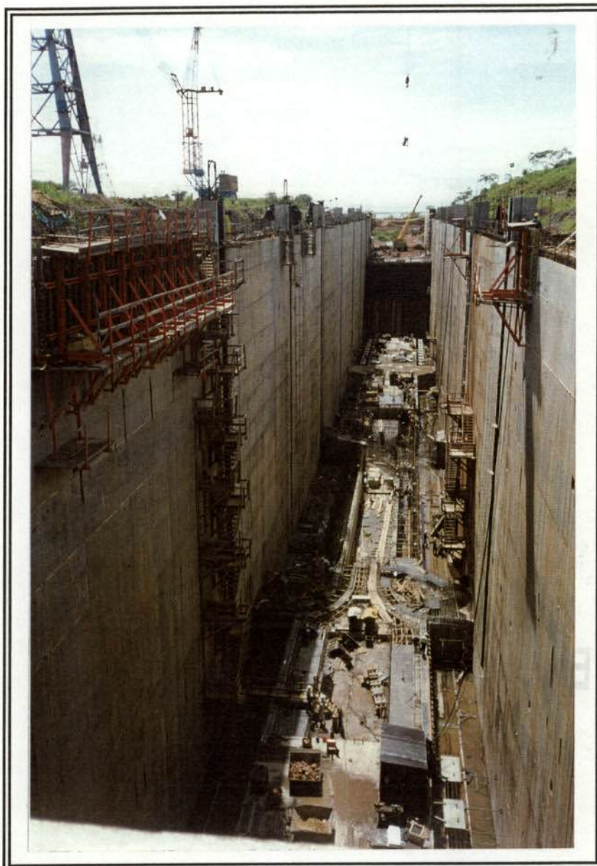
Foto 13. Vista Geral da Eclusa definitiva - dimensões: 210m de comprimento e 17m de largura.
