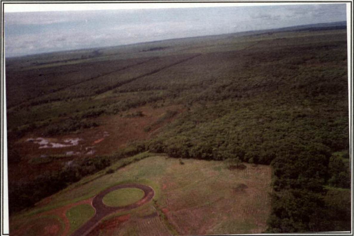
Foto 08. Área de empréstimo recuperada da UHE Rosana.
