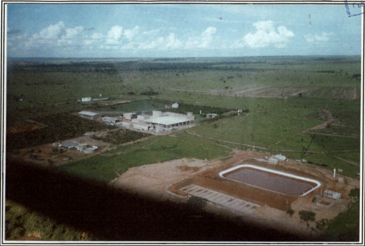
Foto 54. Futura estação de tratamento de esgoto.
