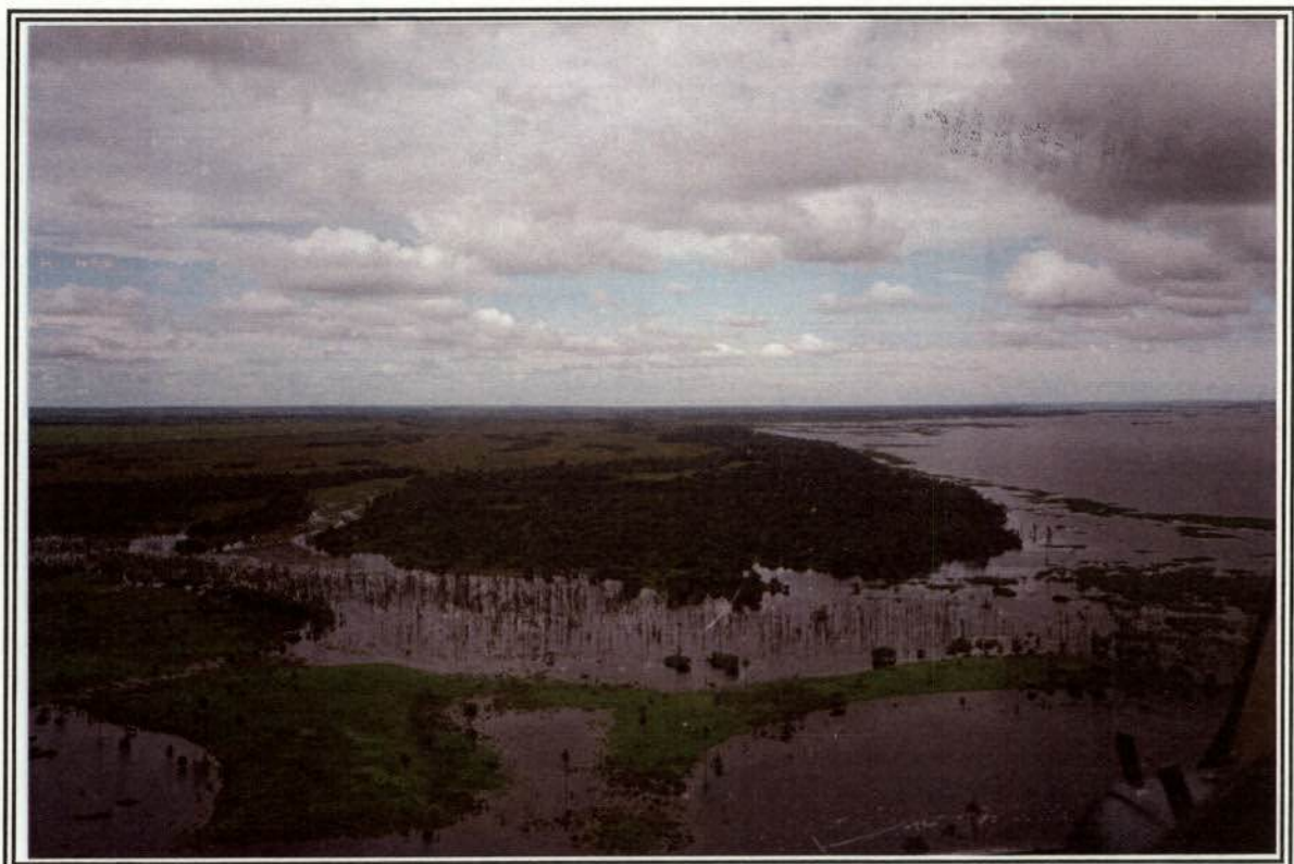
Foto 25. Vista da área alagada à montante da barragem.
