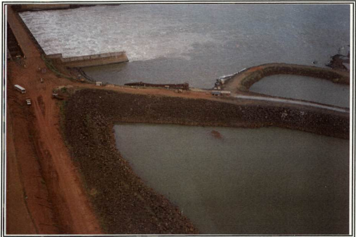
Foto 18. Vista da área destinada a escada experimental de peixes.
