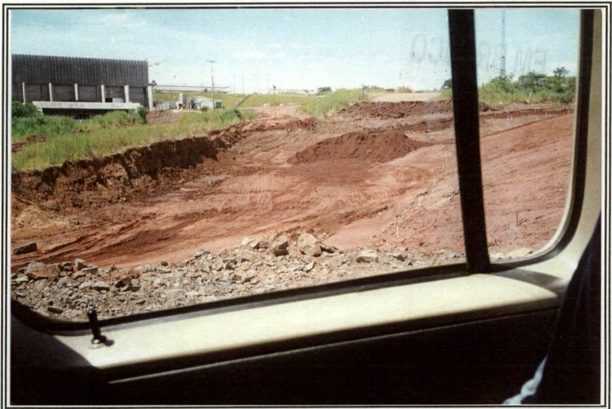
Foto 17. Vista da área escavada para escada de peixes.
