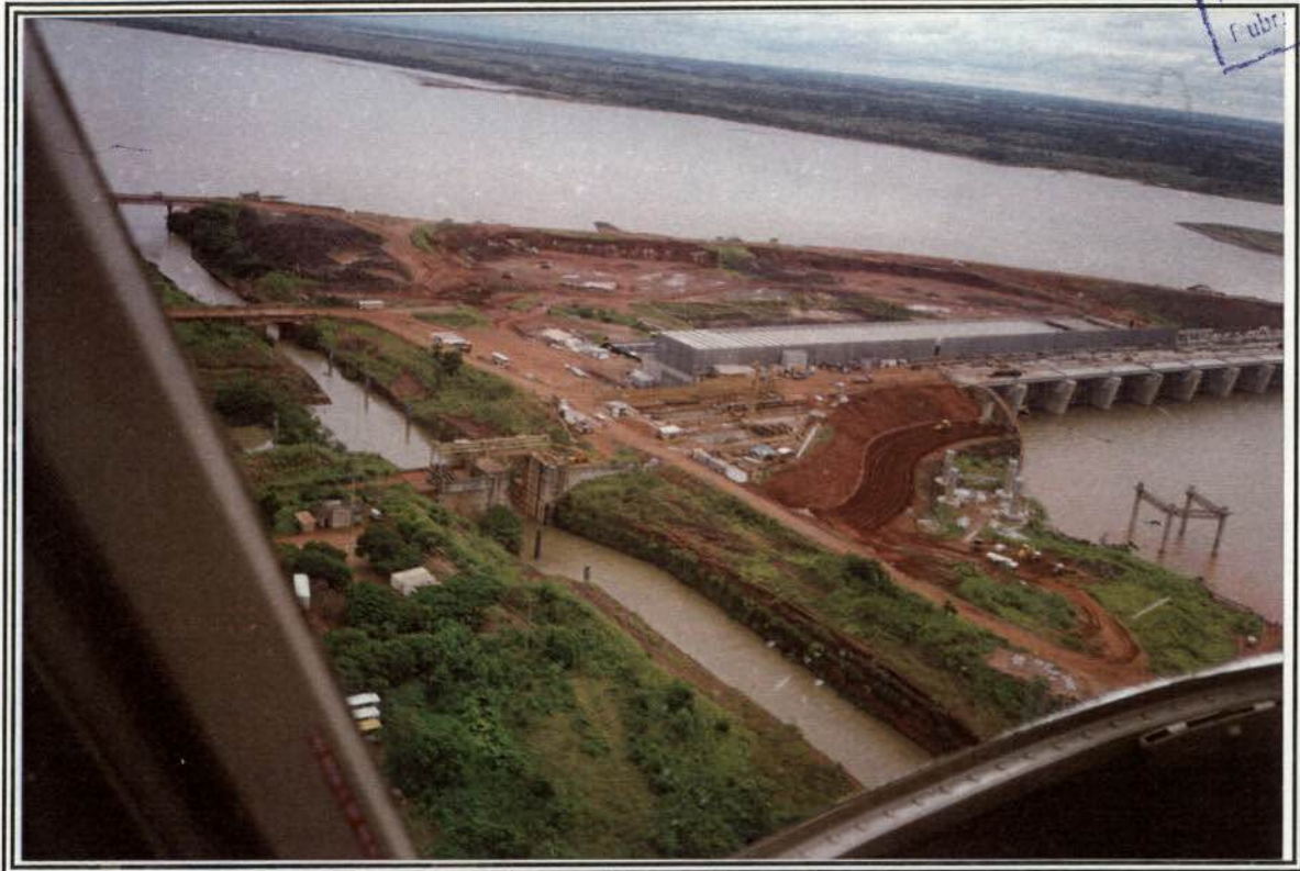
Foto 03. Vista da Eclusa provisória, detalhe da Barragem de Terra e Vertedouro (lado de São Paulo).
