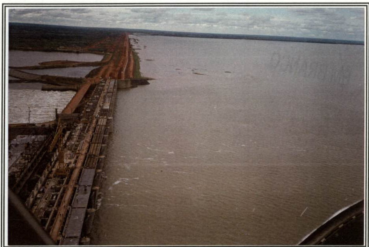
Foto 02. Vista de cima da barragem de concreto e do Vertedouro (lado de São Paulo) e Barragem de terra (lado Mato Grosso do Sul).
