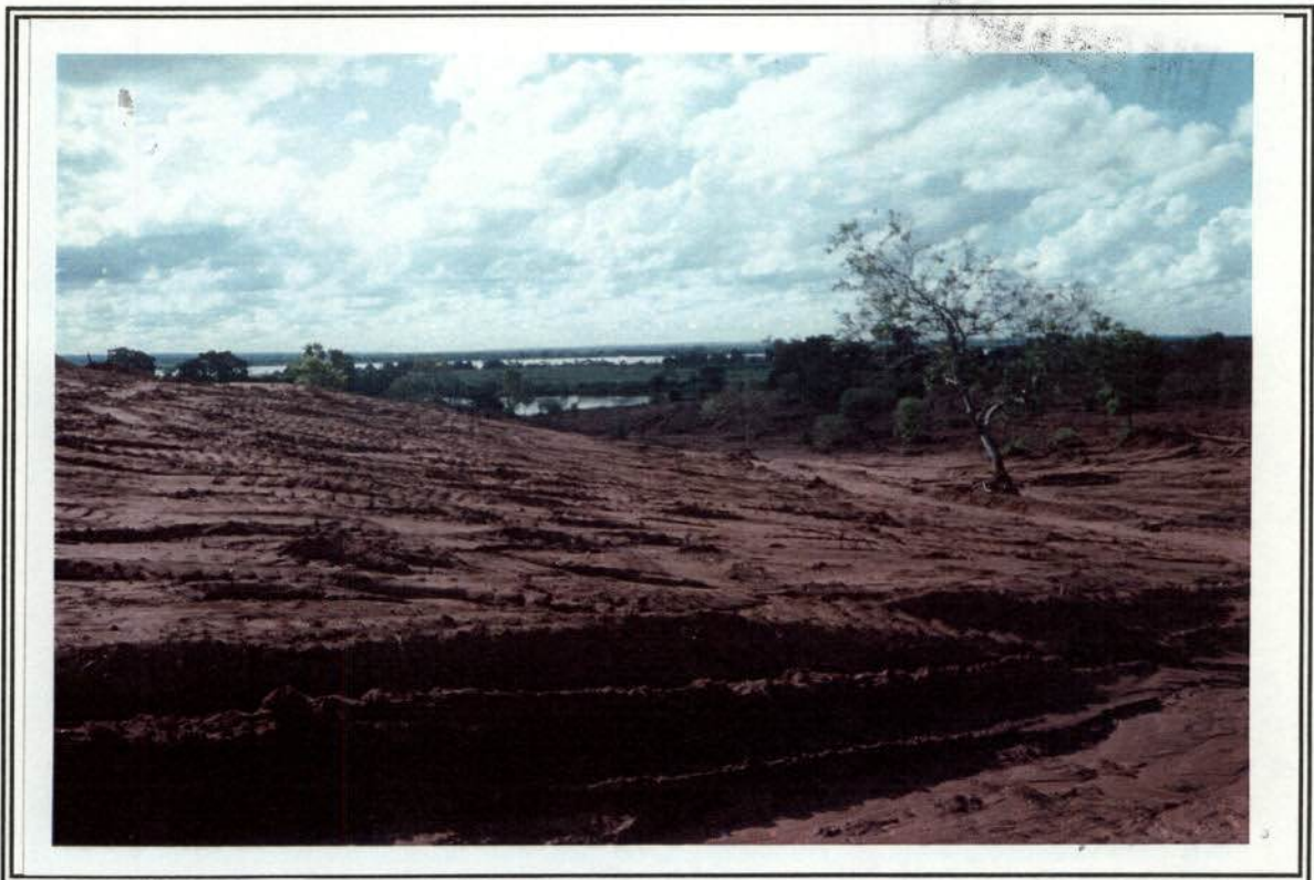
Foto 51. Área onde será o novo Parque Figueiral.
