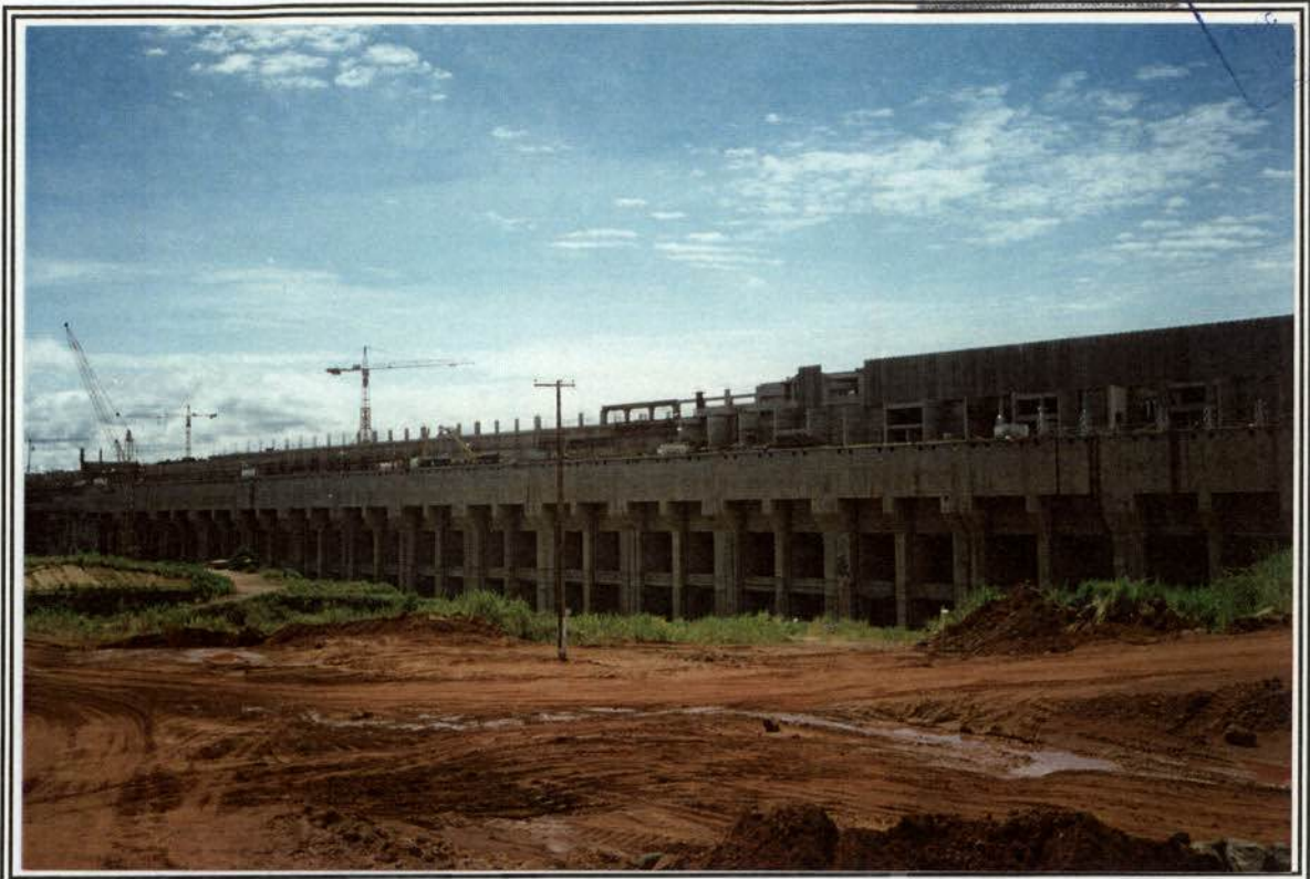
Foto 16. Vista da área escavada para escada de peixes.
