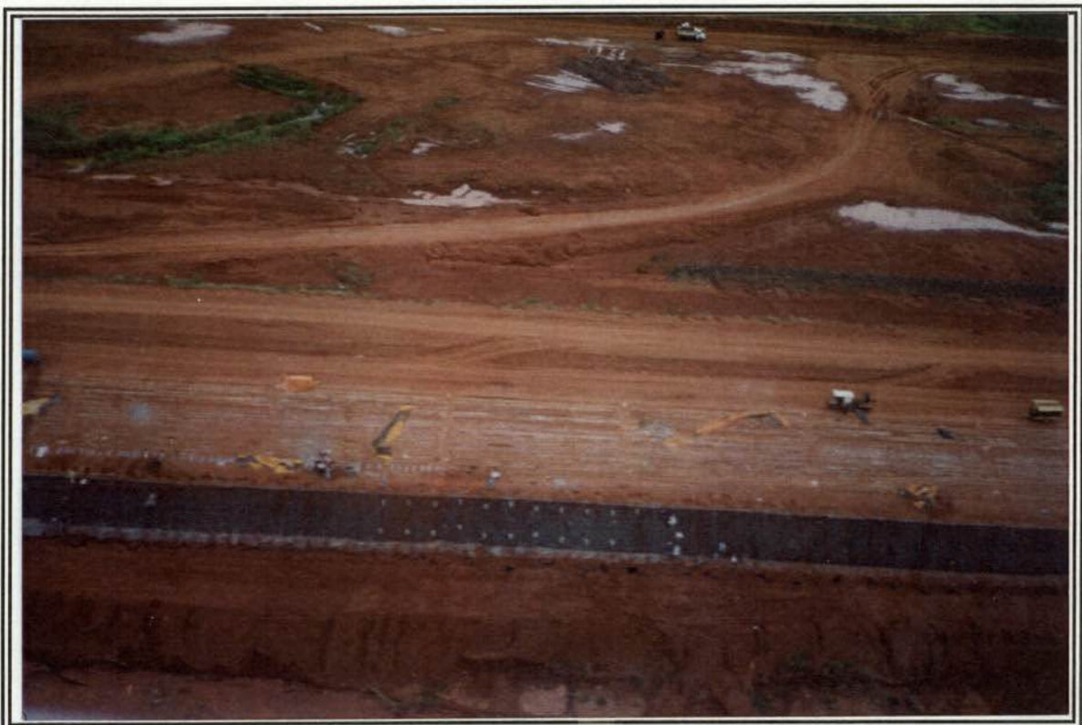
Foto 04. Detalhe de gabiões e tratamento dos taludes da Barragem de Terra.
