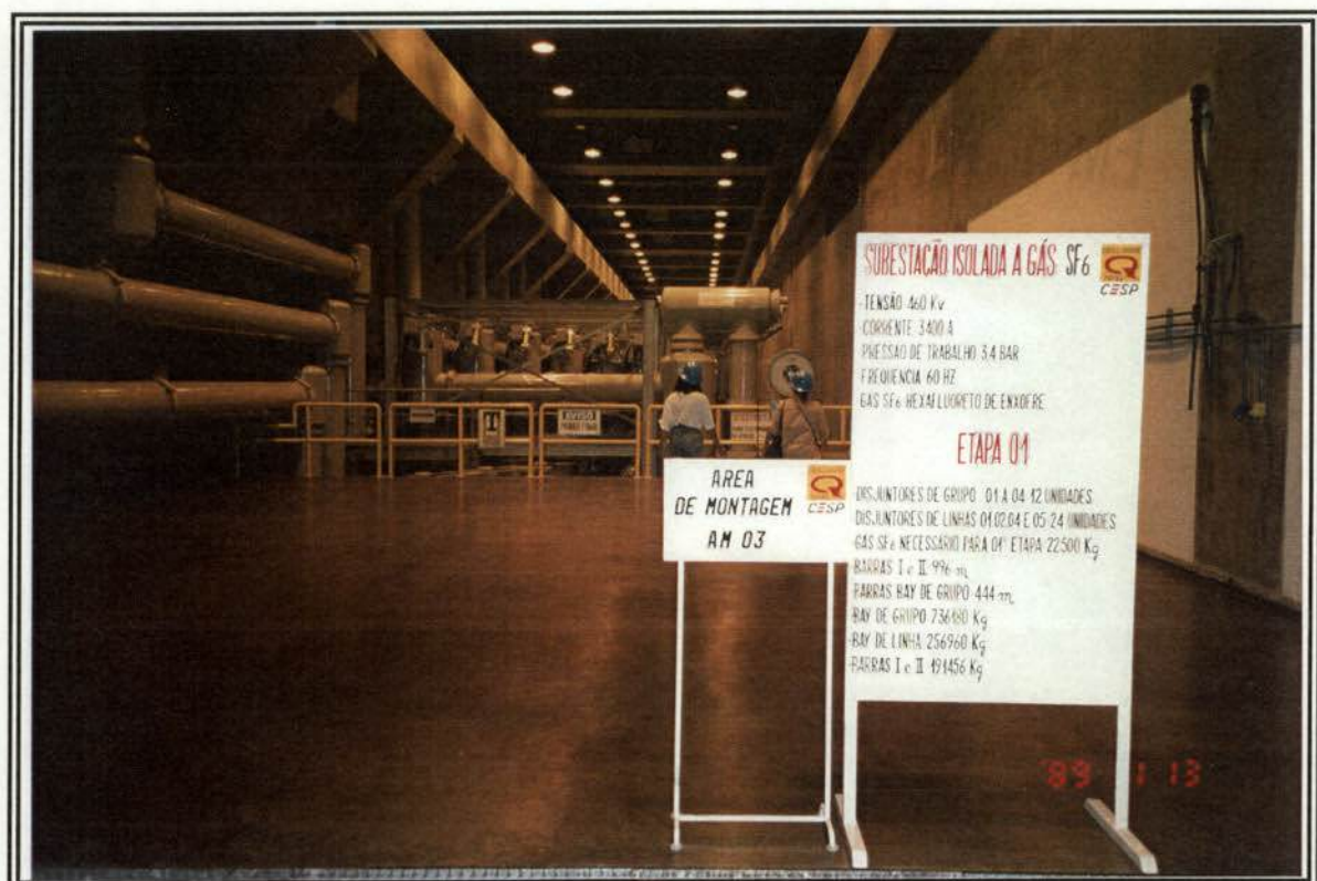
Foto 10. Área da Subestação confinada no corpo da Barragem.
