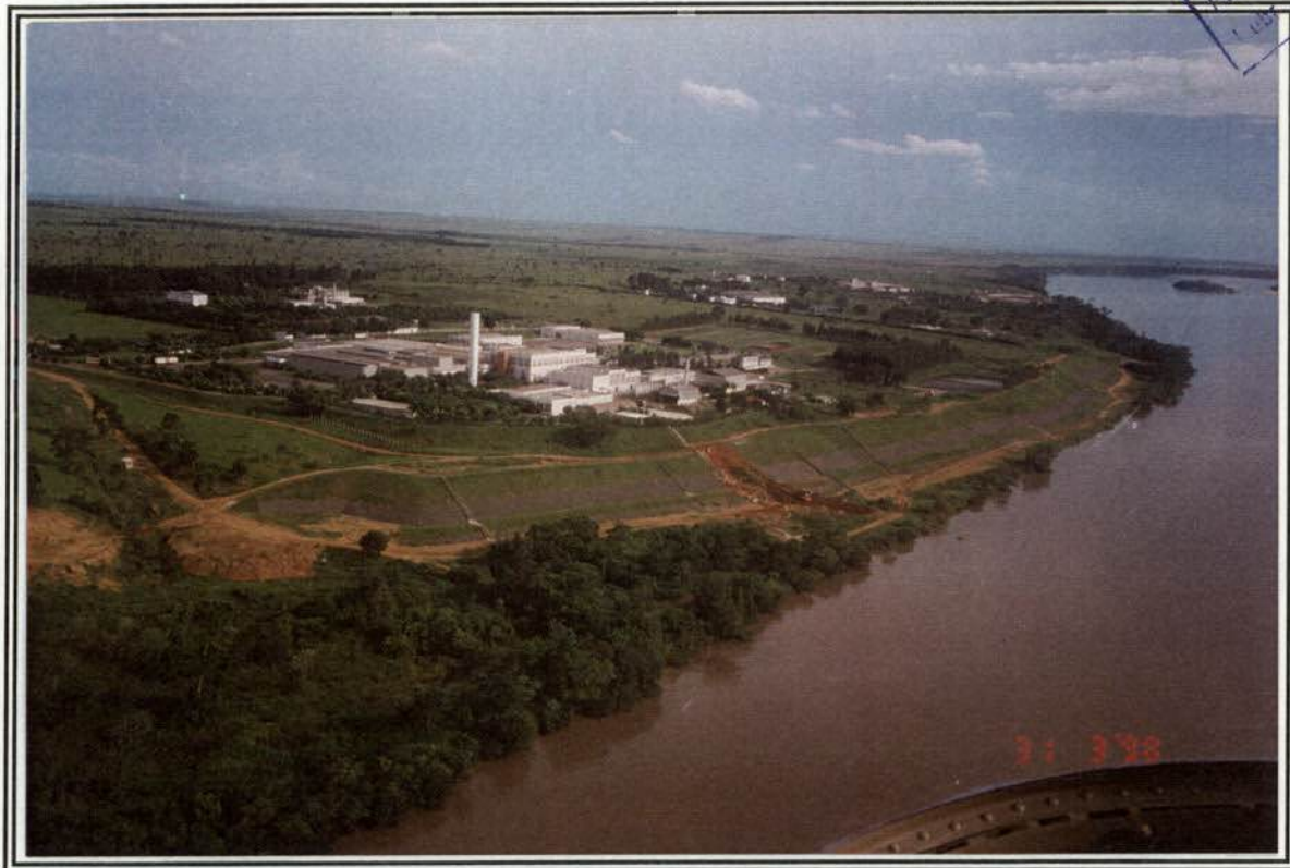
Foto 09. Vista Geral do Frigorífico Bourdon - com detalhe do emissário da ETE - detalhe do tratamento das encostas de Presidente Epitácio numa extensão de aproximadamente 11km, em gabiões e plantio de grama, da margem do futuro reservatório da UHE Porto Primavera.
