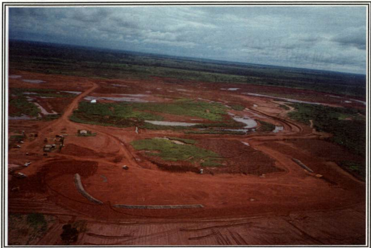
Foto 06. Área de empréstimo - Margem direita (lado do Mato Grosso do Sul).
