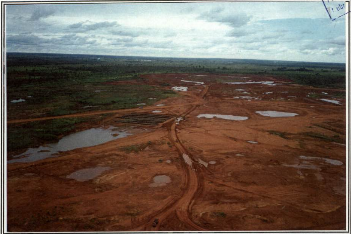
Foto 07. Área de empréstimo na Barragem (lado Mato Grosso do Sul).
