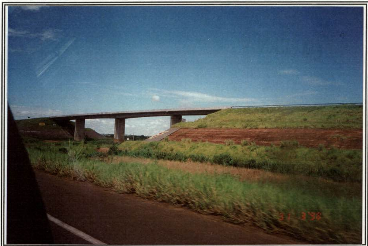
Foto 15. Complexo Maurício Joppert, detalhe da Ponte sobre o Canal de Navegação.
