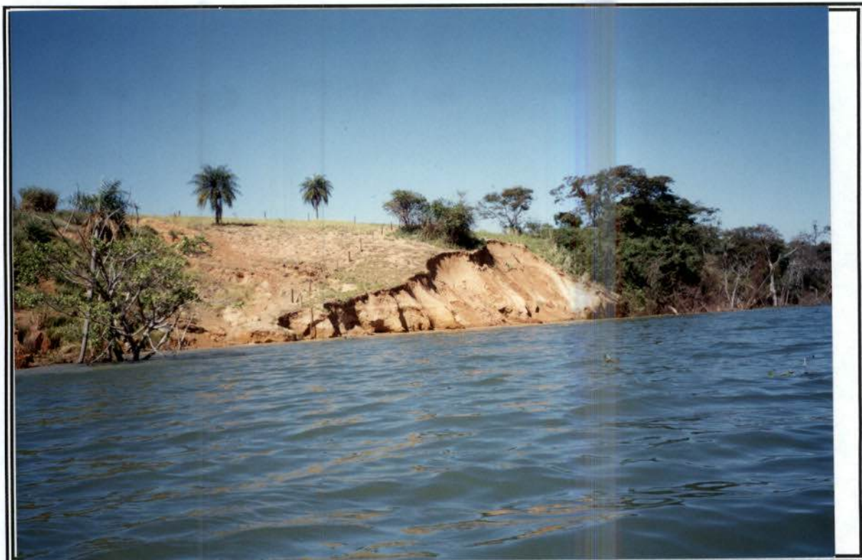
Escorregamento do talude das margens com a cunha de instabilidade provavelmente em função do desmatamento
