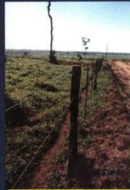
Construção de Cercas
