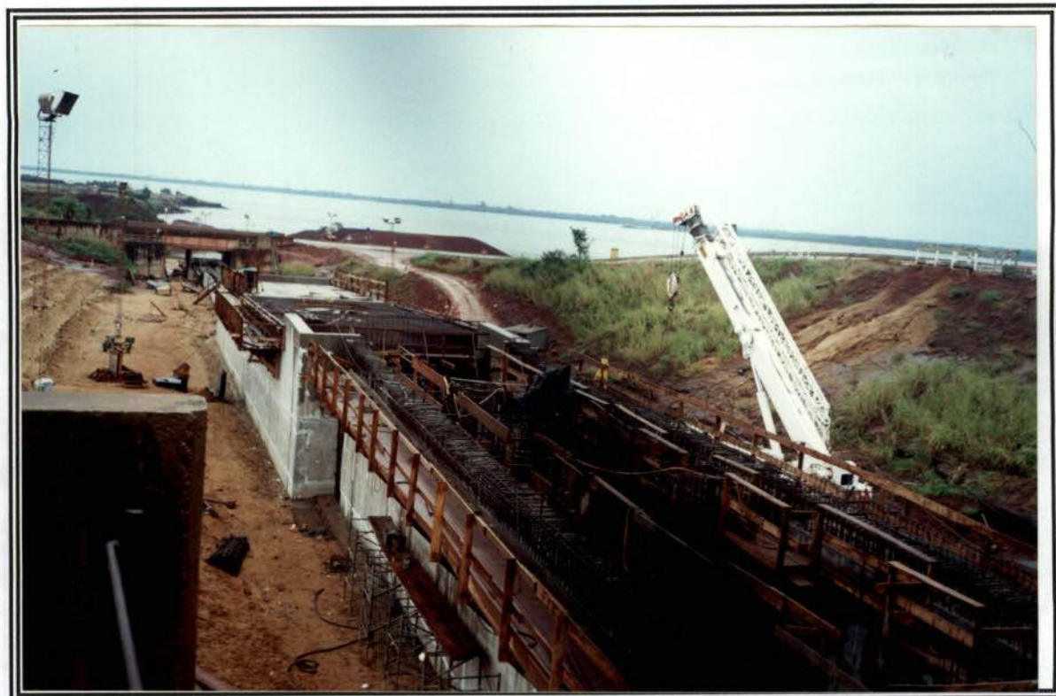
Foto 6 – detalhe de construção da escada de peixe.
