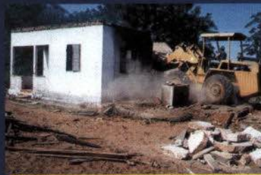
Demolição de Casa em Área a Ser Inundadas
