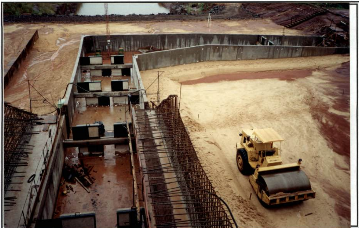
Foto 4 – detalhe da escada de peixe, em construção, na margem esquerda.
