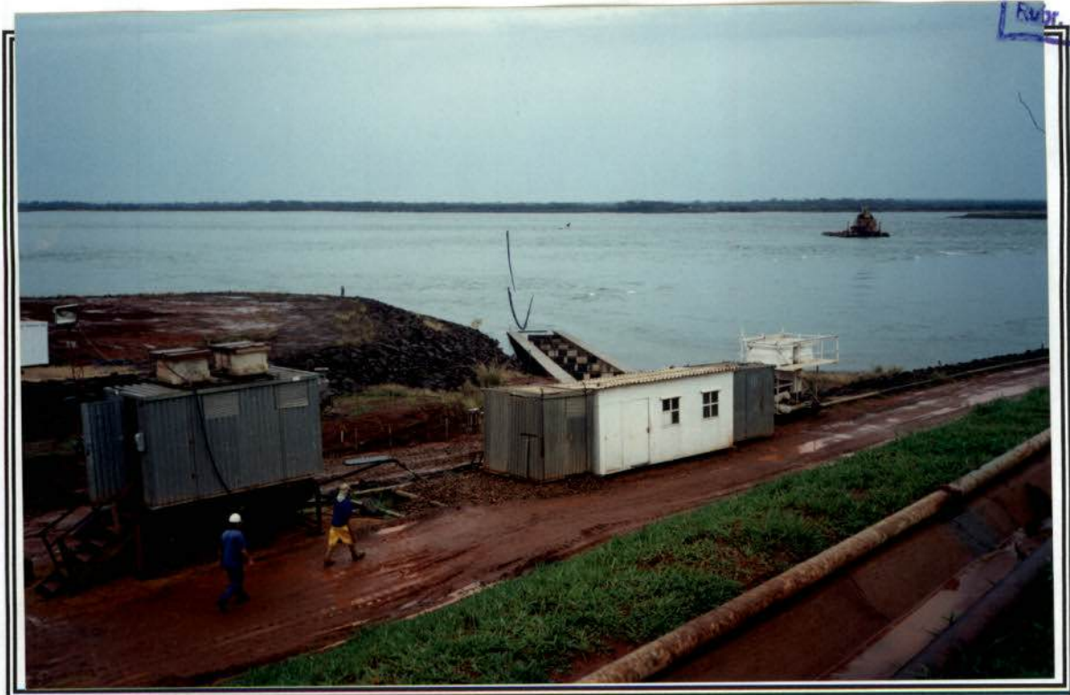
Foto 5 – local do canal de acesso a escada de peixe.
