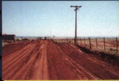
Construção e Recuperação de Estradas Internas
