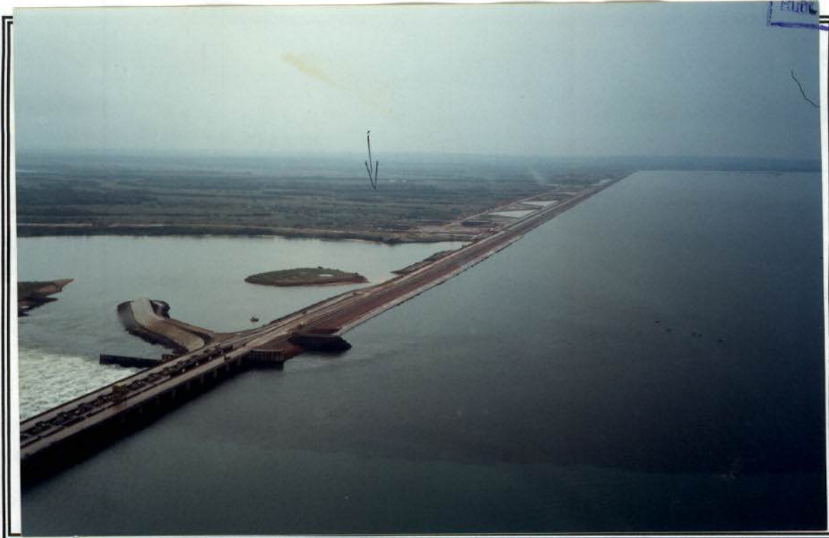
Foto 1 – Barragem de Porto Primavera - vista da margem esquerda para a margem direita do lado Mato Grosso do Sul. Ao fundo o rio Bahia que foi seccionado pela barragem.
