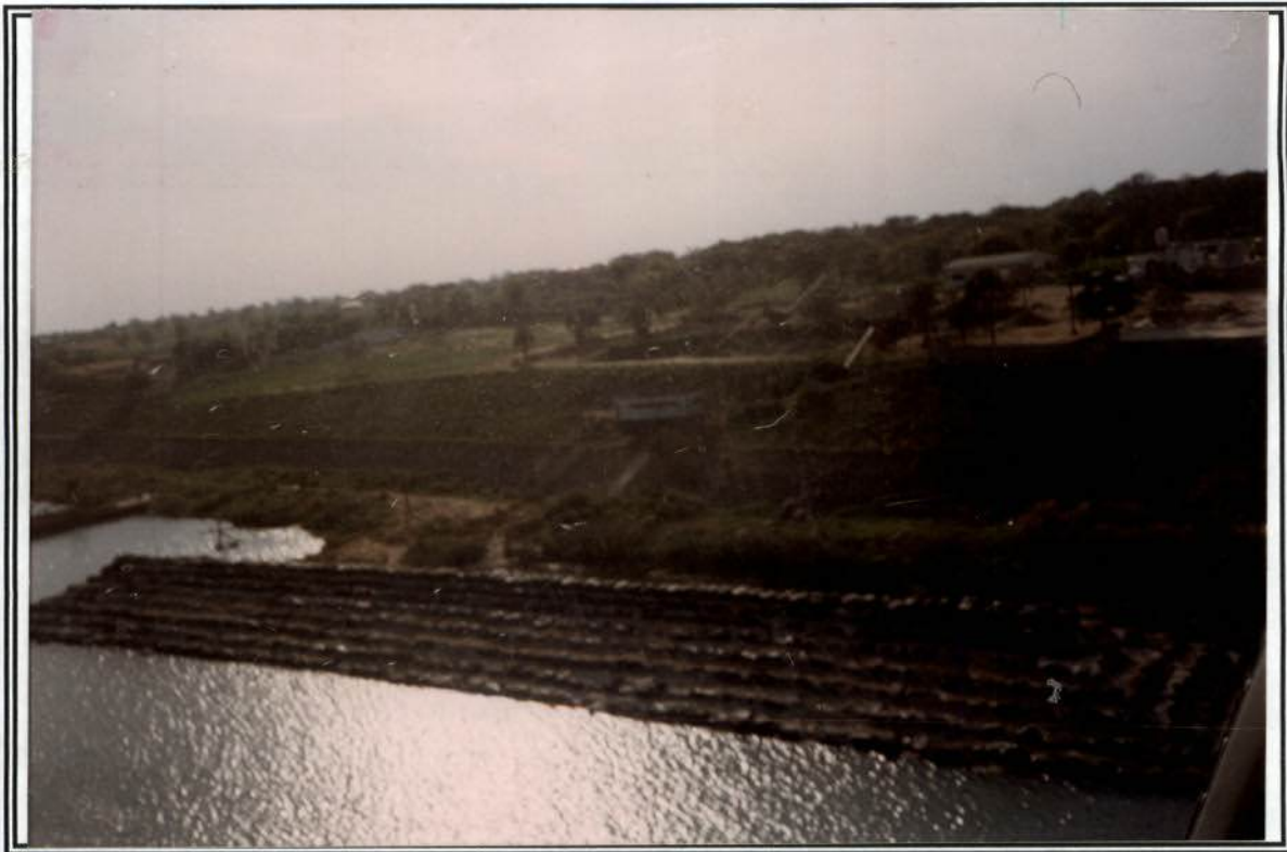
Foto 16 – detalhe da proteção construída pelos areieiros, acima do Porto de Areia, que será relocado em presidente Epitácio.
