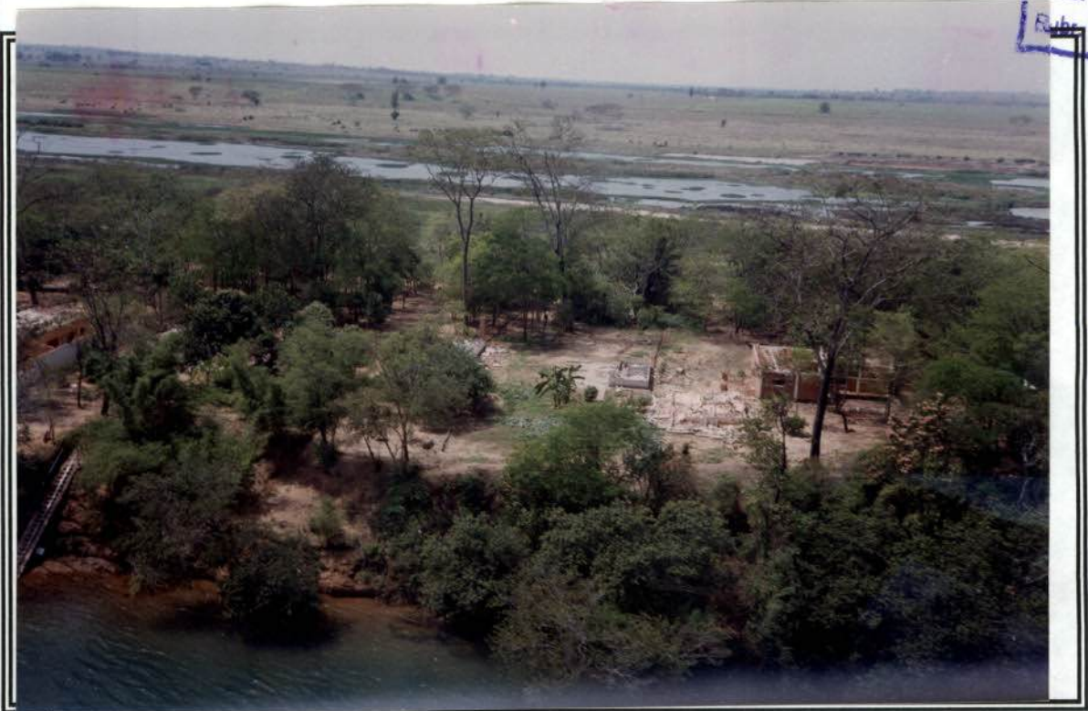
Foto 27 – Ranchos de Castilho – detalhe dos ranchos sendo demolidos.
