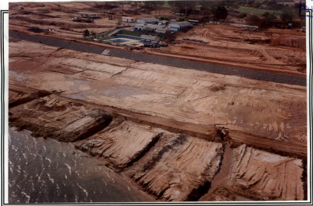
Foto 17 – construção da praia artificial.
