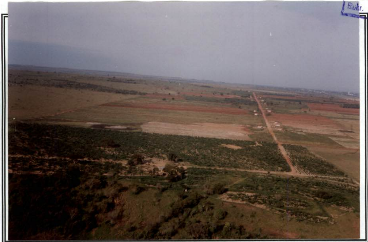
Foto 23 – detalhe do loteamento, com casas em construção.
