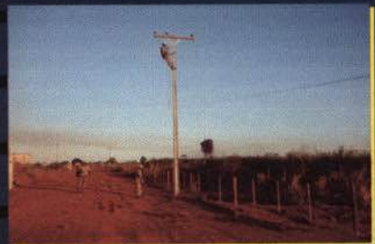
Instalação de Rede Elétrica
