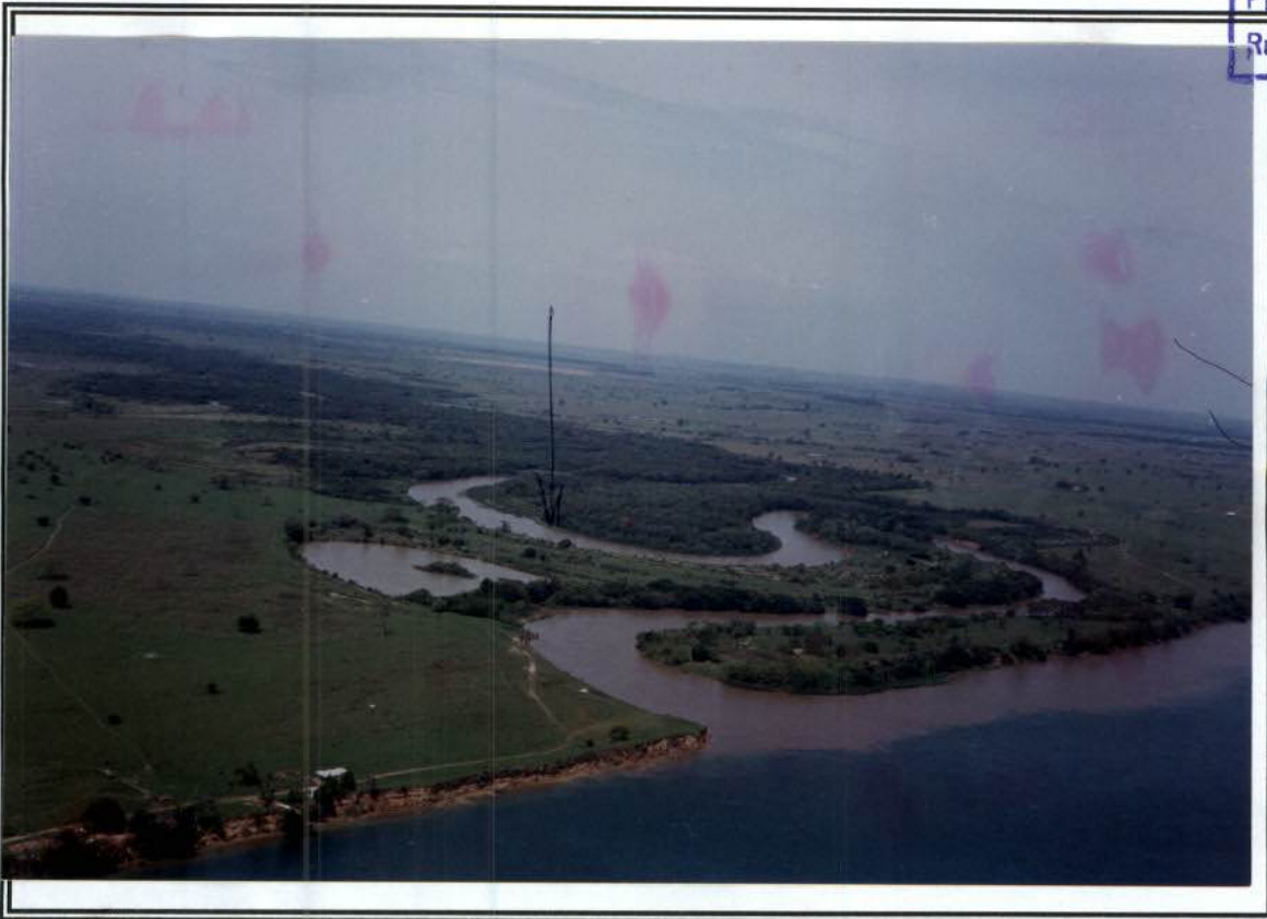
Rio Iguapei- na sua foz existe vegetação relativamente preservada, existência transporte de material em suspensão.
