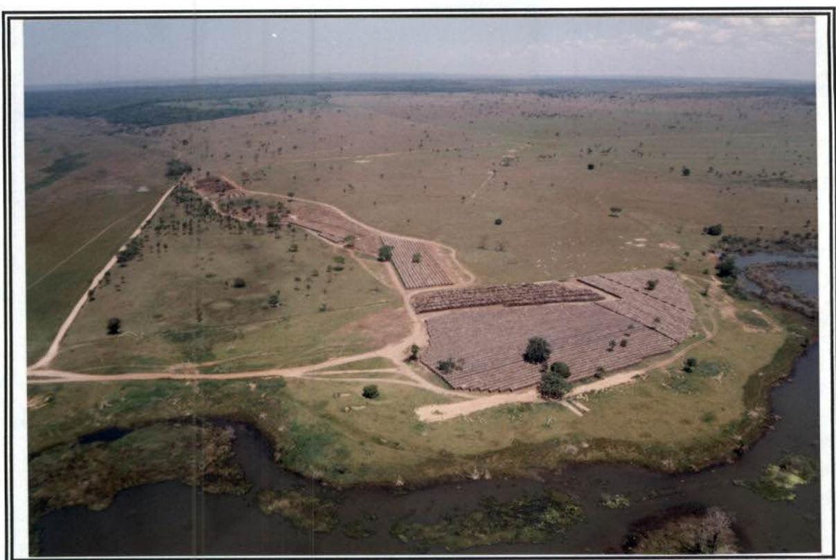
Material lenhoso do desmatamento das cotas 257/259 m.
