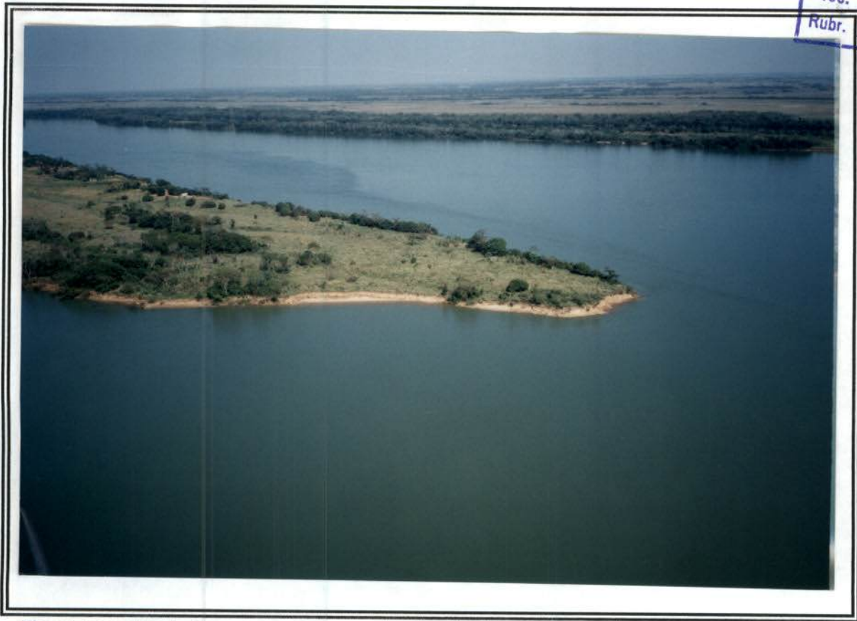
Ilha à jusante da barragem apresentando desbarrancamento por depleção.
