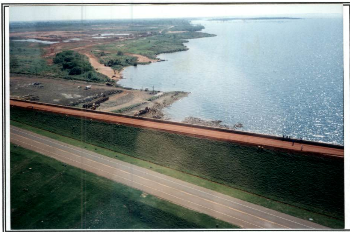
Retirada de material lenhoso no barramento
