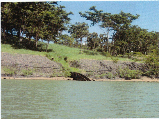
Foto 18 - Gabião protegendo área do DNIT (S 21° 46' 28.6", W 52°09'10.0")
