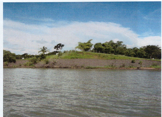
Foto 25 - Gabiões protegendo áreas da ALL
