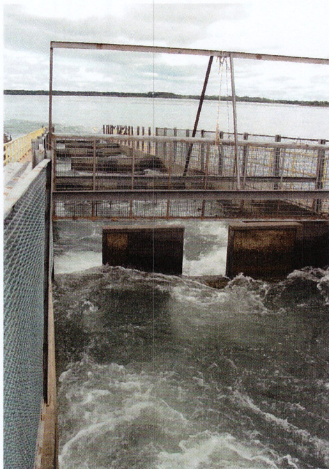
Fotos 59 e 60 - Escada de Peixes da UHE Sergio Motta (Porto Primavera). Na imagem da esquerda está mostrado o terço inicial da estrutura, em uma visada para jusante. Na imagem da direita, tirada do mesmo ponto mas com visada para montante. Notar em ambas imagens a configuração do sistema, com as aletas transversais e a profusão da água nos degraus e comportas inferiores.
