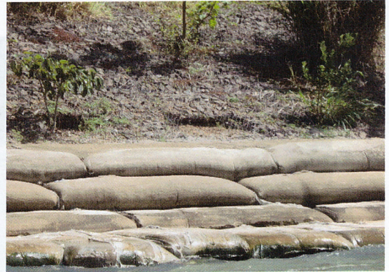
Foto 12 - Gabiões depredados para o plantio de árvores
