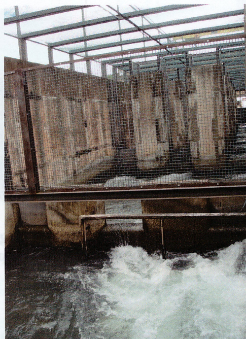
Fotos 63 e 64 - Escada de peixes da UHE Sergio Motta (Porto Primavera). Na imagem da direita, cardume de Piaractus mesopotamicus (pacu) se preparando para a continuação da migração ascendente.
