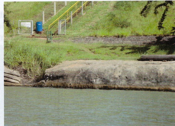
Foto 21 - Proteção de concreto jateado protegendo área da SABESP (S 21° 45' 4.7", W 52°05'58.9")
