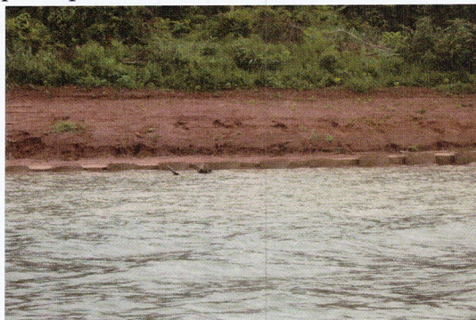
Fotos 5 e 6 - Experimentos para estabilização das encostas (estrutura de blocos cilíndricos a esquerda e estrutura de palhiçada a direita).
