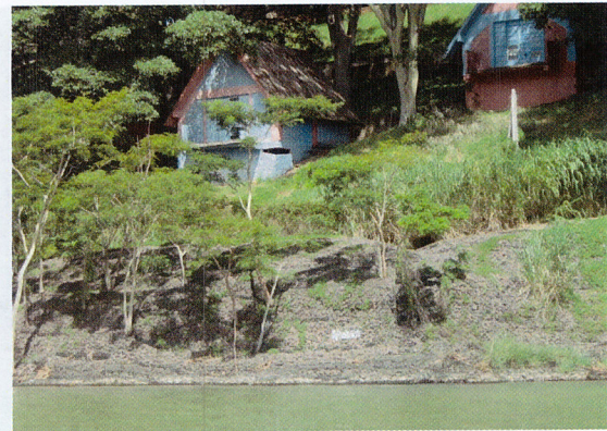
Foto 19 - Gabião protegendo área do clube Belvedere (S 21° 46' 18.9", W 52°09'2.6")
