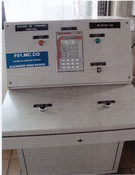
Foto 57 - direita. Sistema de controle eletro-mecânico do elevador de peixes da UHE Engenheiro Sérgio Motta (Porto Primavera). Foto 58, esquerda. Escada de peixes da UHE Sergio Motta (Porto Primavera). Registro da entrada no sistema, imediatamente a jusante da barragem da UHE.
