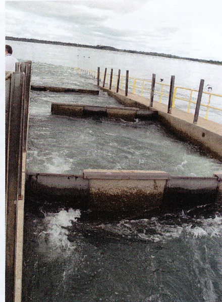
Foto 57 - direita. Sistema de controle eletro-mecânico do elevador de peixes da UHE Engenheiro Sérgio Motta (Porto Primavera). Foto 58, esquerda. Escada de peixes da UHE Sergio Motta (Porto Primavera). Registro da entrada no sistema, imediatamente a jusante da barragem da UHE.
