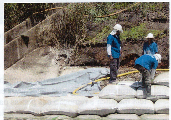
Foto 15 - Obras em andamento
