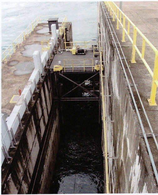
Fotos 55 e 56 - Elevador de peixes da UHE Engenheiro Sergio Motta (Porto Primavera). No registro da esquerda, é possível ver a parte de montante do elevador. Na direita, a entrada da estrutura, na jusante.
