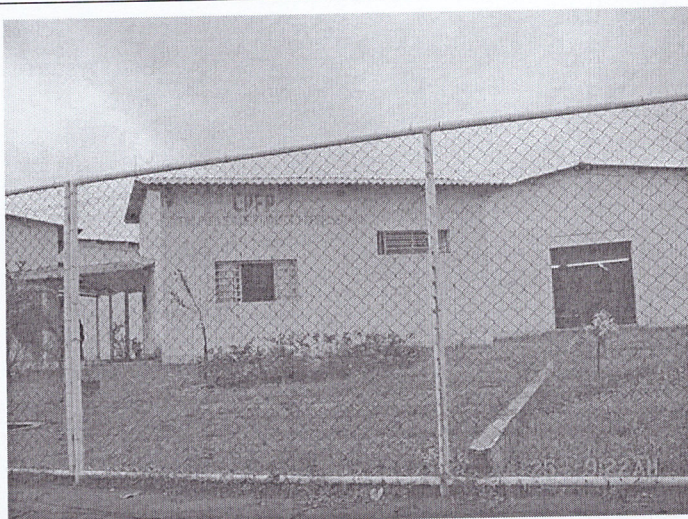
Centro de treinamento profissional em Panorama construído pela CESP
