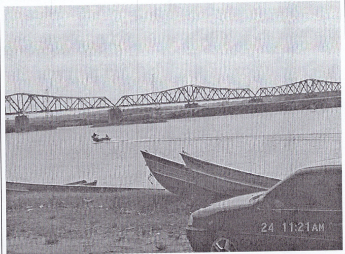
Ponte Ferroviária sobre o remanso da UHE Porto Primavera
