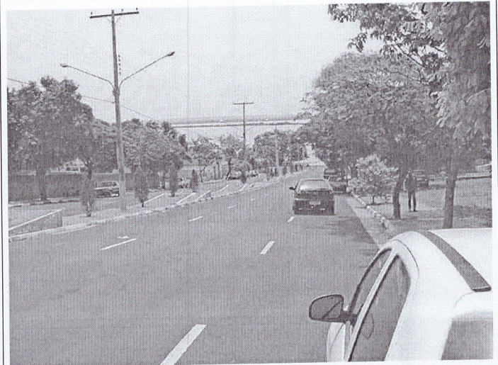
Via pública construída em função da relocação da área urbana
