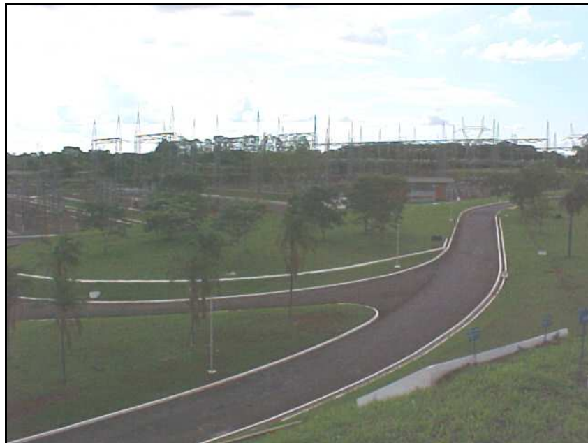
Foto 12 – Vista da Subestação Principal de 138KV (FONTE: MRS).
