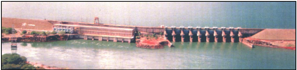
Foto 3 – Vista da Usina e Barragem de Porto Colômbia (FONTE: FURNAS).
