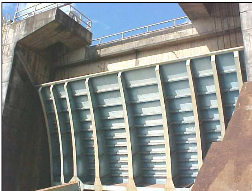
Foto 6 – Vista da comporta do vertedouro (FONTE: MRS).
