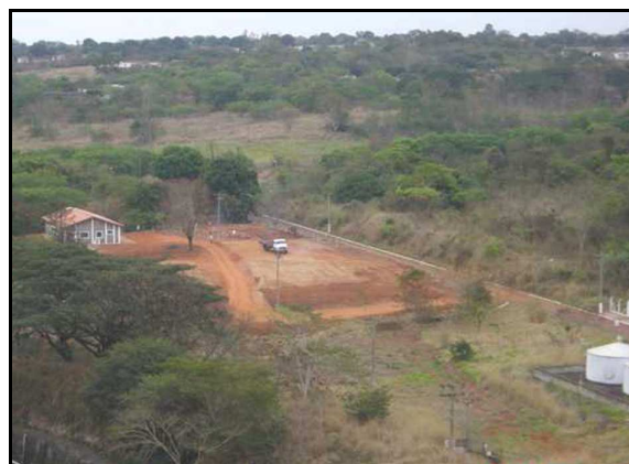
Foto 25 – Vista futura área do horto florestal da UHE Marimbondo (FONTE: MRS).
