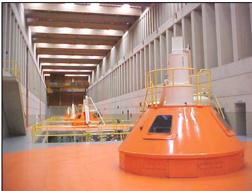
Foto 11 – Vista do piso dos geradores, com a ponte rolante no fundo (FONTE: MRS).
