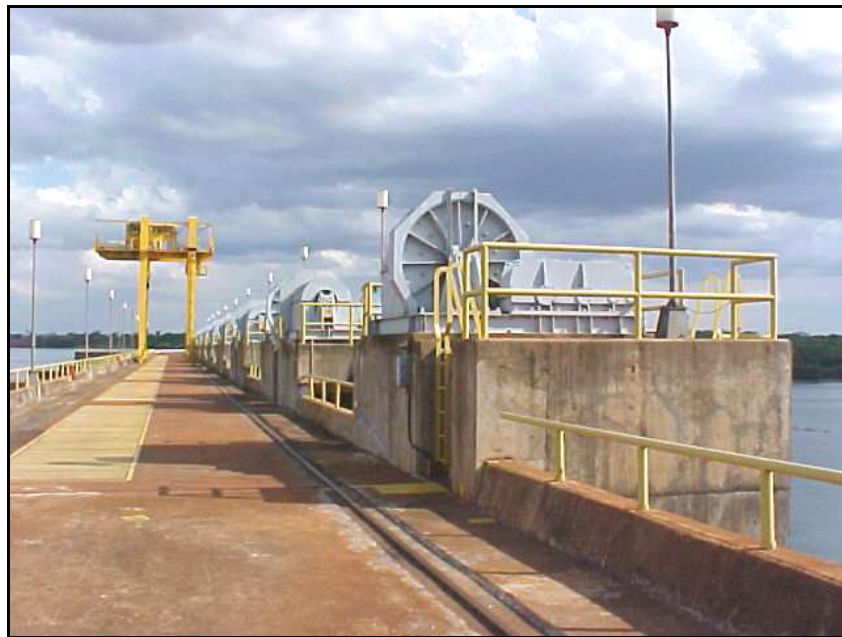
Foto 4 – Pórtico dos vertedouros (FONTE: MRS).
