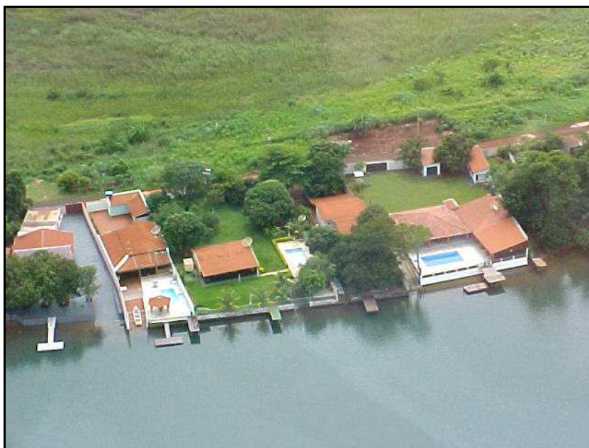
Foto 22 – Área de ocupação das margens em detalhe (FONTE: MRS).
