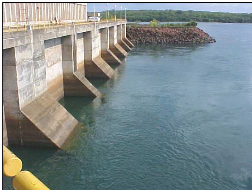
Foto 8 – Vista do canal de fuga da usina (FONTE: MRS).
