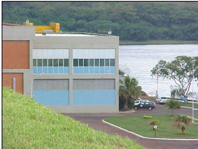
Foto 7 – Vista da casa de força da UHE Porto Colômbia (FONTE: MRS).
