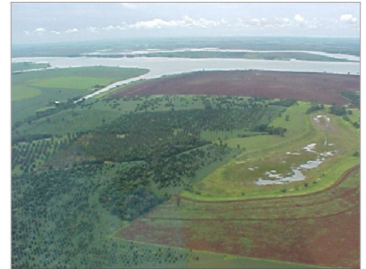
Foto 11 - Vista da margem do reservatório
