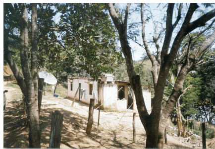
Residência no trecho de vazão reduzida – ES
