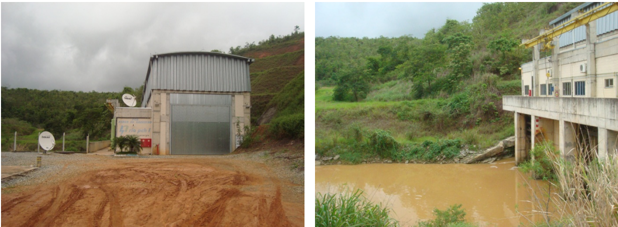
Figura 3.2. PCH Pedra do Garrafão - Casa de Força
