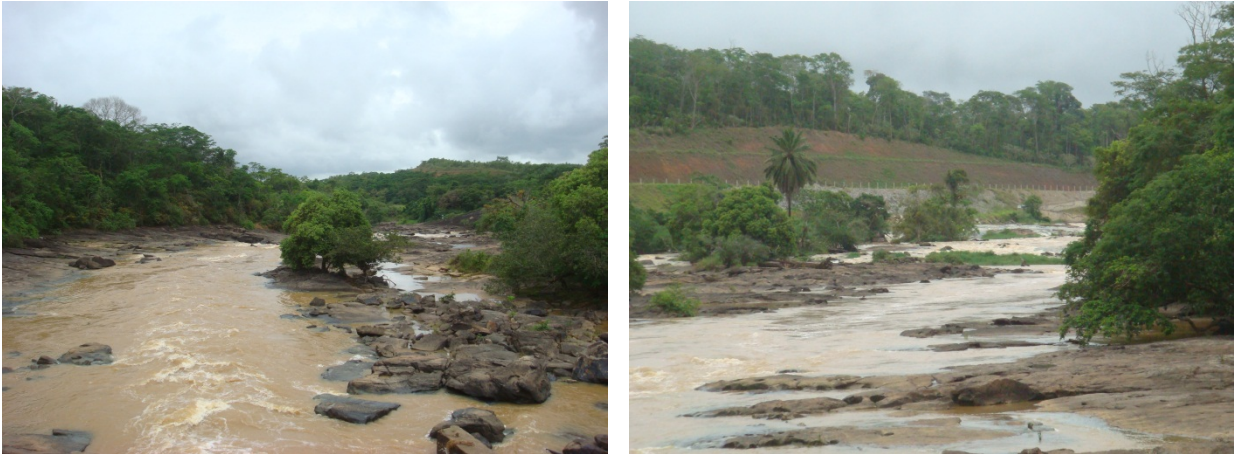
Figura 3.1. PCH Pedra do Garrafão – Trecho de Vazão Reduzida
