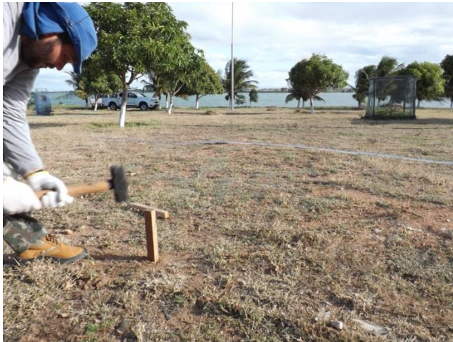
Foto 27. Estaca sendo cravada em um dos vértices do perímetro, ao fundo visualização da área
