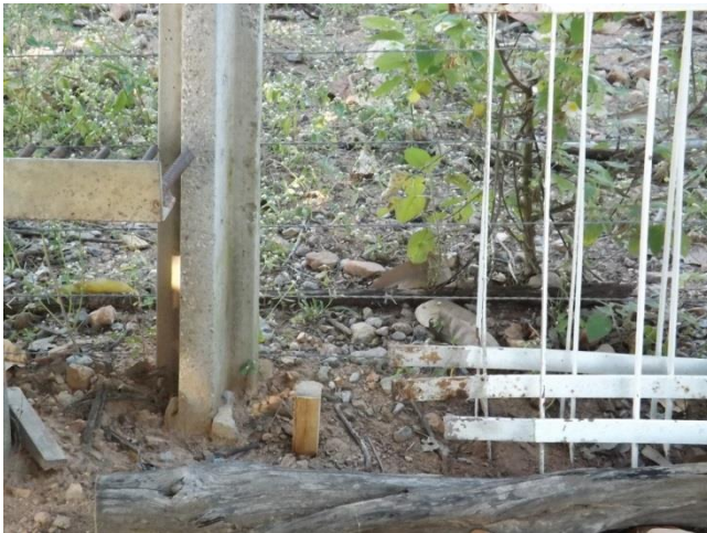
Foto 58. Estaca cravada em um dos vértices do perímetro
