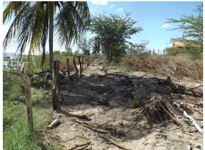
Foto 72. Construção de cerca e supressão de vegetação na área avaliada
