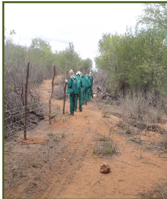
Foto 115. Construção de cerca área 06 em março de 2012 (Flávio Santana).
