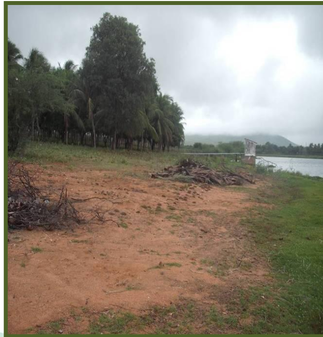
Foto 06. Aspecto geral em Julho de 2011, (Flávio Santana).
