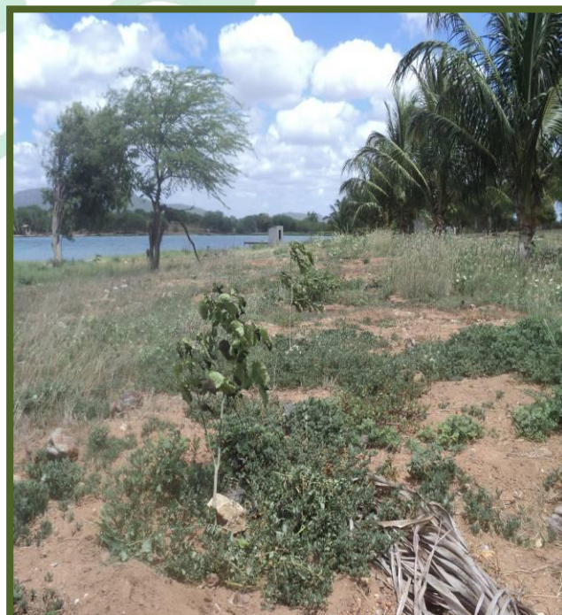
Foto 60. Enrocamento de pedra Março de 2012. , (Flávio Santana).
