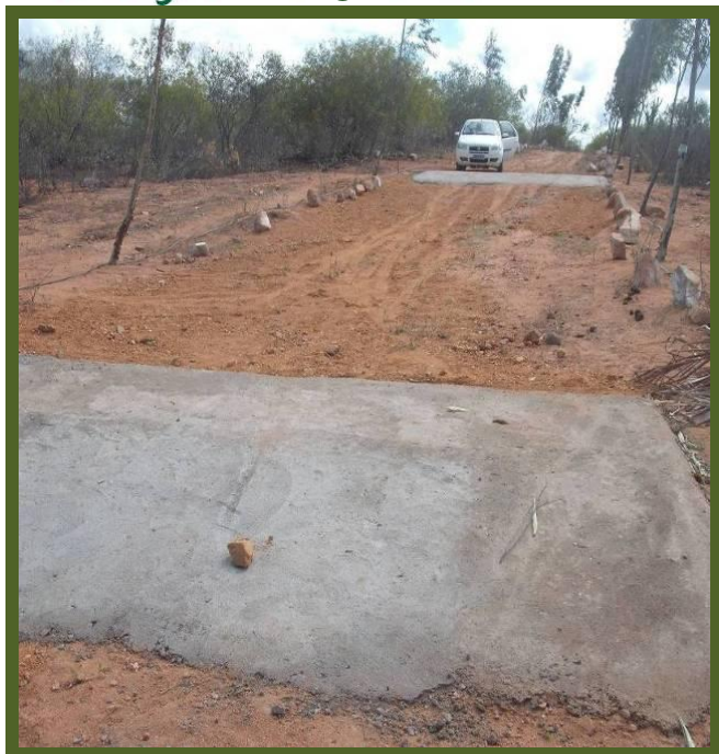
Foto 96 – Construção de barreiras transversais em setembro de 2011 (Flávio Santana)
