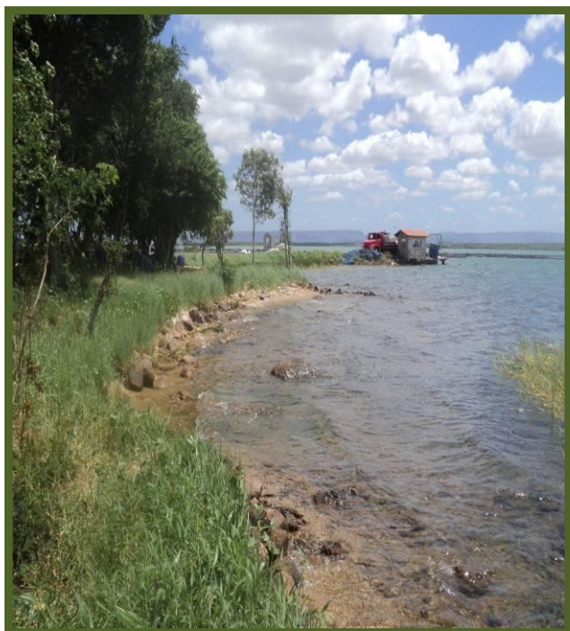
Foto 57. Enrocamento de pedra Março de 2012. , (Flávio Santana)
