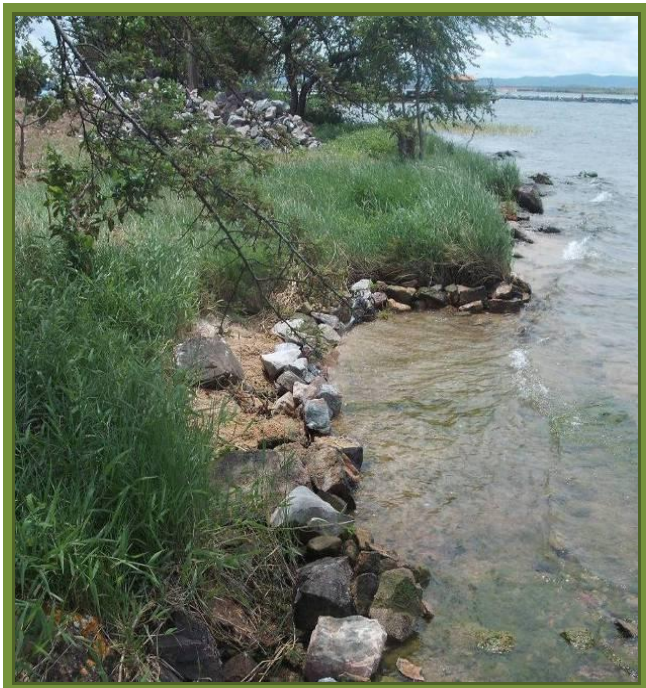
Foto 53. Enrocamento de pedra em Setembro de 2011. , (Flávio Santana)
