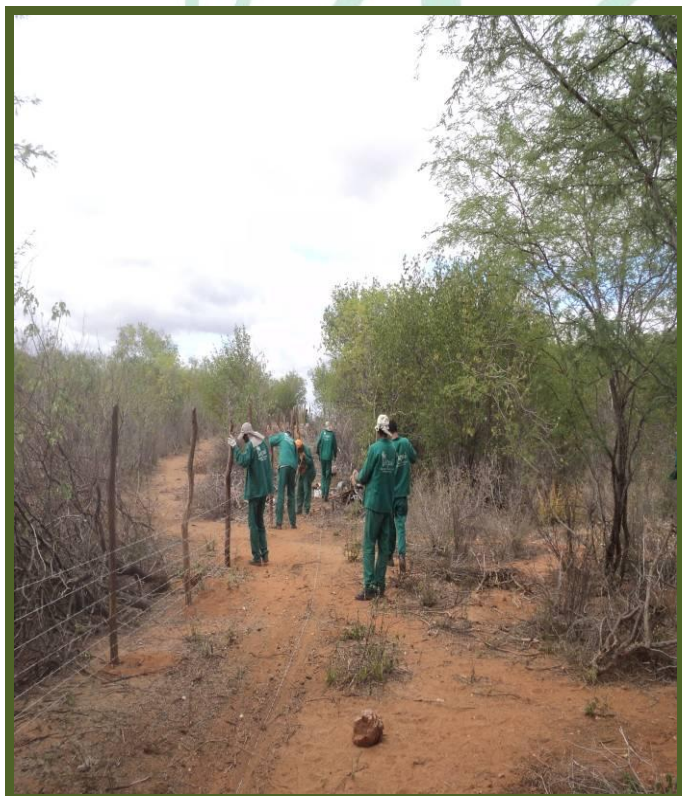
Foto116 – Construção de cerca área 06 em março de 2012 (Flávio Santana).
