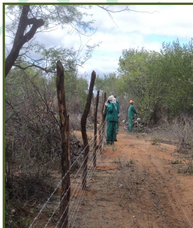
Foto 117 – Construção de cerca área 06 em março de 2012 (Flávio Santana).
