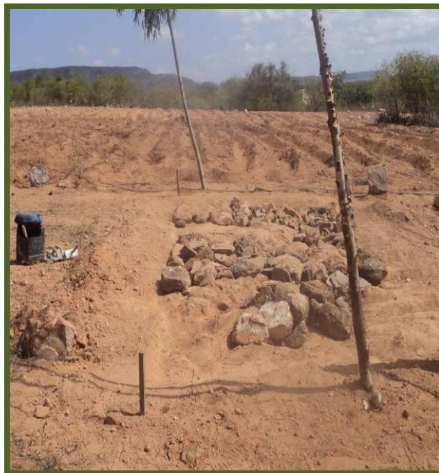
Foto 97 – Construção de barreiras transversais em setembro de 2011 (Flávio Santana)
