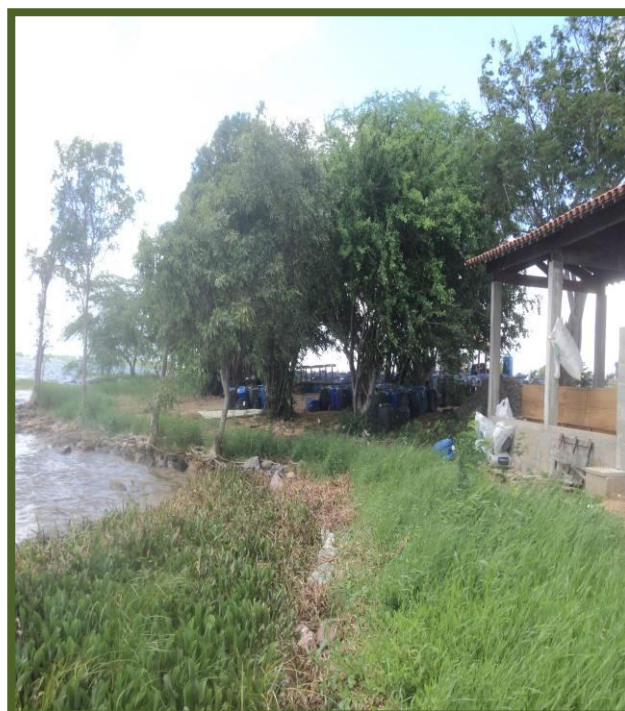
Foto 58. Enrocamento de pedra Março de 2012. , (Flávio Santana).
