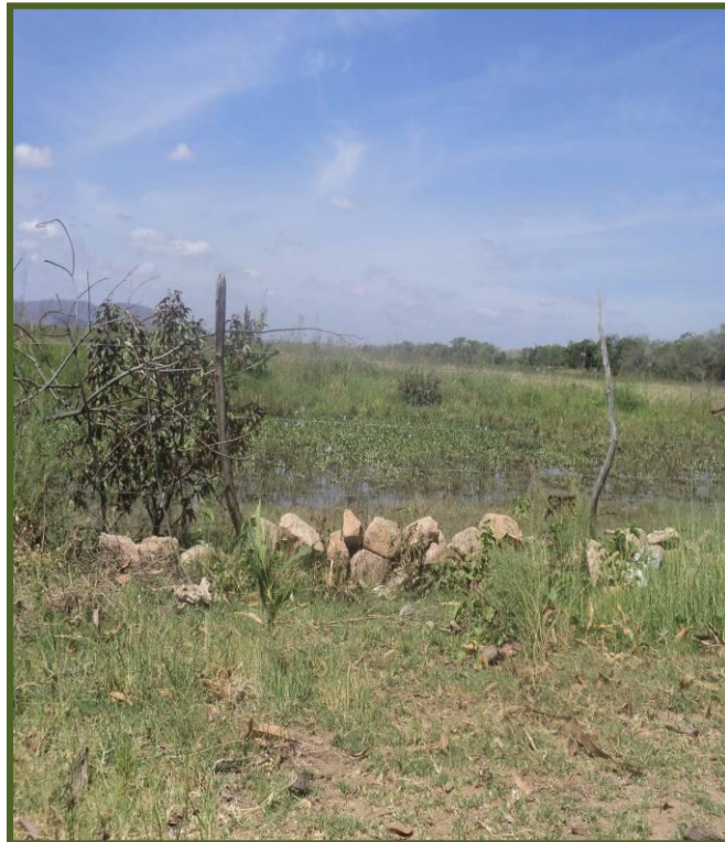
Foto 52. Enrocamento de pedra e gramínea em novembro de 2012, (Flávio Santana).
