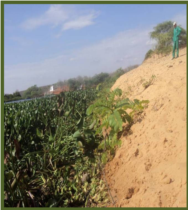
Foto 33 - Aspecto geral da área em novembro de 2012, (Flávio Santana).
