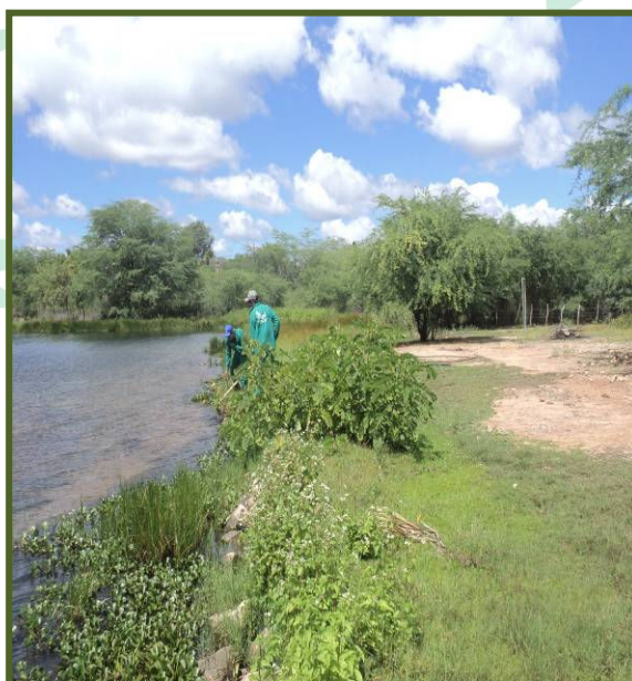
Foto 78 – Reconformação de enrocamento setembro de 2013, (Flávio Santana)
