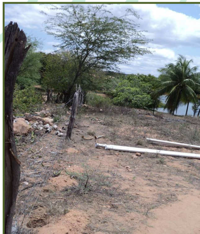
Foto 17. Aspecto geral da área 03 em Novembro de 2012, (Flávio Santana)
